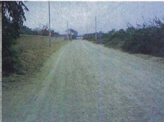
Figura N°2.3: Camino a nivel de afirmado
