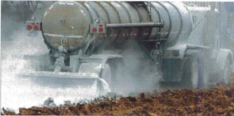
Figura N°3.2: Colocación de cal para estabilización de vía.
