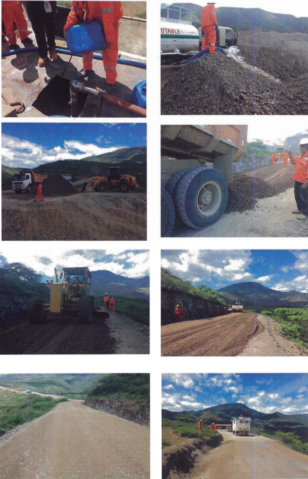
Figura N°4.7: Panel fotográfico del proceso constructivo
