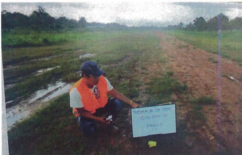
Figura N°5.13: Estado actual de la pista del aeródromo de San Lorenzo
