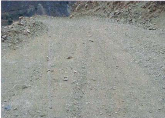
Figura N°2.2: Camino de tierra.
