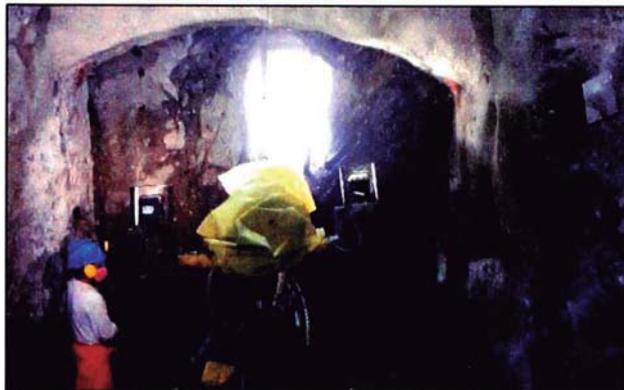
Figura 2.6 Concreto lanzado para sostenimiento sobre cercha metálica
