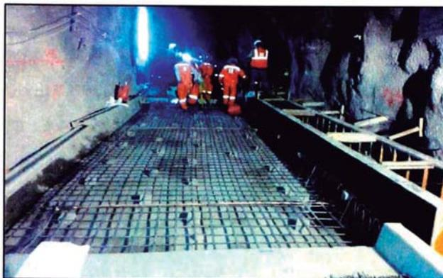
Figura 3.6 Solera en Túnel de Aire y Cables
