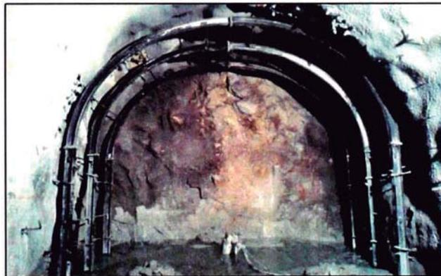
*Figura 2.18 Control de Conformidad Cerchas Metálicas*
