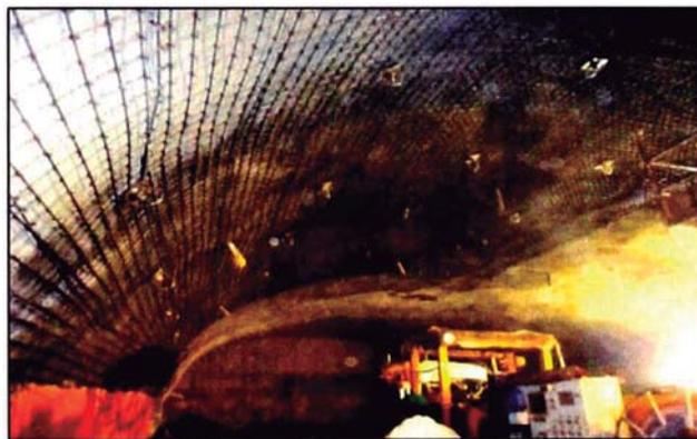
*Figura 2.15 Malla electrosoldada colocada en Casa de Máquinas*
