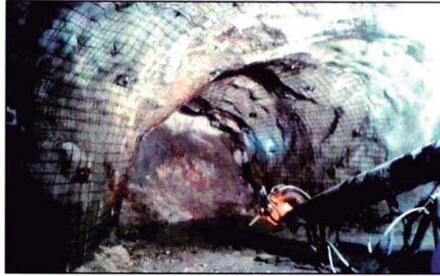
Figura 2.16 Control de conformidad malla electrosoldada
