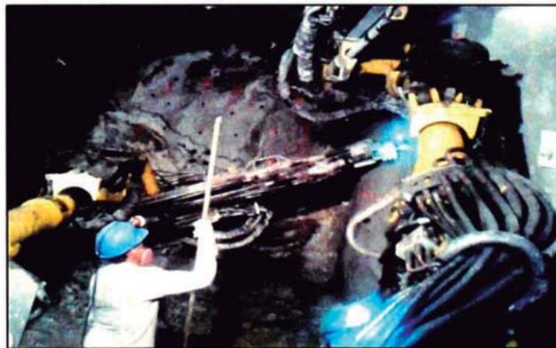
Figura 2.13 Control de Producción en Pernos de Anclaje
