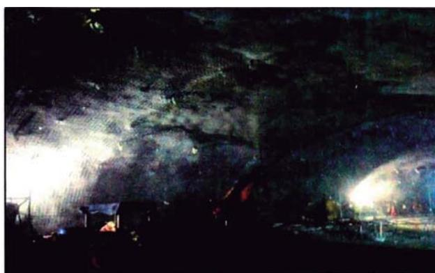
Figura 2.3 Aplicación de concreto lanzado en Túnel y Caverna
