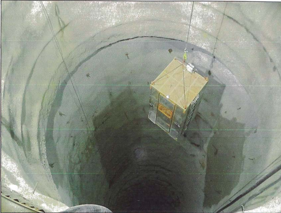
Figura N° 12.- Ejecución del conducto forzado.
