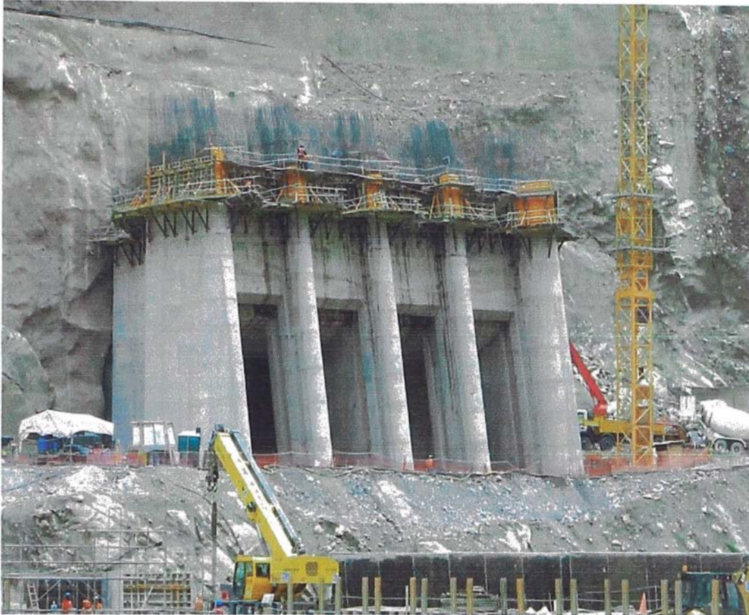
Figura N° 7.- Construcción de la obra de toma.
