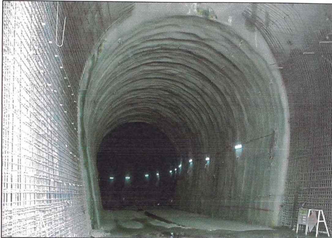
Figura N° 9.- Construcción del túnel de conducción
