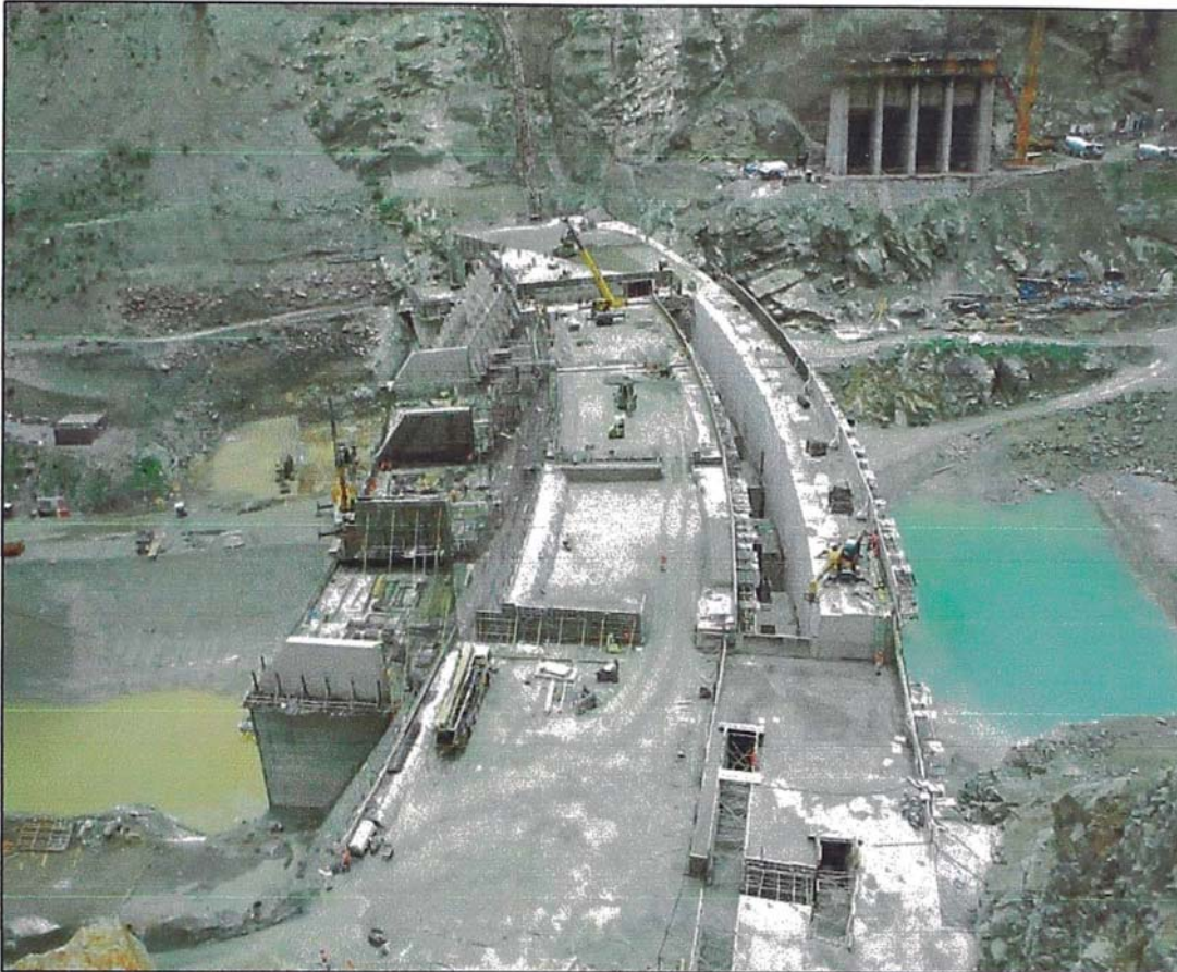
Figura N° 5.- Construcción de la Presa.
