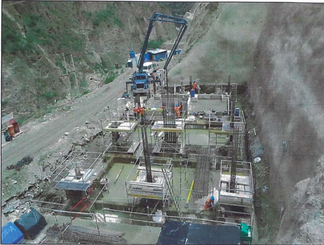
Figura N° 13.- Ejecución de los trabajos en la subestación.
