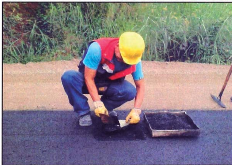
Figura N°5.7: Muestreo de mezcla asfáltica in situ para ensayos en Laboratorio.
