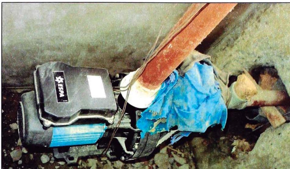
*Figura 2.9 Bomba Espa (1HP, Q=2 lt/sg) para recircular el agua*
