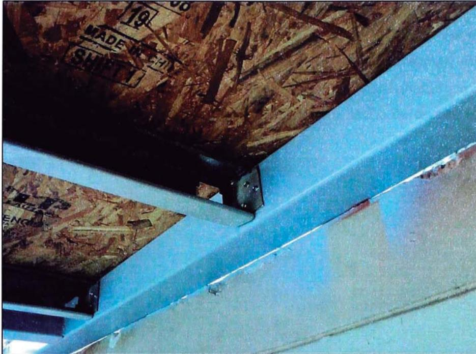
*Figura 2.16 Se muestra el forrado de cobertura con planchas OSB, también se aprecia la unión de viguetas a la viga de acero.*
