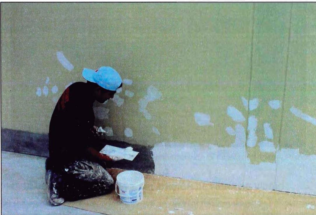
*Figura 2.21 Se aprecia la aplicación del aditivo anti salitre después de haberse resanado la parte baja de muro afectada.*
