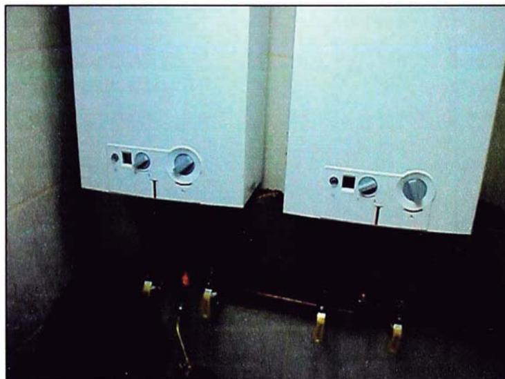
*Figura 2.12 Instalación de Calentadores Bosch a la salida de electrobomba Espa*
