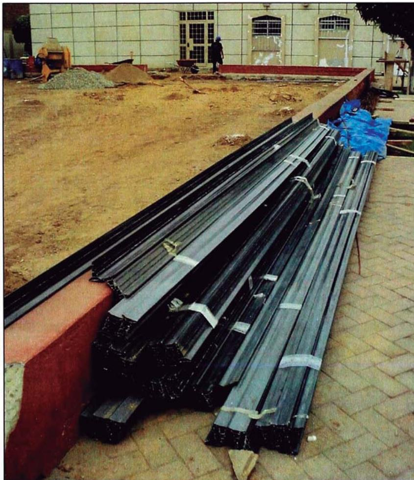
*Figura 2.6 Regla Junta-Tofollo que se usó en la losa de la capilla Palao*
