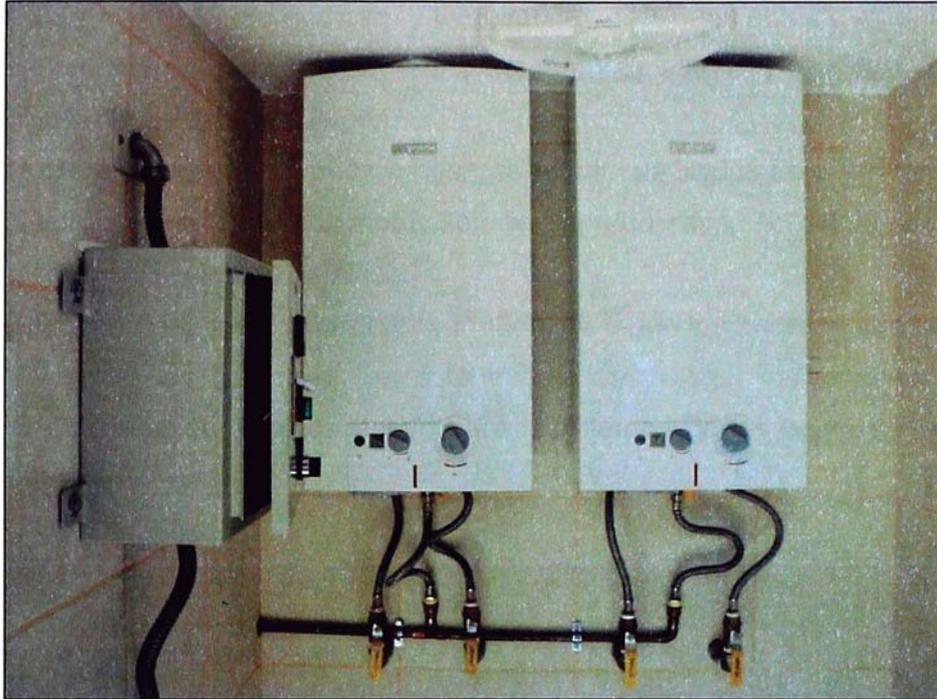
*Figura 2.13 Calentadores Instalados y tablero de control*
