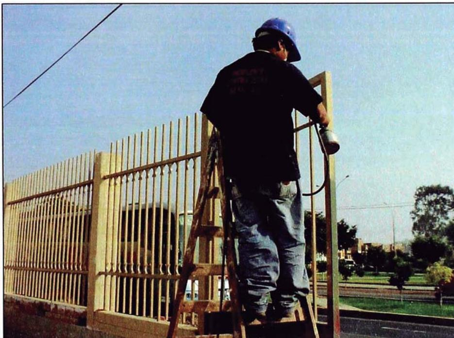
*Figura 2.20 Se aprecia el pintado de acabado final con soplete capilla Fiori.*
