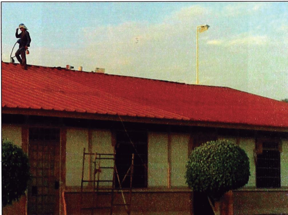
*Figura 2.22 Se aprecia el pintado de cobertura de la capilla “La Villa – Pisco”*
