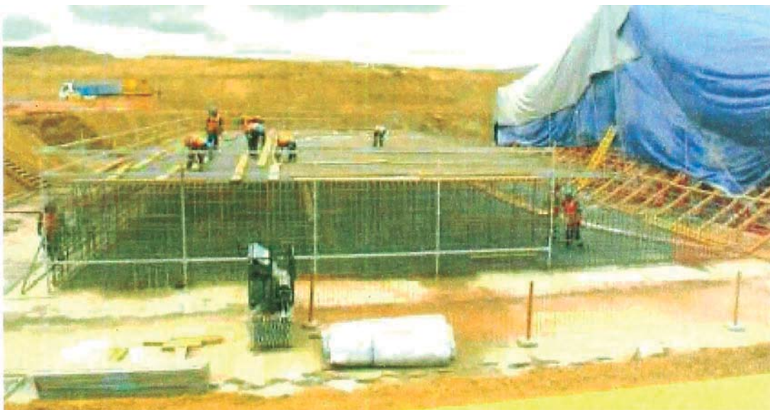
Figura 9: Distribución de trabajadores y sus EPP sobre el molino de bolas.
