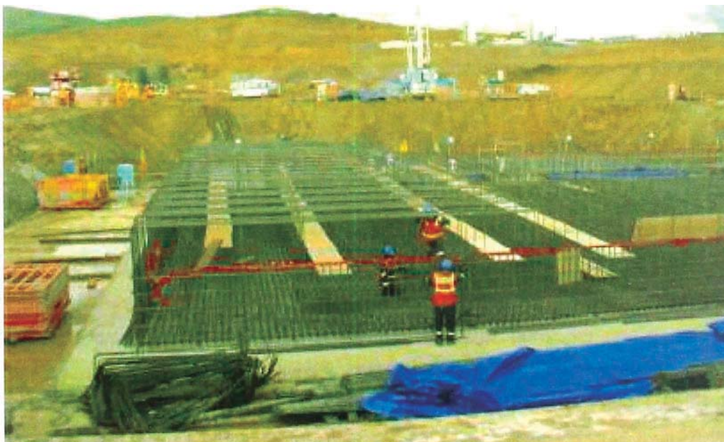
Figura 1: Utilización de silletas en el armado del refuerzo de una cimentación.
