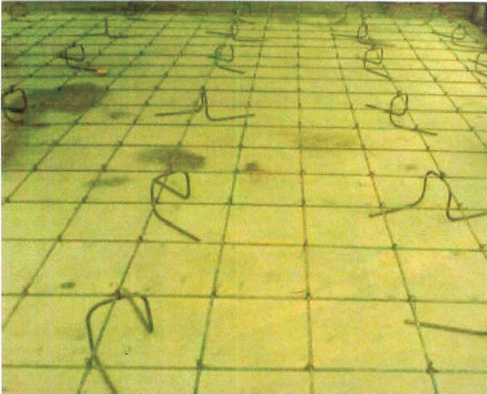
Figura 3: Utilización de silletas para armar refuerzo en losas.
