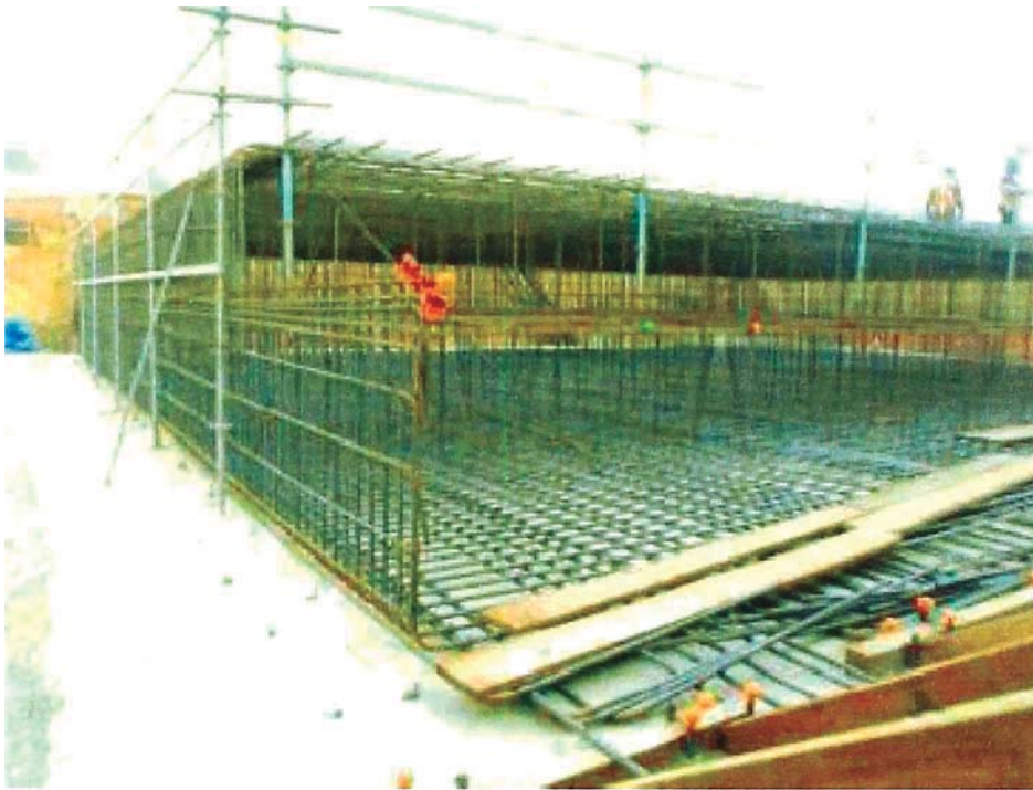
Figura 14: Utilización de arriostres centrales para la sujeción de las silletas.
