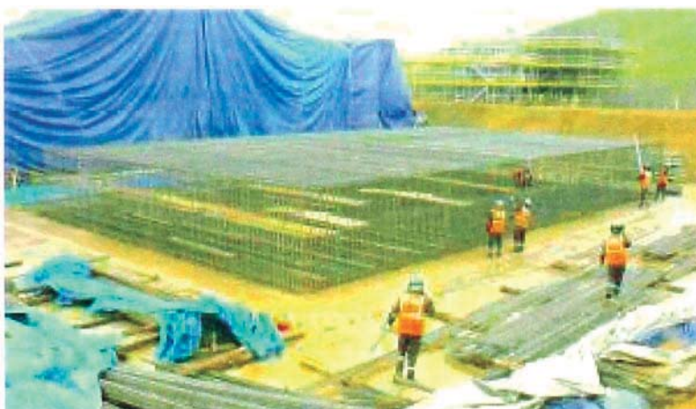
Figura 8: Cimentación del molino de bolas con armadura de acero completa.
