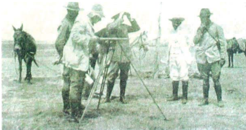
Figura N°01: Primeras perforaciones en Zorritos – Piura (fuente: Perupetro)
