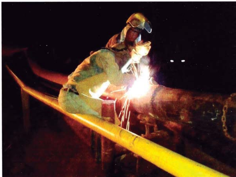
Figura N°26: Soldadura de Trunk Line de 12" en Jibarito (Fuente: Pluspetrol)
