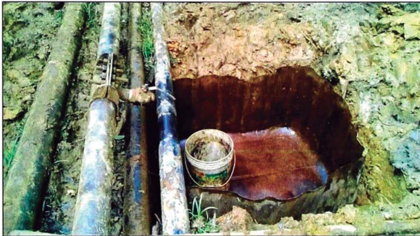
Figura N°20: Hot Tap para drenado de línea diesel 6" - Capahuari Norte (Fuente: Pluspetrol)
