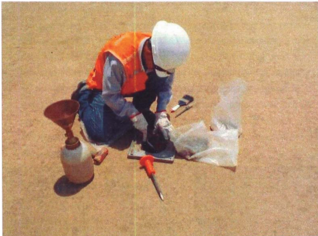
Figura 4.1 Prueba de densidad cono de arena
