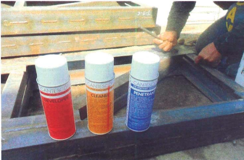
Figura 4.5 Prueba de calidad – Tinte penetrante
