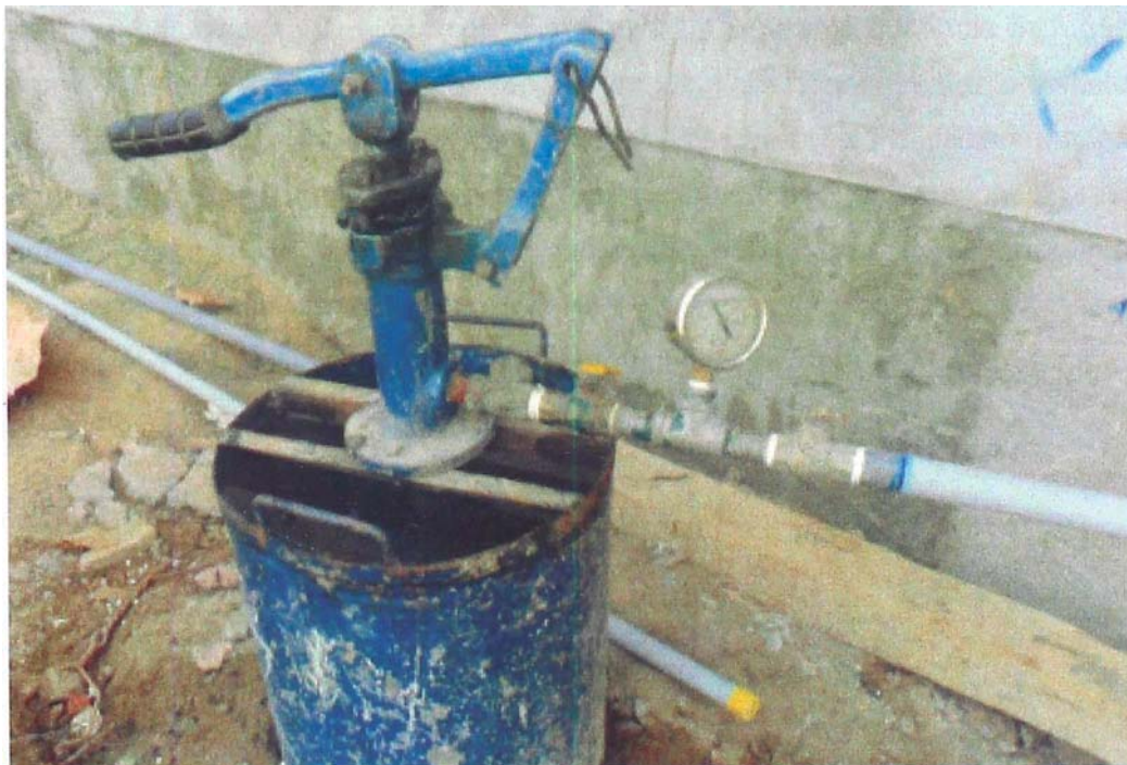
Figura 4.9 Prueba de calidad – presión hidrostática de tuberías PVC
