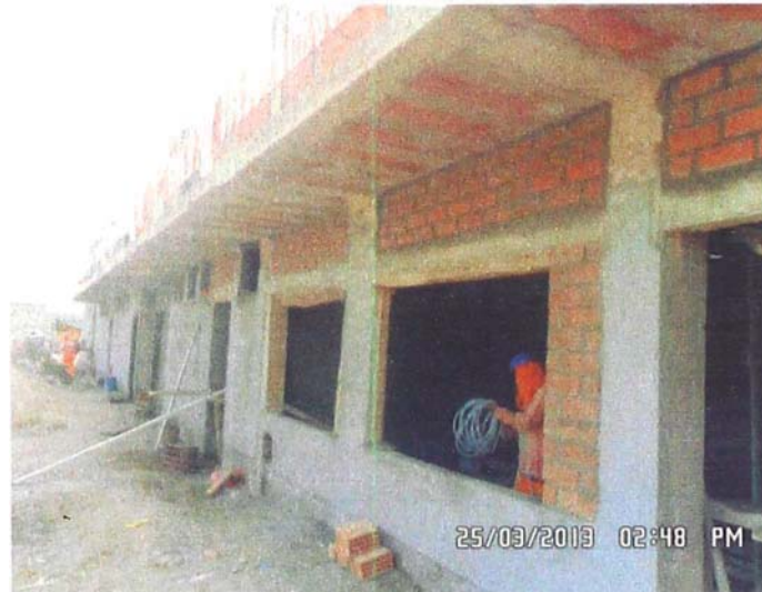
Figura 4.12 Prueba de calidad – muros
