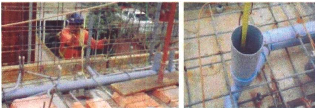
Figura 4.11 Prueba de calidad – pruebas de estanqueidad
