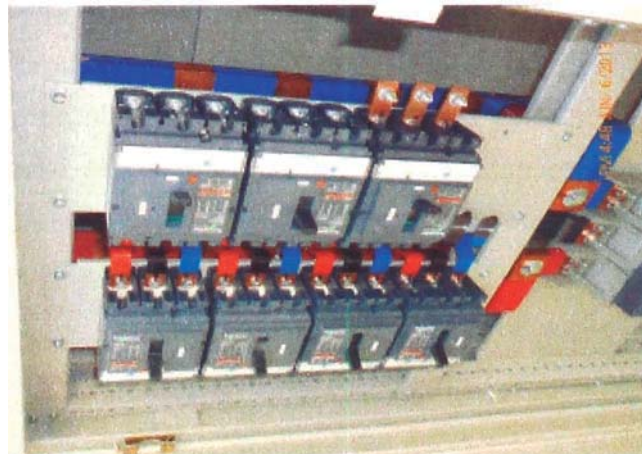
Figura 4.8 Prueba de calidad – Megado de tableros
