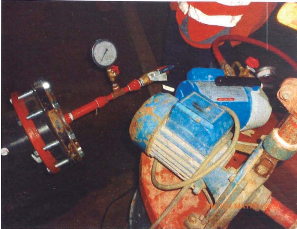
Figura 4.10 Prueba de calidad – pruebas de presión hidrostáticas tuberías HDPE
