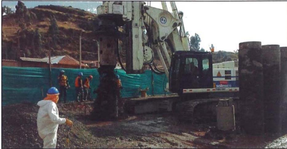
**Figura 3.26.- Perforación y extracción del material**
