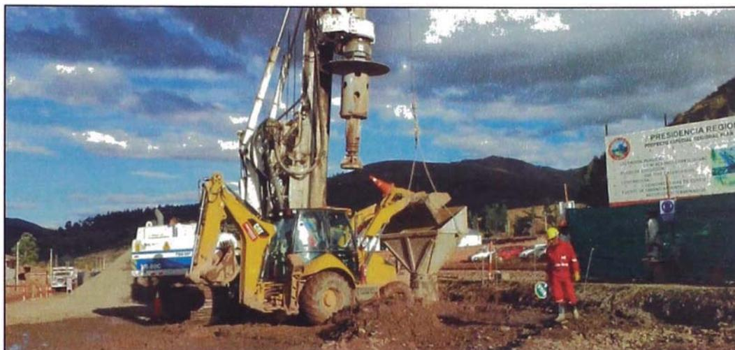
Figura 3.28.- Introducción de la grava dentro de la excavación.
