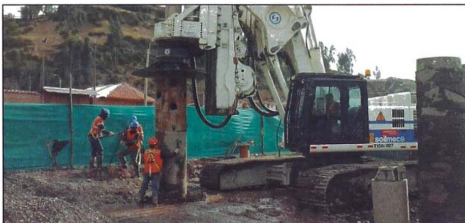
**Figura 3.27.-Colocación de tubos de molde recuperable**
