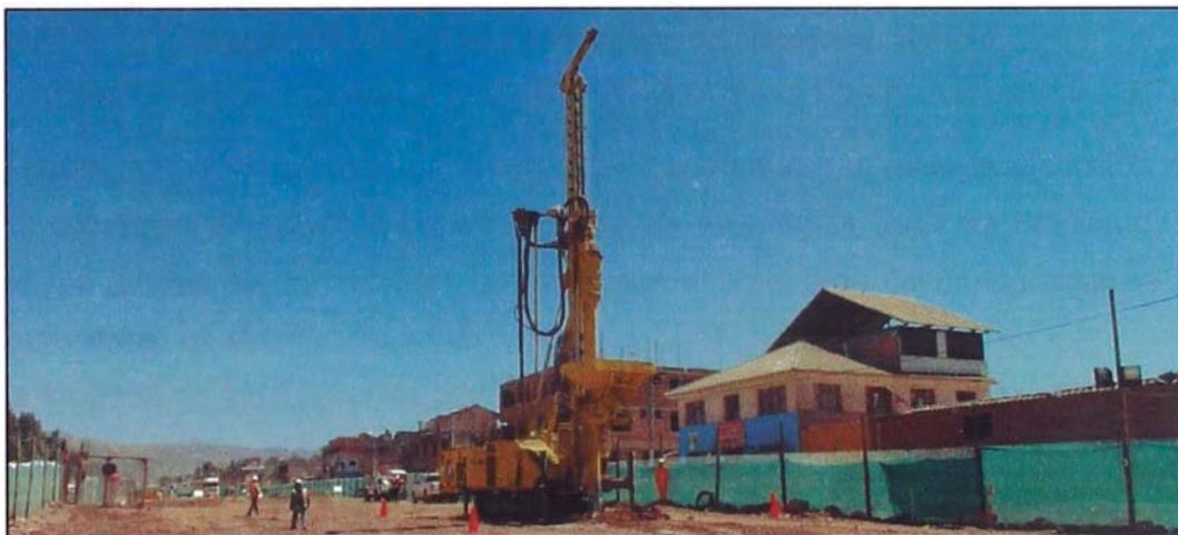
Figura 3.29.-Vibrador en Vibrocad con mastil
