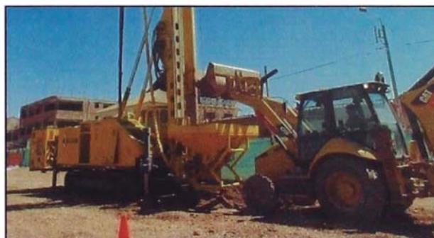
Figura 3.32.-Carga de grava en la tolva del vibrocad con una retroexcavadora
