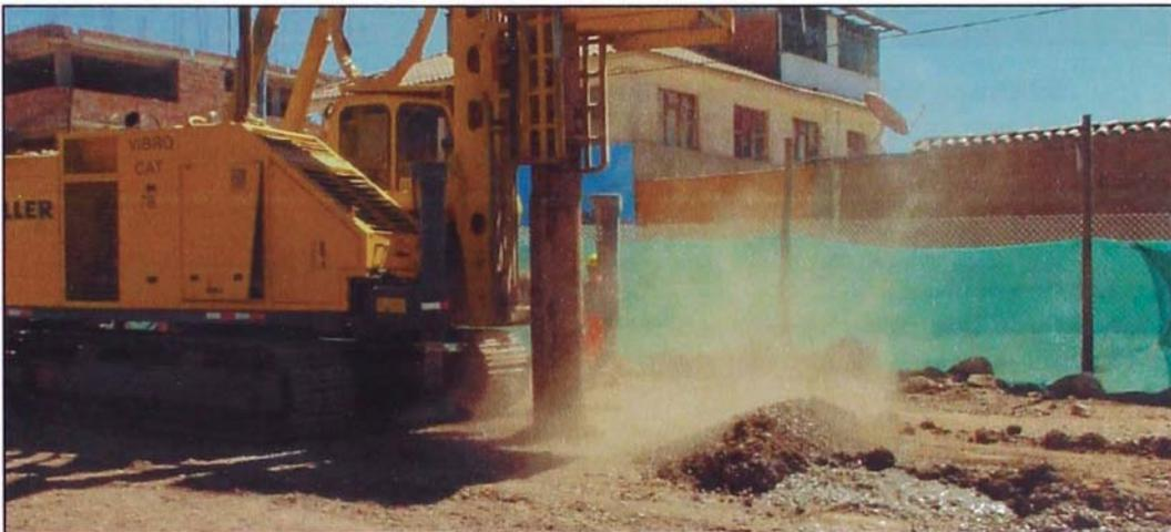
**Figura 3.30.-Ubicación y penetración del vibrador en el suelo**
