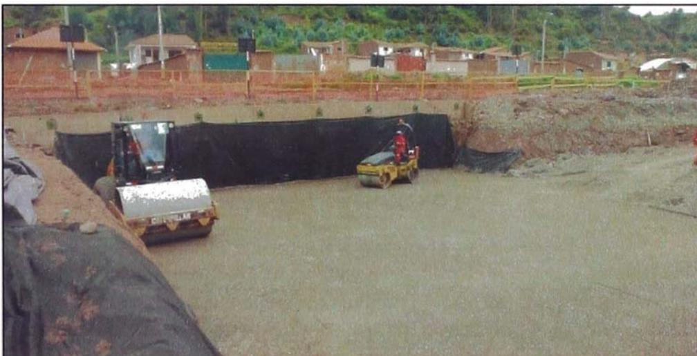
Figura 3.35.-Construcción de la base de apoyo con suelo reforzado
