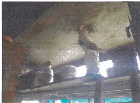
Figura 3.9: pulido de superficie en cielo raso
