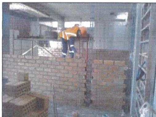
Figura 3.2: asentado de ladrillo
