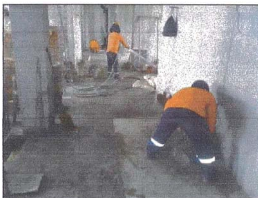
Figura 3.3: Preparación de mezclas arena – cemento para junta de muros
