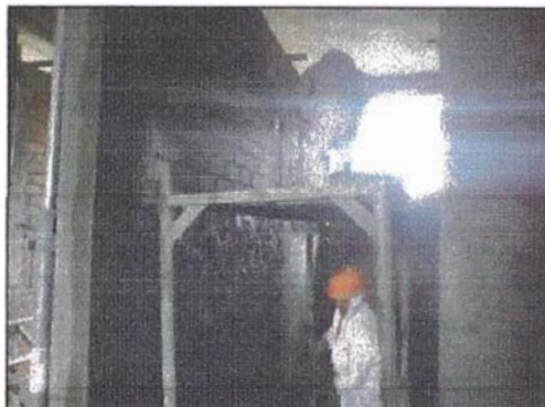
Figura 3.5: tarrajeo de muros
