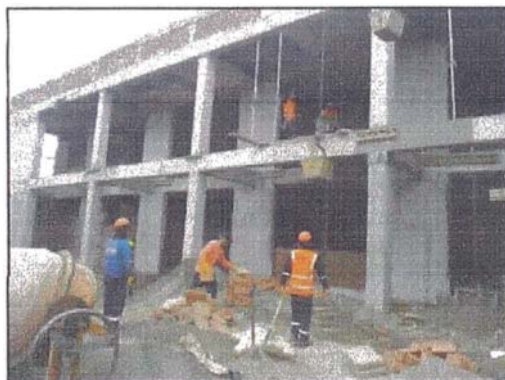
Figura 3.1: Acarreo de material para el ladrillo
