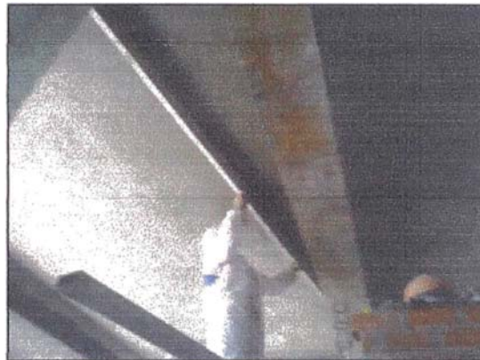
Figura 3.11: Alineamiento horizontal del tarrajeo con regla de aluminio
