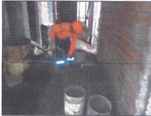
Figura 3.4: Preparación de mezclas arena – cemento para tarrajeo de cielo raso
