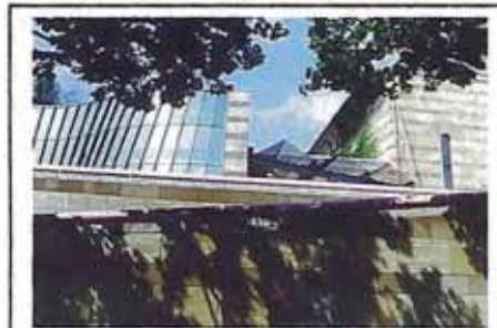
Fig JS-13: desde la calle nivel peatonal
