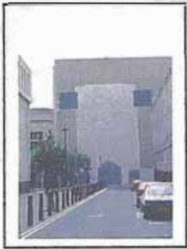
Fig RV-11: Vista de la fachada posterior
