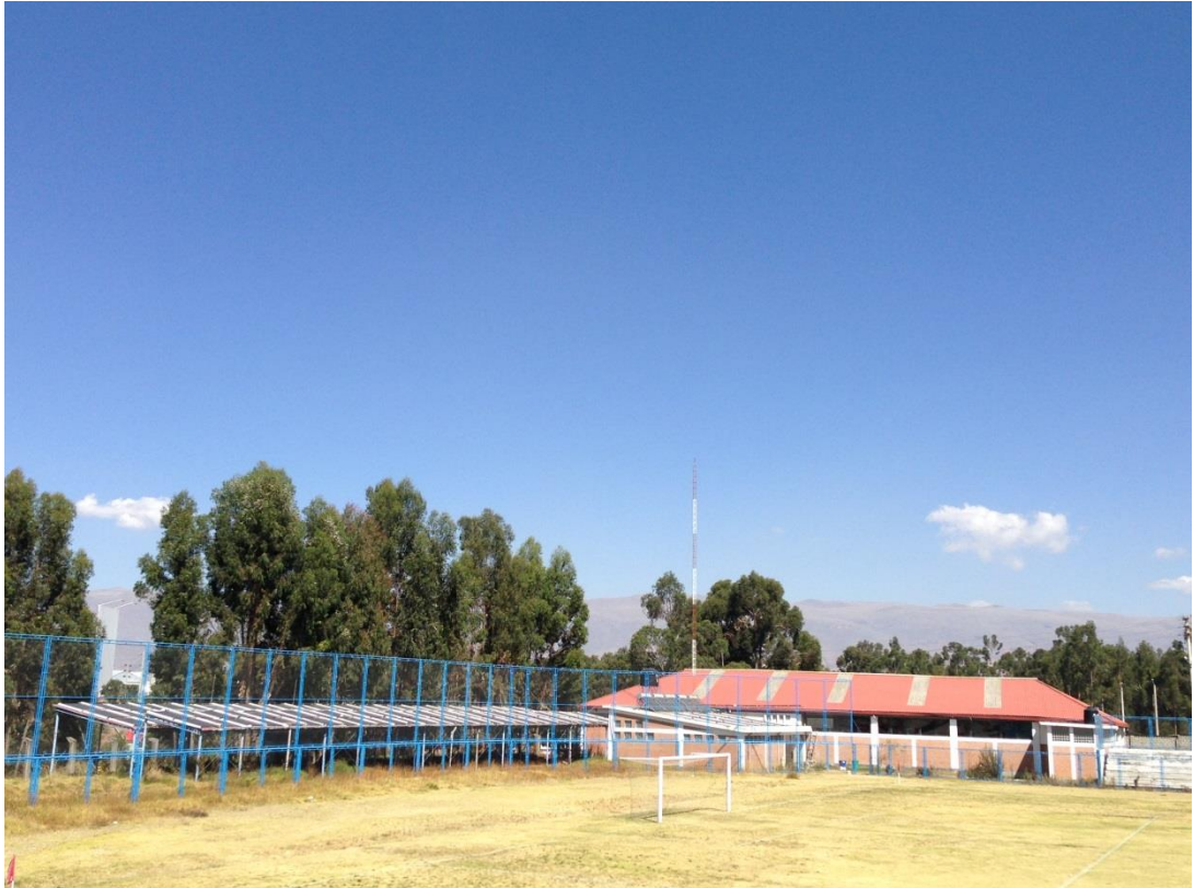
Ubicación de colectores solares de la piscina principal en la etapa de construcción
