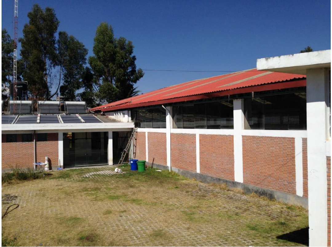
Edificio de la piscina y de duchas de agua caliente
