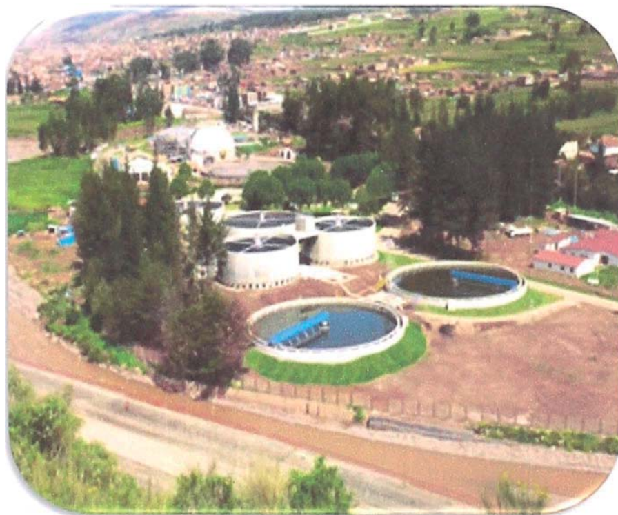
Figura N° 16.- Vista panorámica de la PTAR Sedacusco (Fuente: Cosapi S.A)
