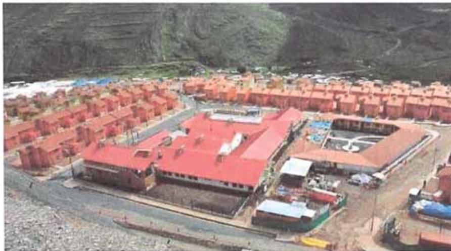
FIGURA 4.1 Viviendas Masivas del Proyecto Nueva Fuerabambas – Apurímac
