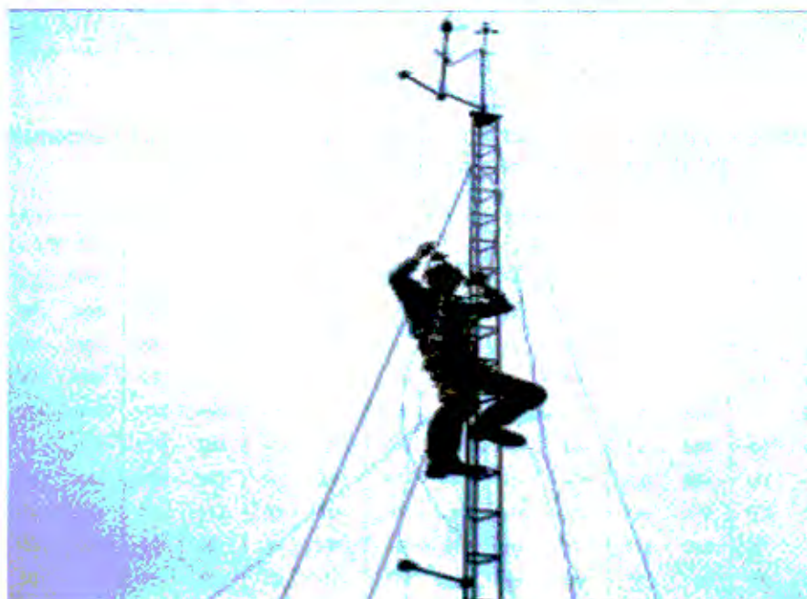
Figura 4.18: Anemómetro instalado a 10 m sobre el suelo
