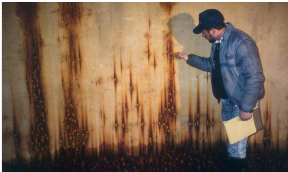
**Figura N° 25: Corrosión en las Paredes de un Tanque**
