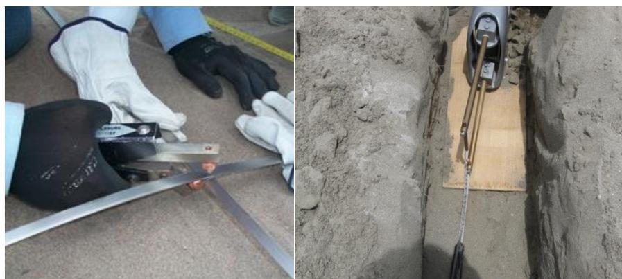
**Figura N° 54: Soldadura entre Barras Conductoras de Titanio**
