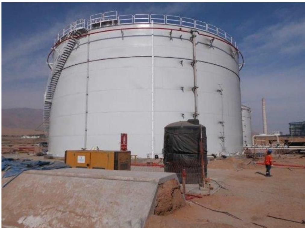
**Figura N° 4: Ejemplo de Tanque Cilíndrico Vertical Atmosférico de base plana**
