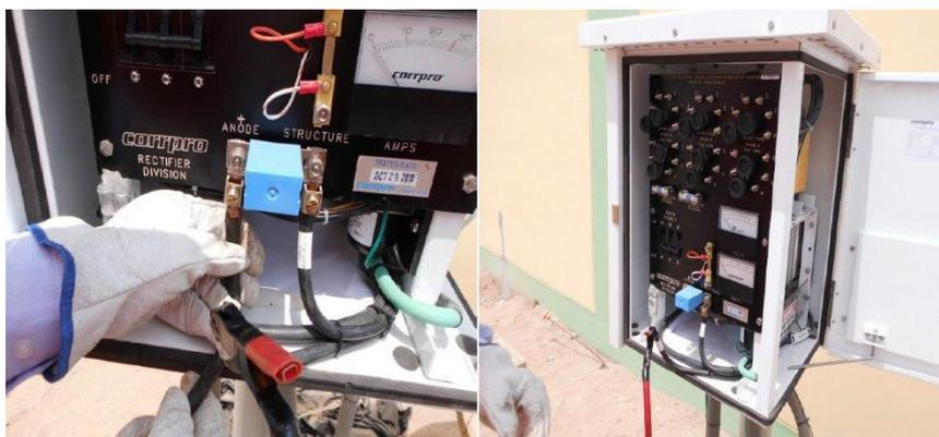
**Figura N° 71: Rectificador Instalado a un SPC****Fuente: Corrpro**
