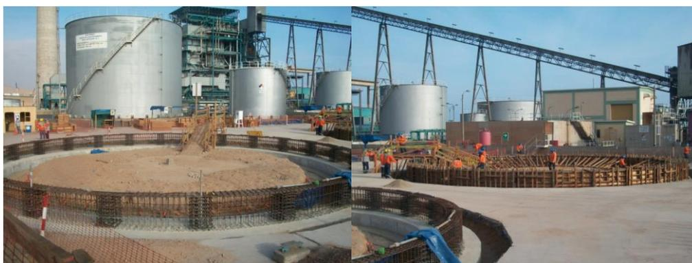
**Figura N° 3: Construcción de Anillos para Tanques**
