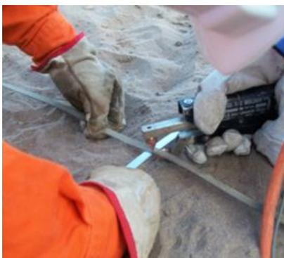
**Figura N° 55: Soldadura entre Barra Conductoras de Titanio y Cinta
