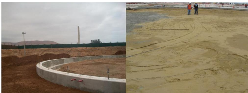
**Figura N° 45: Acondicionamiento del Terreno Base**
