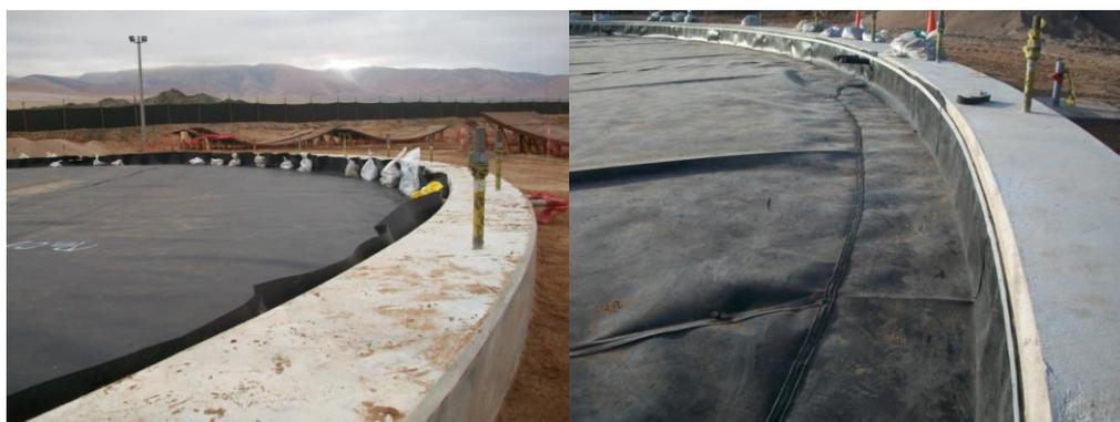
**Figura N° 46: Instalación de la Geo-membrana**
