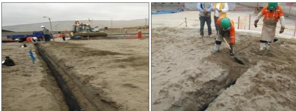
**Figura N° 47: Colocación del Tubo con Geotextil para Toma de Potenciales**
