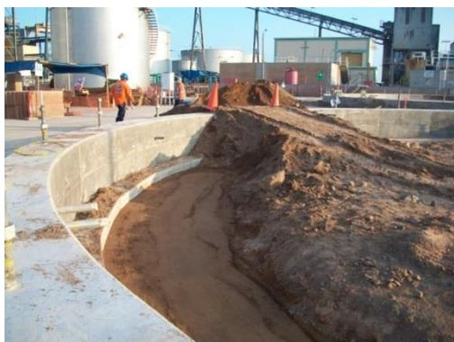
**Figura N° 19: Terreno Natural Compactado**
