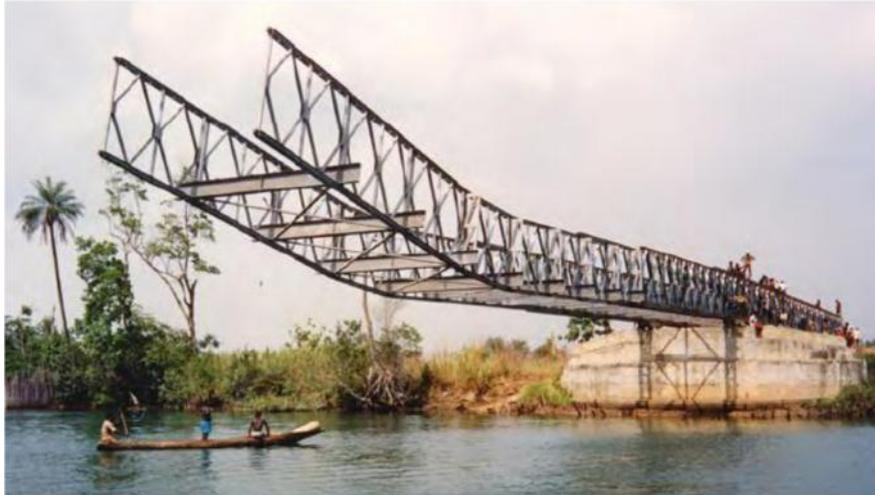
FIGURA 2.2 Lanzamiento de un puente modular
