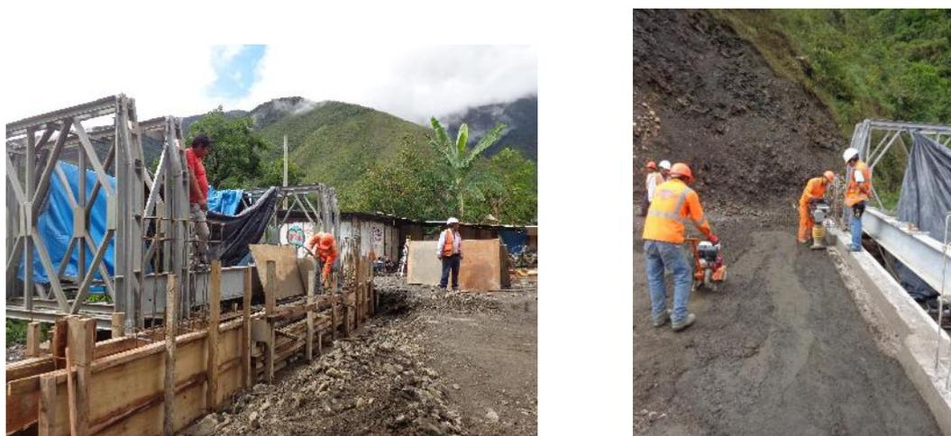
Figura N° 5.10 Trabajos construcción de parapetos y relleno y compactación de accesos.
