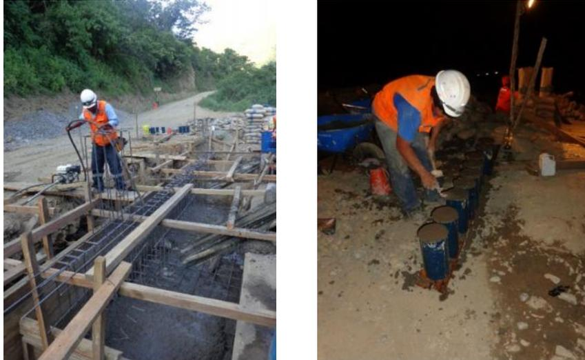
Figura Nº 5.7 Colocación de concreto en dado de cimentación, muestreo de concreto fresco
