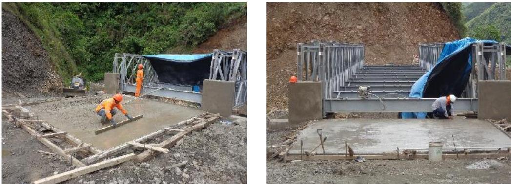
Figura N° 5.13 Trabajos de colocación de concreto  $f'c=210 \text{ kg/cm}^2$  en losas de aproximación.
