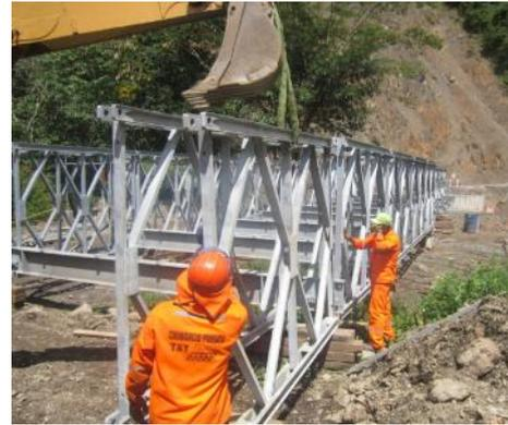
Figura N° 6.8 Montaje de paneles 1ra y 2da fila
