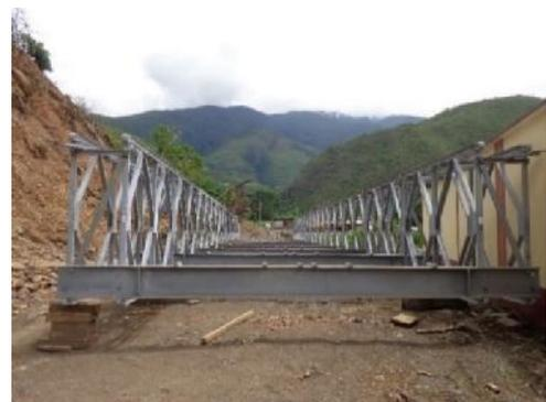
Figura N° 6.12 Montaje concluido, estructura apoyada sobre rodillos planos para su lanzamiento
