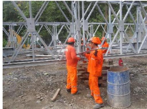
Figura N° 6.11 Ajuste de pernos y verificación de ajuste con el uso del torquímetro
