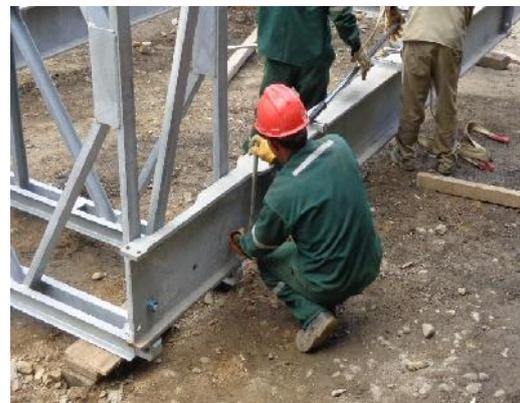
Figura N° 6.9 Instalación de vigas de piso, colocación y ajuste de pernos
