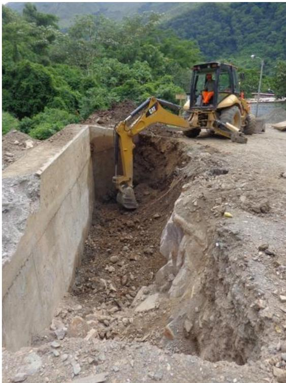
Figura N° 5.4 Excavación para cimentación de dados de concreto
