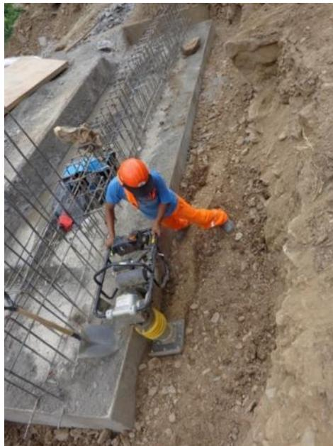
Figura Nº 5.8 Trabajos de relleno y compactación con material de préstamo
