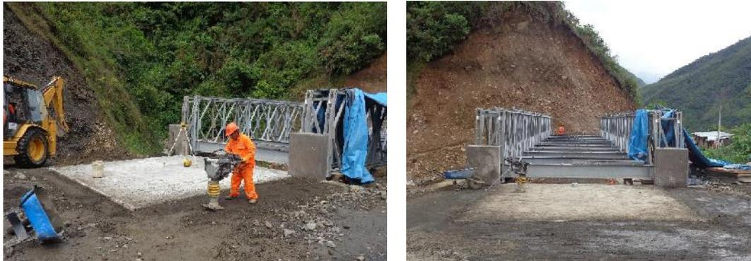
Figura N° 5.14 Trabajos de relleno y compactación en bordes de losas de aproximación.
