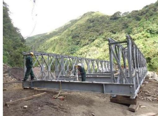
Figura N° 6.10 Colocación de arriostramientos, nivelación de estructura metálica
