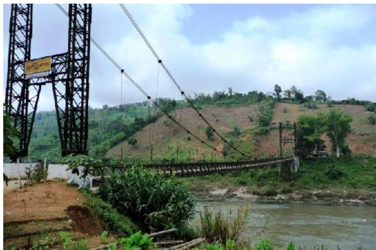
FIGURA 2.5 Puente modular colgante, las torres, tablero conformado por paneles
