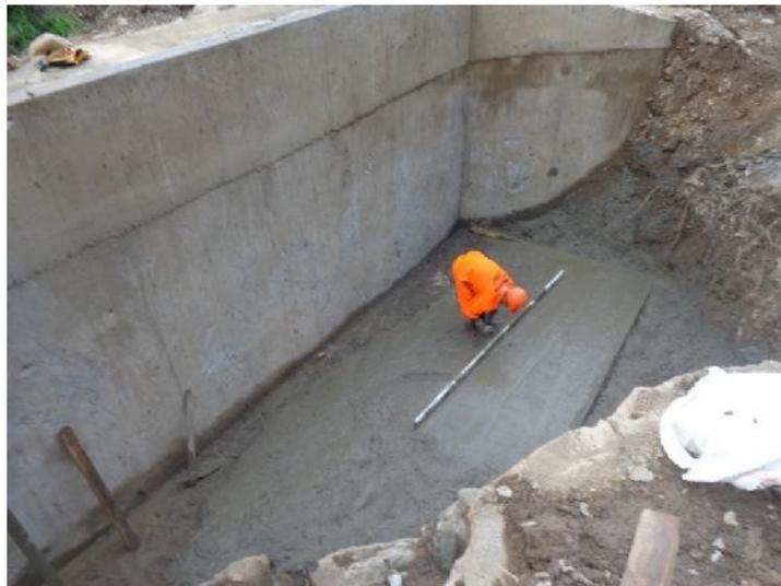
Figura N° 5.5 Colocación de solado en fondo de excavación
