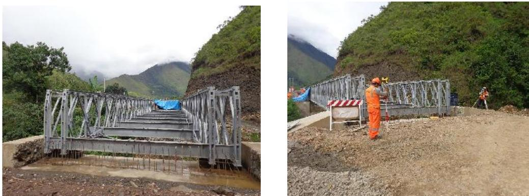
Figura N° 5.9 Lanzamiento de puente modular concluido, trabajos de replanteo de accesos.
