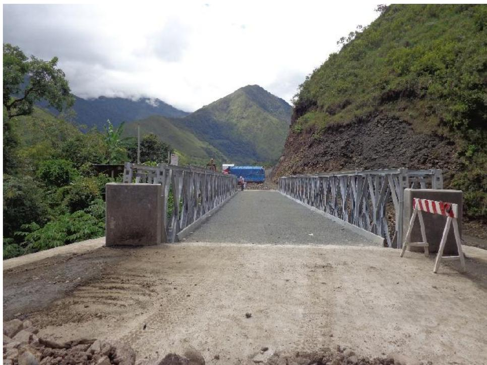
Figura N° 5.15 Vista panorámica de puente modular con losas de aproximación y muro contra impactos.
