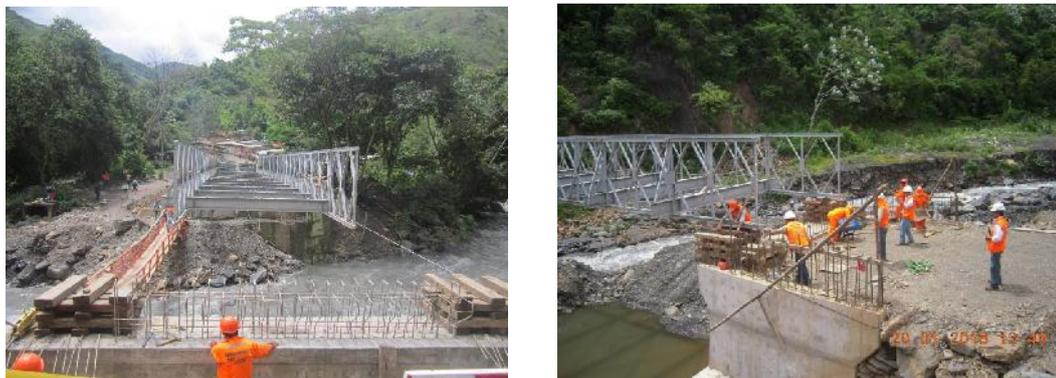
Figura N° 7.10 Lanzamiento de puente modular, el jalado y la retenida de la estructura metálica se realiza empleando tirfors
