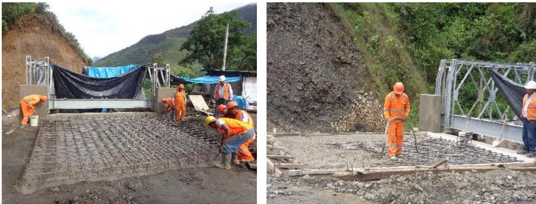
Figura N° 5.12 Trabajos de colocación de armadura y concreto en losas de aproximación.
