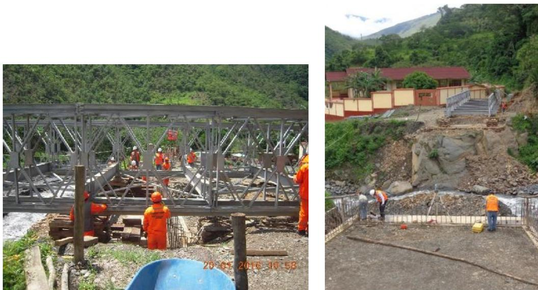
Figura N° 7.9 Verificación de instalación de rodillos, previo al lanzamiento del puente modular
