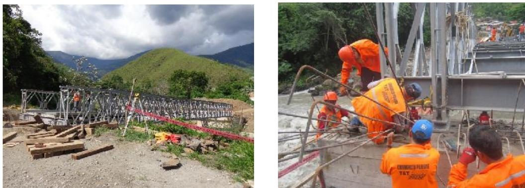
Figura N° 7.11 Llegada de la nariz de lanzamiento a estribo izquierdo, puente modular instalado sobre estribos.
