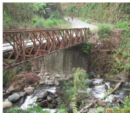
Figura N° 3.8 Estríbulo derecho e izquierdo del Puente Pucará
