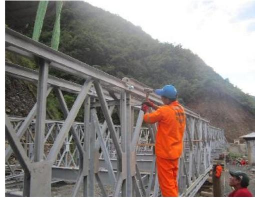
Figura N° 6.7 Izaje y unión de paneles mediante pines
