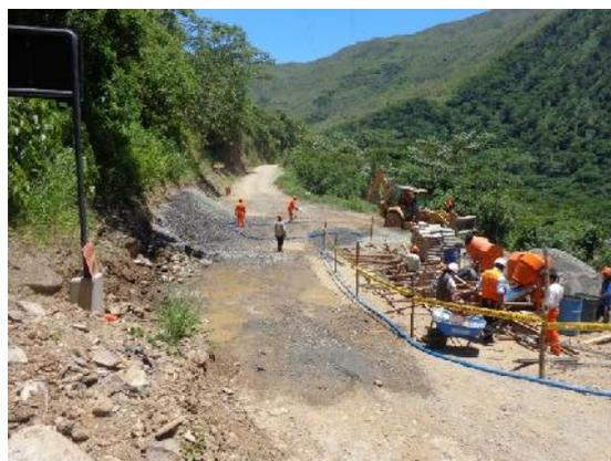
Figura N° 5.6 Trabajos de encofrado, armadura en dado, cuadrilla de colocación de concreto
