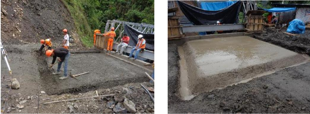
Figura N° 5.11 Trabajos de excavación y colocación de solado para construcción de losas de aproximación en ambas márgenes.
