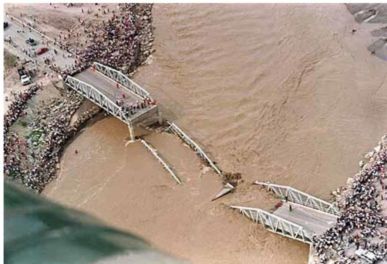
FIGURA 2.3 Colapso del puente Reque, Marzo de 1998
