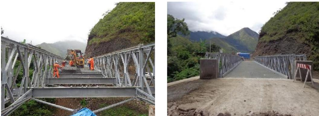
Figura N° 7.12 Puente modular instalado con piso metálico.
