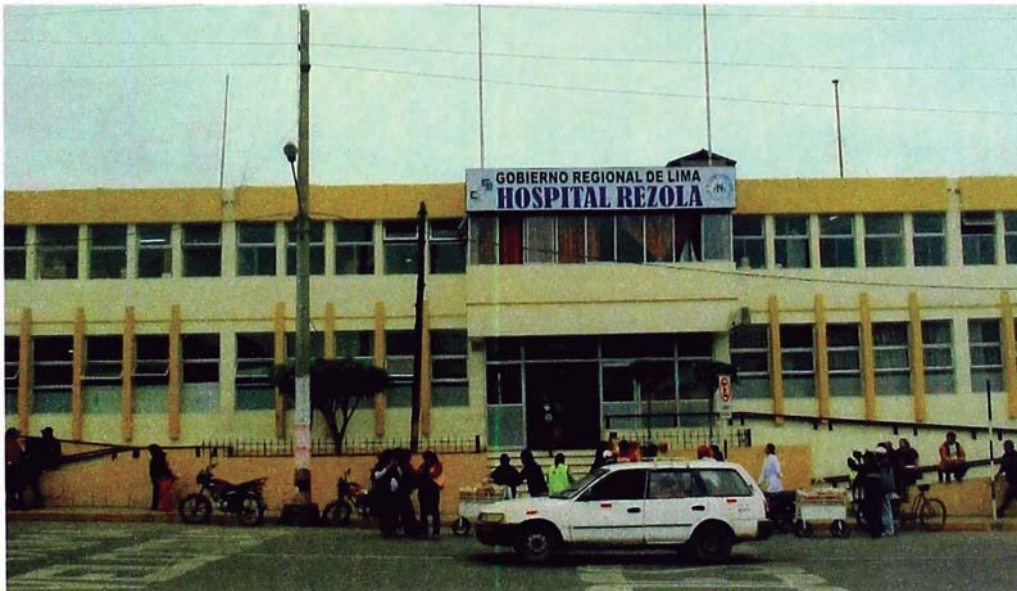
Fotografía 5.4. Hospital de Apoyo Rezola. San Vicente de Cañete.
