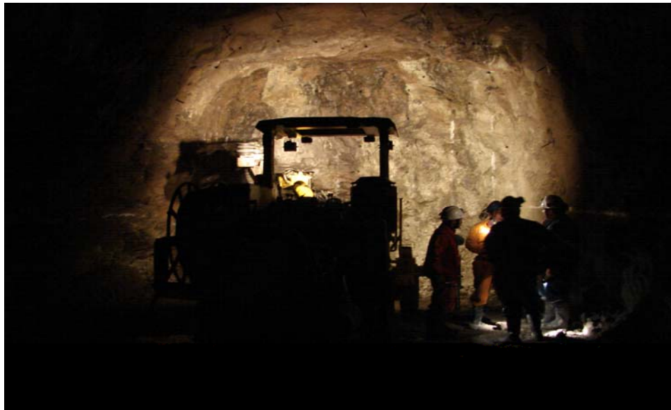
Foto N°16. Se observa a los supervisores coordinando trabajos en interior mina. Perforación con jumbo electro-hidráulico en el tajeo 024 Ro
