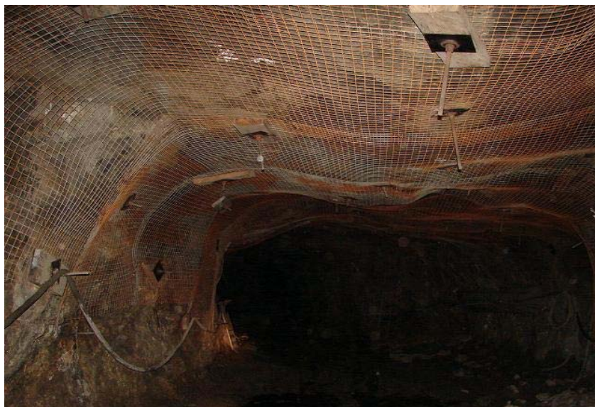
Foto N°14. Sostenimiento con la malla electro soldada en zonas fracturadas y húmedas
