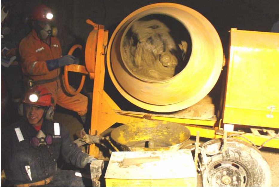
Foto N° 10. Se observa la mezcladora en momentos de batido y alimentación en la Shotcretera "Red" por Sistema Vía Húmeda
