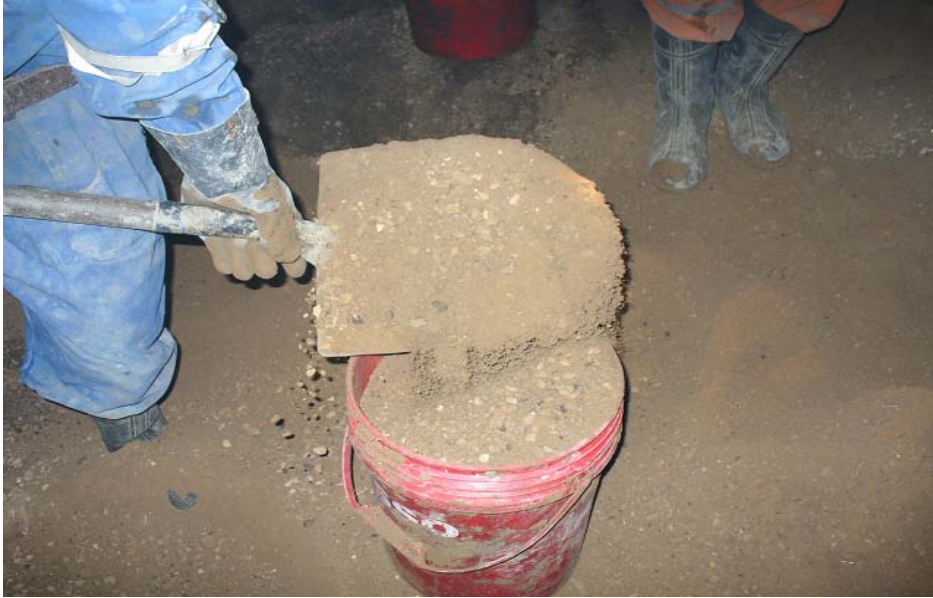
Foto N° 8. Se observa la selección de arena que se requiere para el shotcrete.
