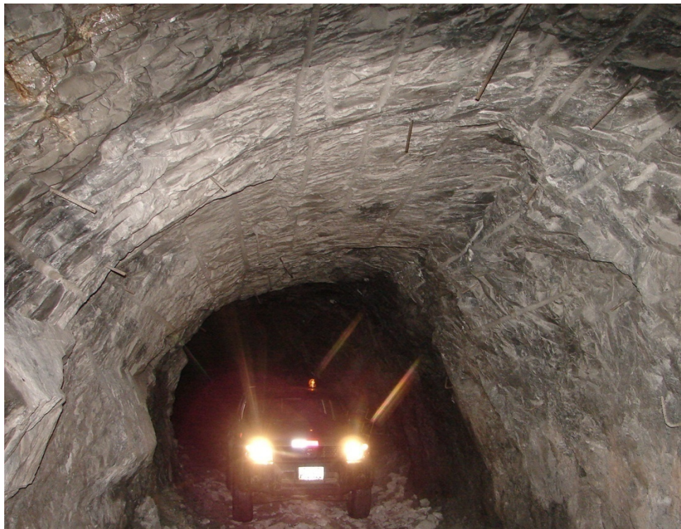
Foto N°6. Se observa una labor en interior mina sostenida con pernos cementados
