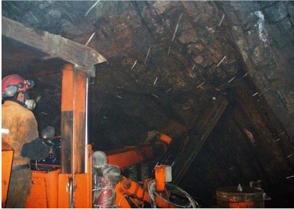
Foto N°5. Se observa la máquina Robolt colocando pernos cementados aprox.de 60 pernos/guardia
