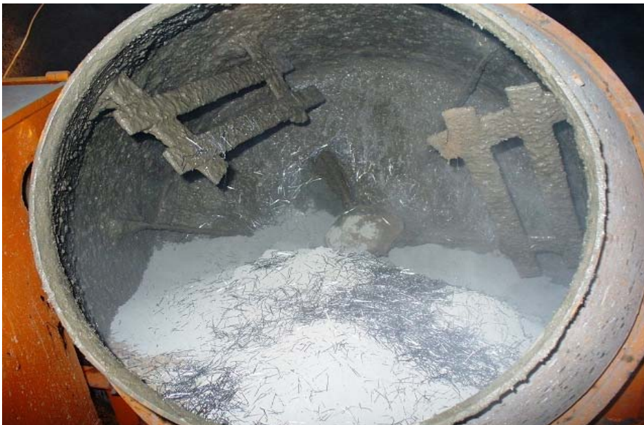
Foto N° 9. Se observa los materiales de mezcla, arena, cemento, fibra de acero y agua en la mezcladora de 7 pies 3 de volumen (capacidad).
