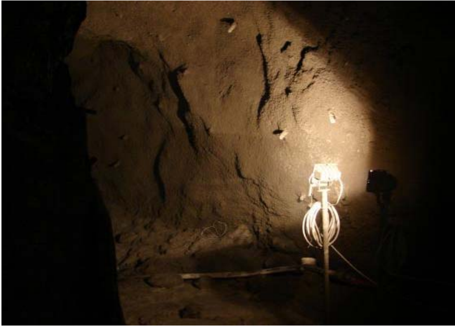
Foto N°12. Se observa la notable reducción de polvo en el shotcrete de Vía húmeda.
