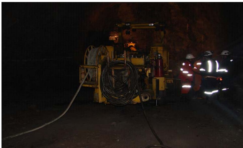
Foto N°17. Se observa un Jumbo electrohidráulico N° 3, en la labor tajeo 024 Ro.
