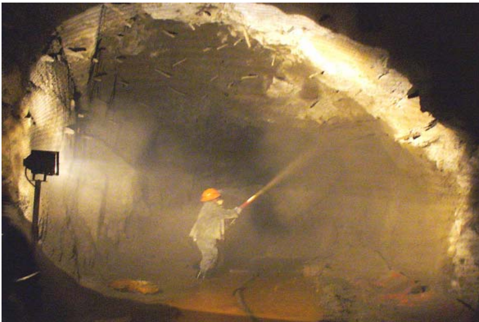
Foto N° 11. Se observa en momentos de lanzamiento de shotcrete vía húmeda
