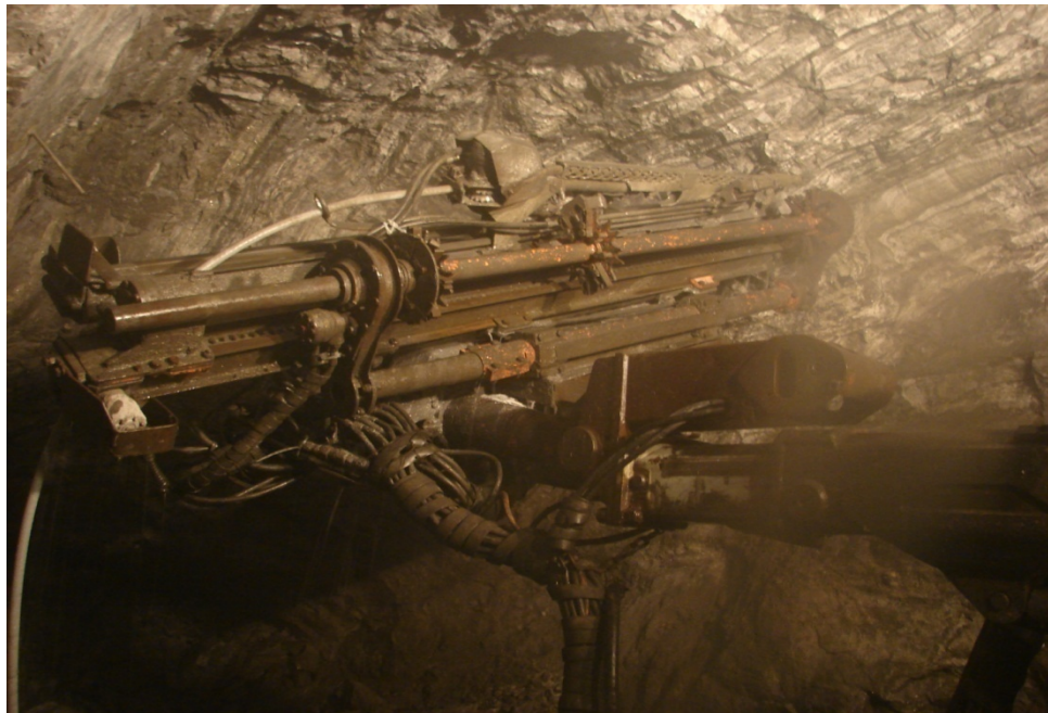
Foto N°15. Se observa la máquina, Robolt N°1, marca Tamrock, perforando taladros para colocar pernos cementados.
