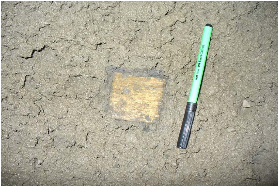
Foto N° 13. Se observa el shotcrete por vía húmeda en el hastial derecho, el resultado es positivo con un espesor de 2" y el calibrador de madera.
