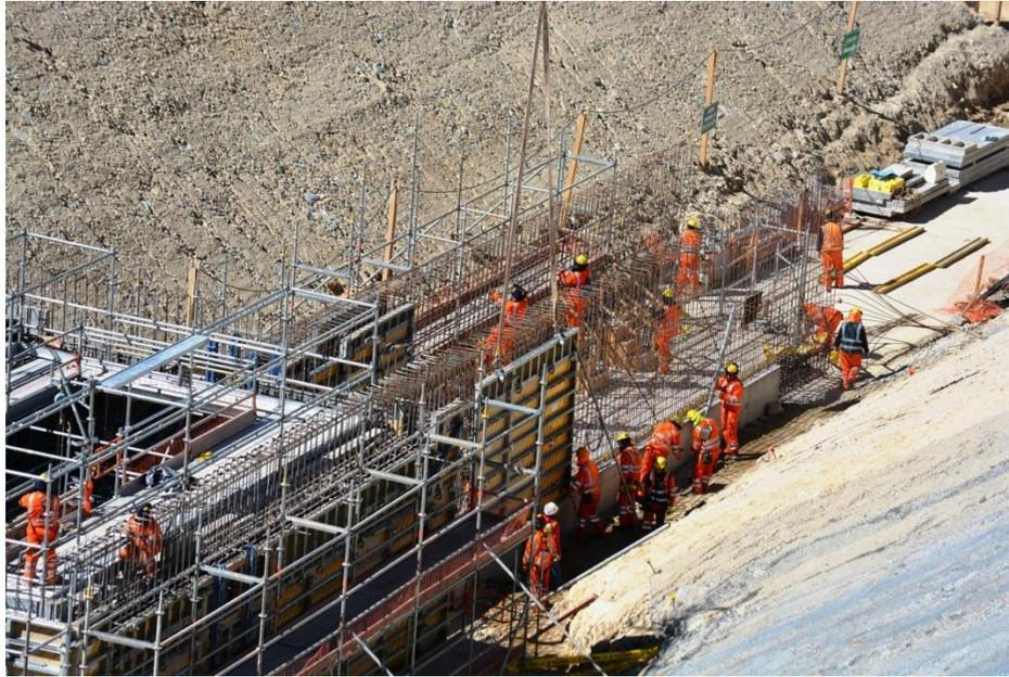
Figura 5. 9: Armado de acero de refuerzo de los muros del túnel de salida.
