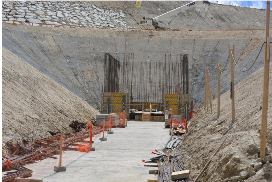
Figura 5. 7: Vaciado de solado de túnel de salida.
