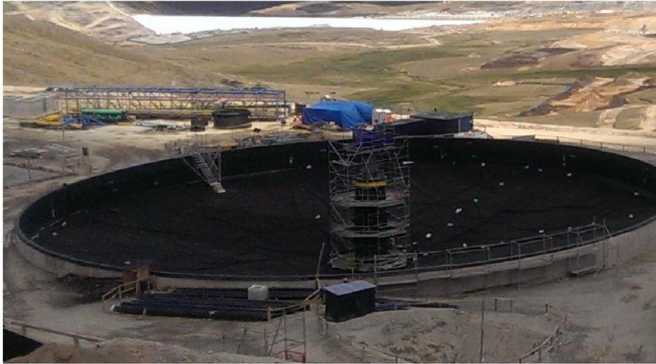
Figura 5.23: Recepción de los trabajos de impermeabilización para inicio de construcción de losa radier.
