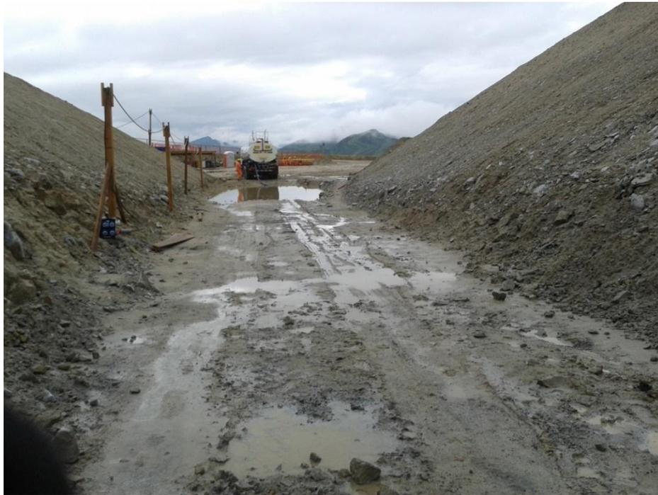
Figura 5.3: Daños causados por la lluvia a suelo de fundación de túnel de salida.
