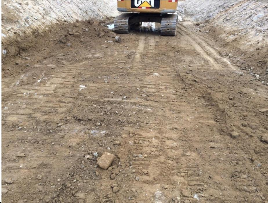
Figura 5.4: Trabajos para mejorar el suelo de fundación de túnel de salida.
