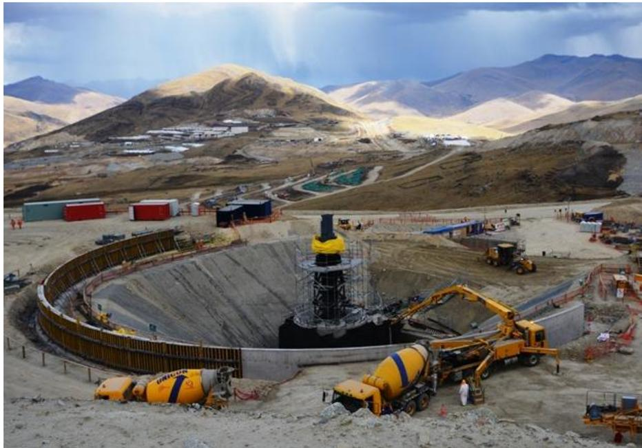
Figura 5.16: Relleno alrededor de apoyo central.
