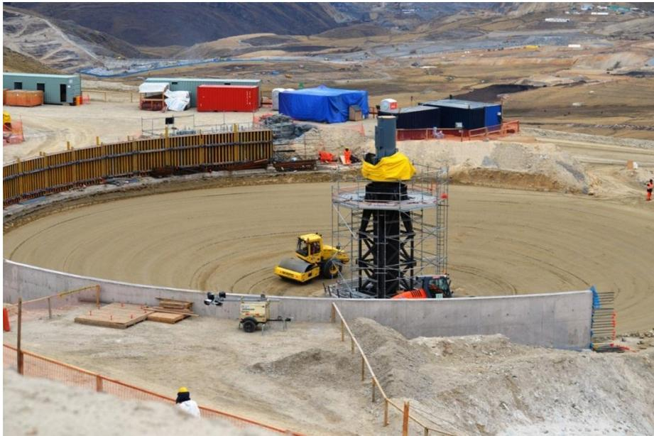
Figura 5.18: Terminación de los trabajos de relleno.
