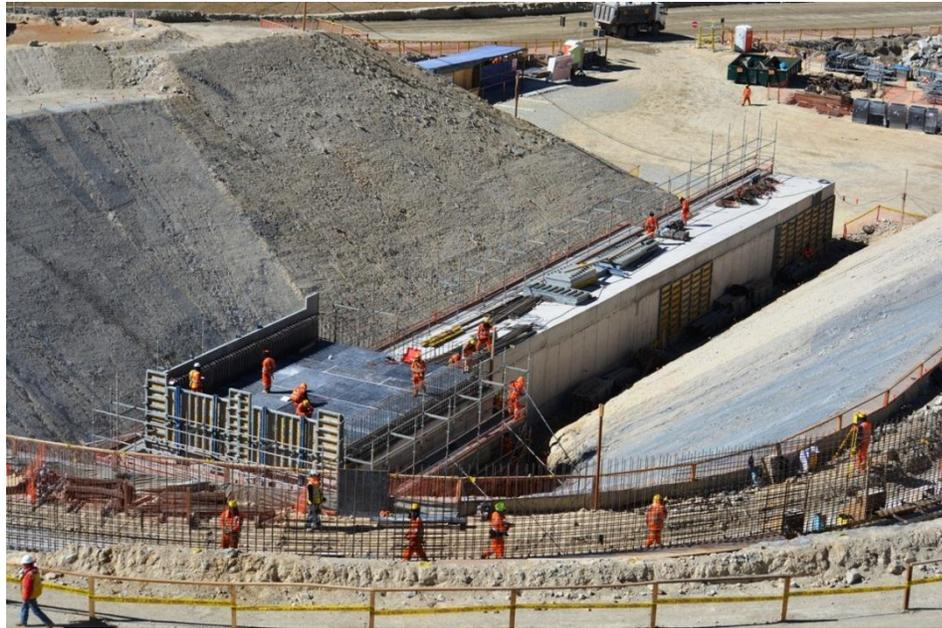
Figura 5.11: Encofrado de la losa superior del apoyo central.
