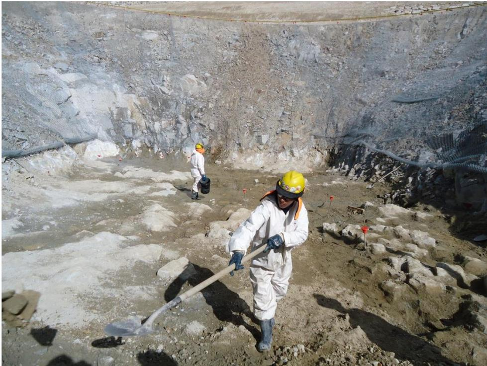
Figura 5.2: Limpieza del suelo de fundación del apoyo central.
