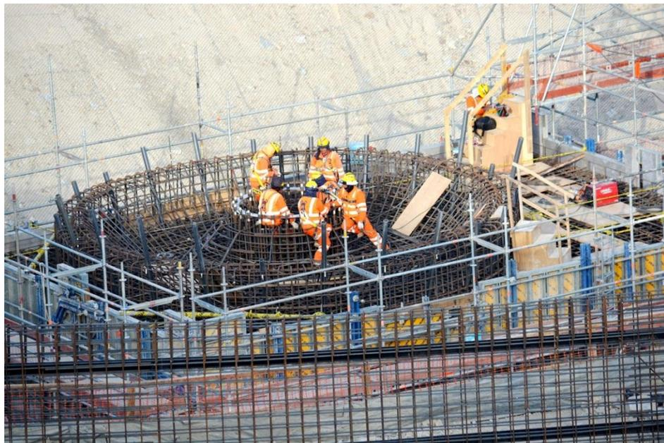
Figura 5.12: Colocación del acero de refuerzo de la losa superior del apoyo central.
