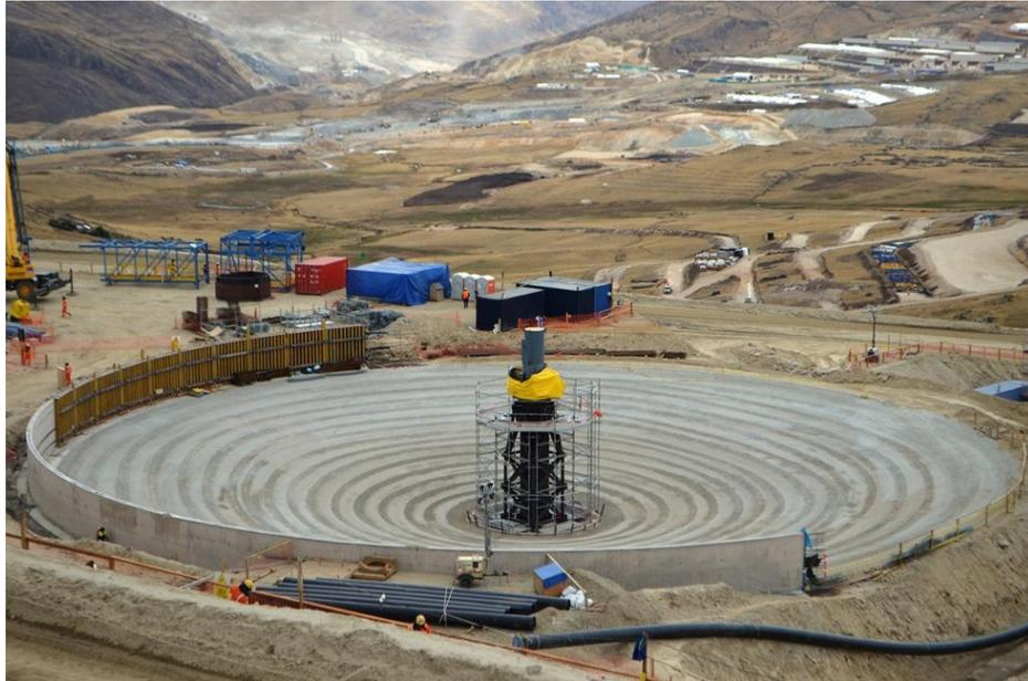
Figura 5.19: Colocación de cama de arena según se indica en planos.
