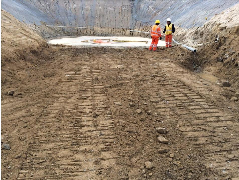
Figura 5. 5: Vaciado completo del solado de apoyo central.
