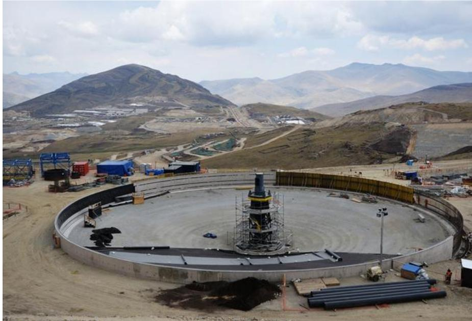
Figura 5.20: Tendido de las geomembranas sobre cama de arena.
