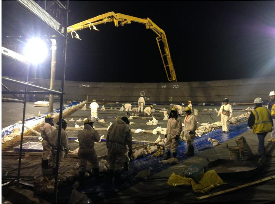
Figura 5.24: Trabajos previos al vertido del concreto de la losa.
