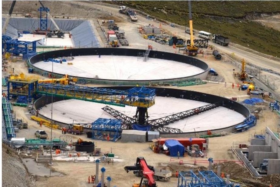
Figura 5.26: Acabado final de obras de concreto en el espesador.
