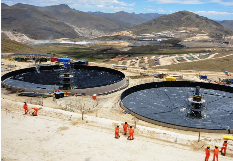
Figura 5.22: El sistema de impermeabilización comprende varias capas de geomembrana.
