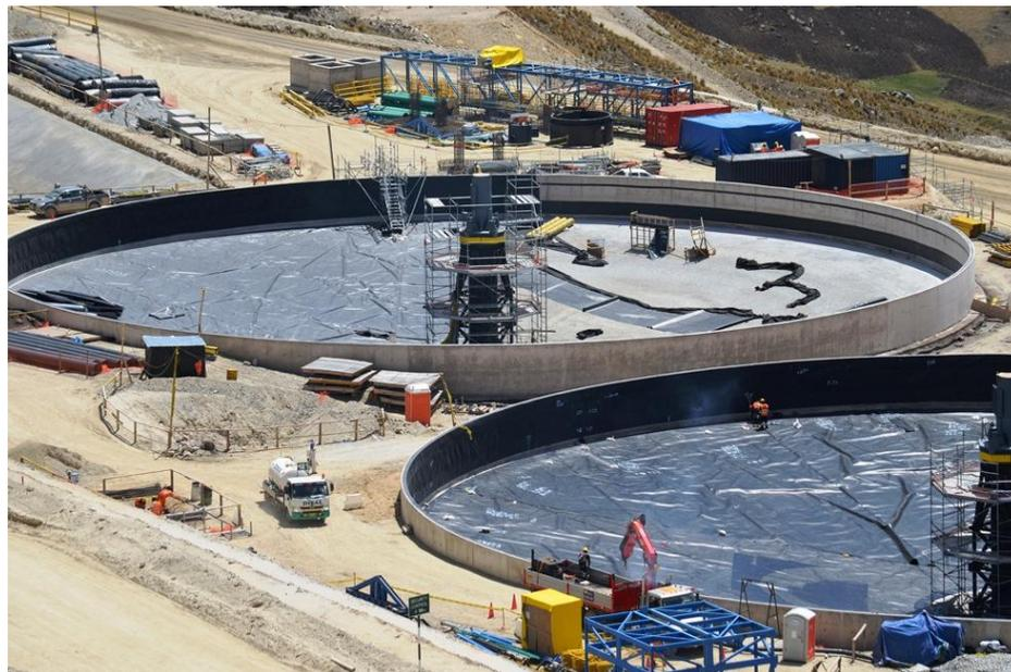
Figura 5.21: Soldado de la geomembrana al muro perimetral.
