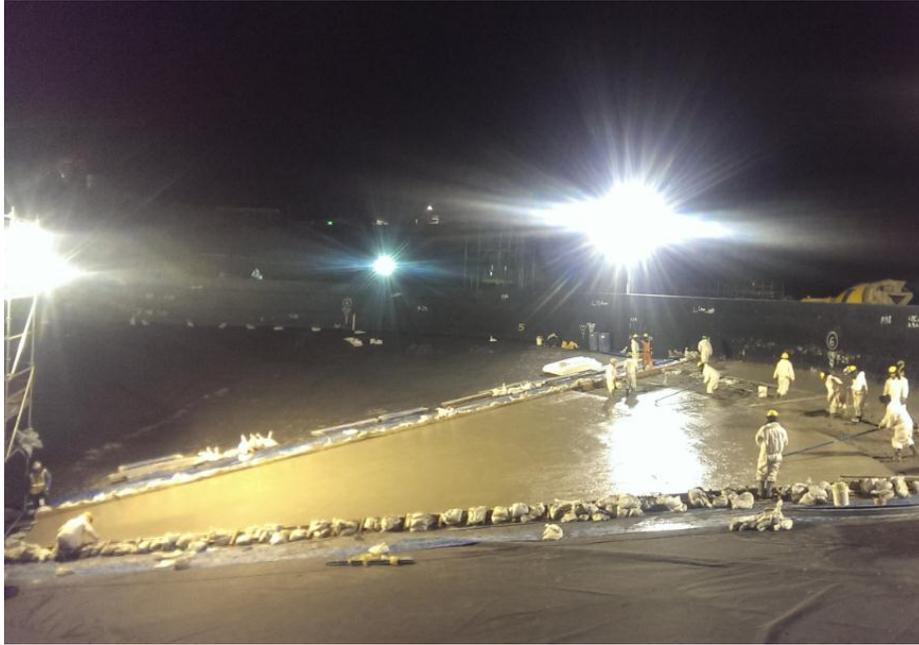
Figura 5.25: Vaciado de concreto de la losa radier.
