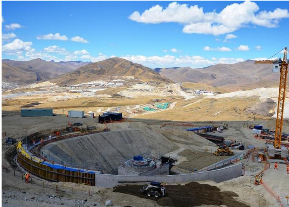
Figura 5.15: Construcción de los muros perimetrales.
