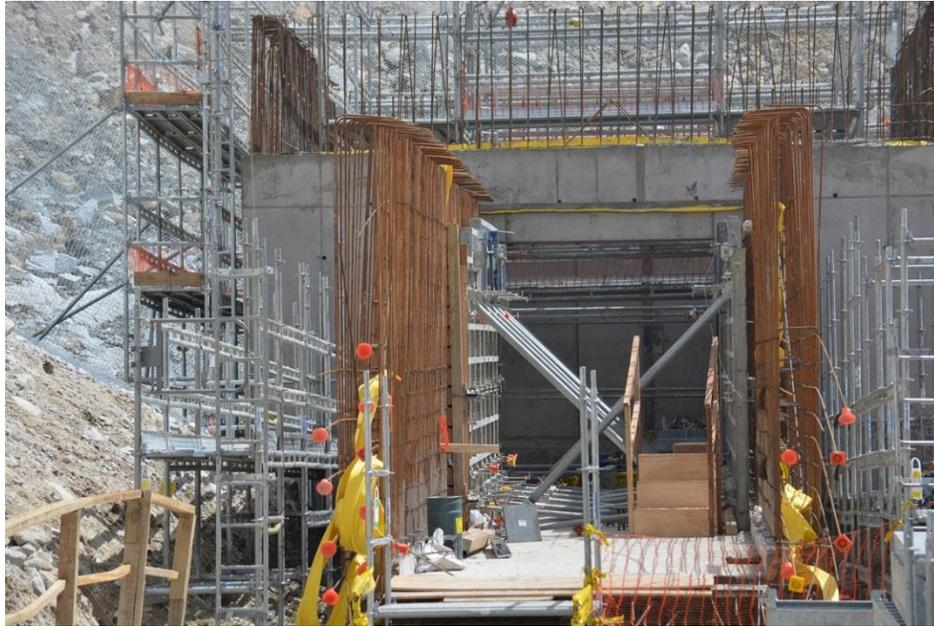
Figura 5. 8: Trabajos de apoyo central y túnel de salida simultáneamente.
