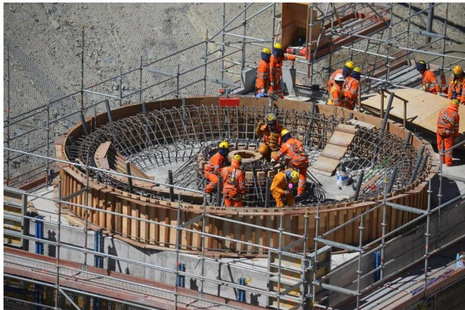
Figura 5.14: Armado de encofrado de detalle en losa superior de apoyo central.
