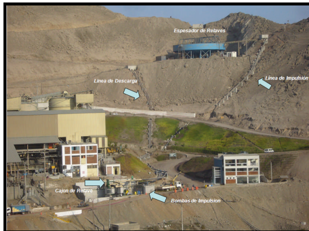
Foto N° 30: Sistema de recuperación de agua (Espesador de relaves).
