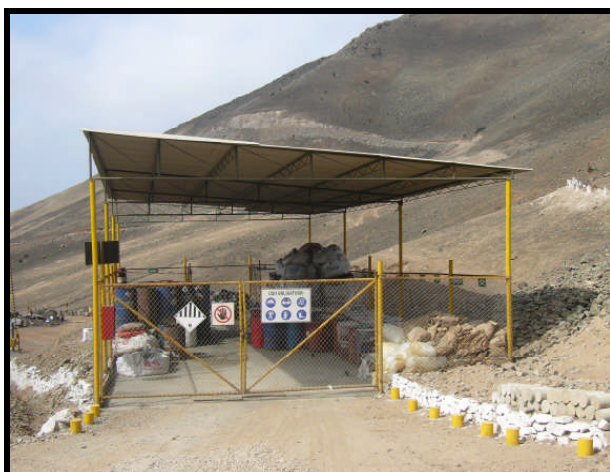
Foto N° 42: Almacén de residuos peligrosos.
