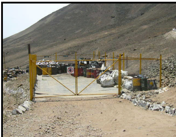
Foto N° 4: Almacén temporal de Residuos peligrosos.
