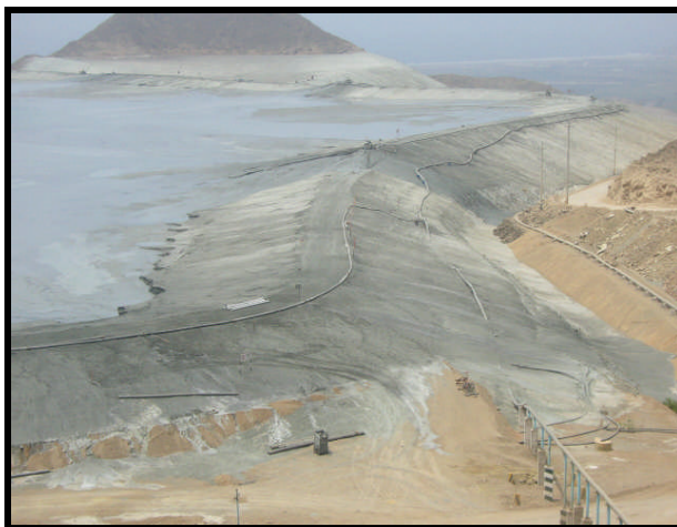
Foto N° 17: Deposito de relaves N° 3.
