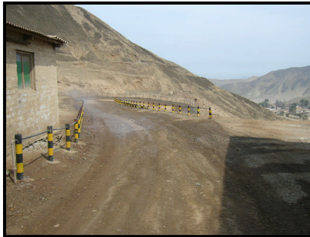
Foto N° 40: Riego de carretera por aspersión.
