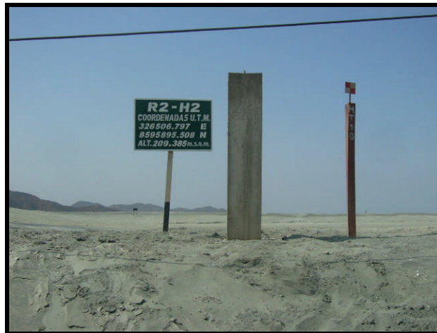
Foto N° 36: Instalación de hitos para monitoreo topográfico.
