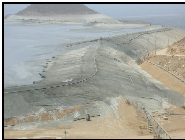
Foto N° 37: Recrecimiento del depósito de relaves.
