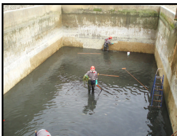
Foto N° 13: Limpieza de reservorio de agua.
