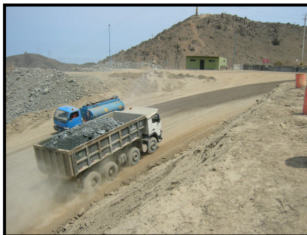
Foto N° 41: Riego de carretera con cisterna.
