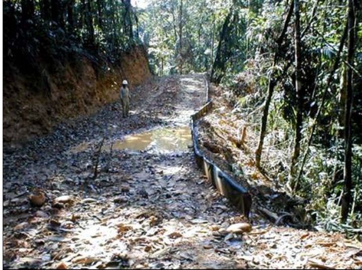
Foto 3.21.- Se realizo trabajos de Control de erosión temporal colocando geotextil a lo largo del DdV.
