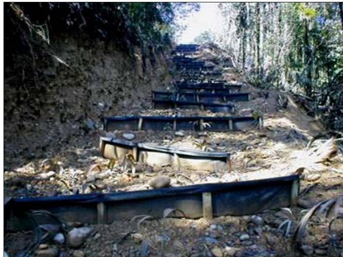
Foto 3.22.- Trabajos de Control de erosión temporal colocando cortacorrientes con barreras de geotextil a lo largo del ancho del DdV.
