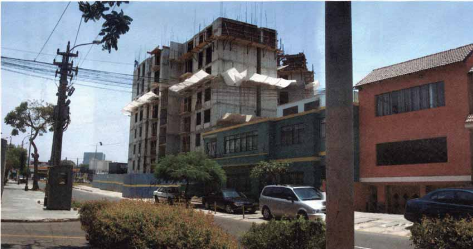
VISTA EDIFICIO SALAVERRY 2120 (desde calle Domingo Olaechea)
