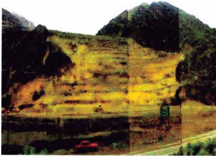
FOTO 25.- CANCHA DE RELAVE ABANDONADA
