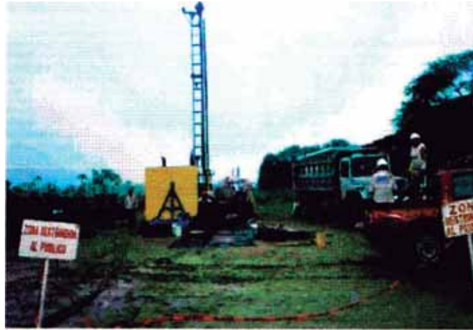
FOTO 15 PERFORACION EN LA ETAPA DE EXPLORACION
