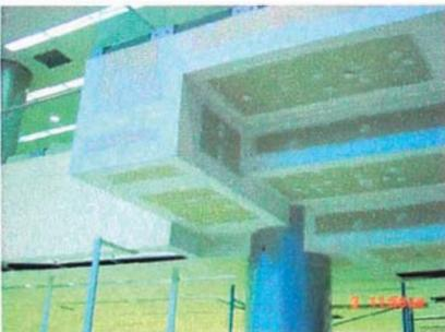
22. El drywall se usó en los acabados finales de los volúmenes internos. Aquí dando volumen a una losa ampliada, con el sistema de lámina colaborante, donde descansa la escalera metálica.
