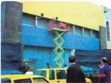
21. Vista del andén de carga y descarga ubicado en el Jr. Lampa. En la foto se aprecia los trabajos de instalación de los reflectores externos.
