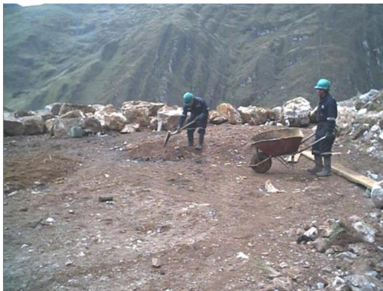
Foto 38: Cobertura de tierra-Relleno Sanitario
