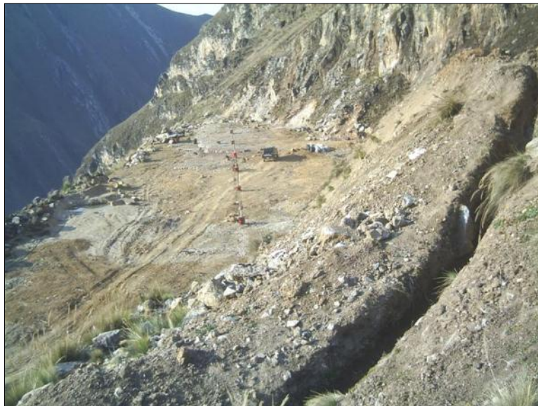
Foto 42: Relleno Sanitario y canal de coronación.
