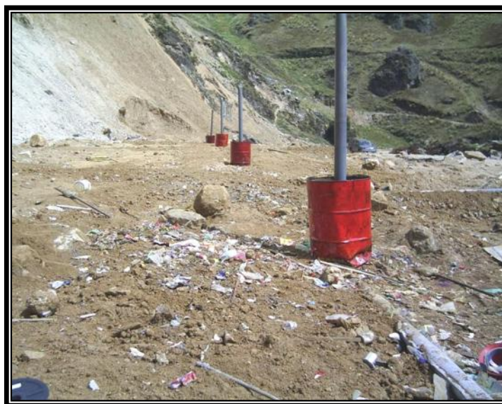
Foto 44: Sistema de ventilación.
