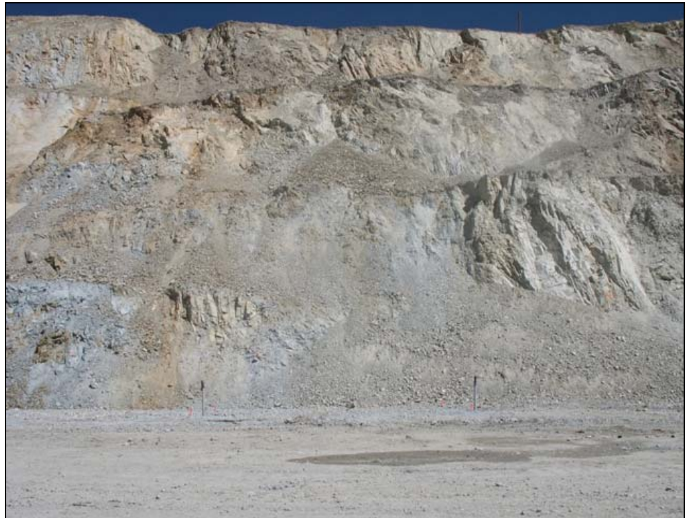
Fig. 4.4 Zona de Deslizamiento de Mina Tintaya
