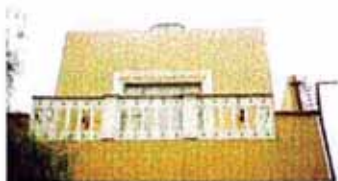
REJA DE BARANDA
