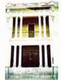
Fig. 1 DÉTALLE DE COLUMNAS NEOCLASICAS
