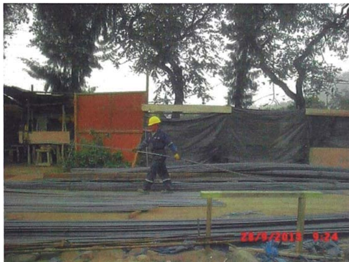
Figura 7: Acero habilitado y codificado Fuente: Fotografía de obra
