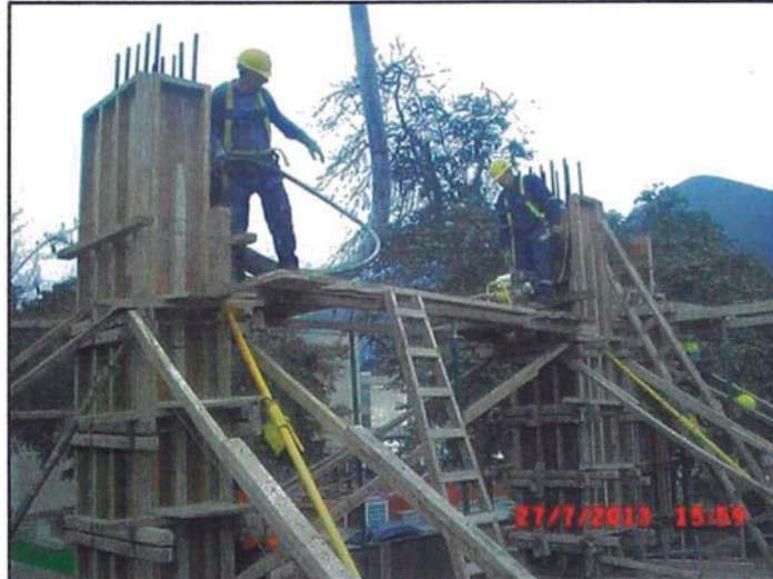
Figura 9: Encofrado con pemos
