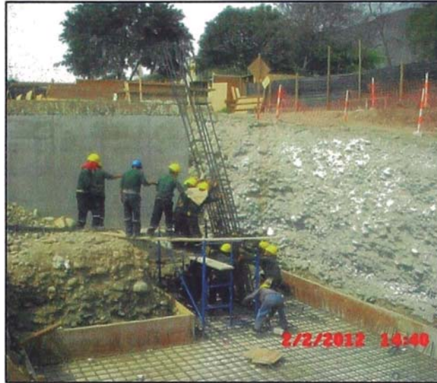
Figura 6: Colocación de acero Fuente: Fotografía de obra
