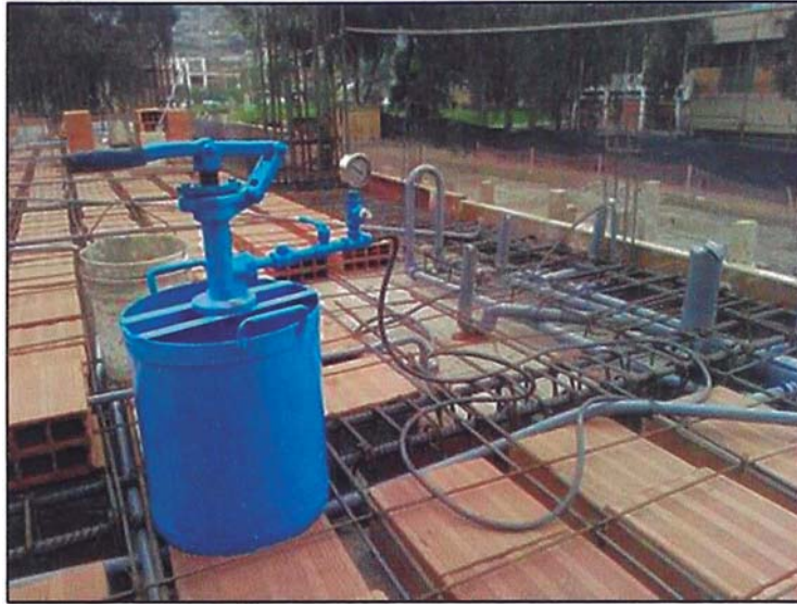
Figura 14: Prueba hidráulica a 24 horas
