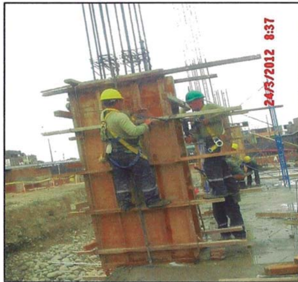
Figura 8: Encofrado con triplay 18mm y alambre #8
