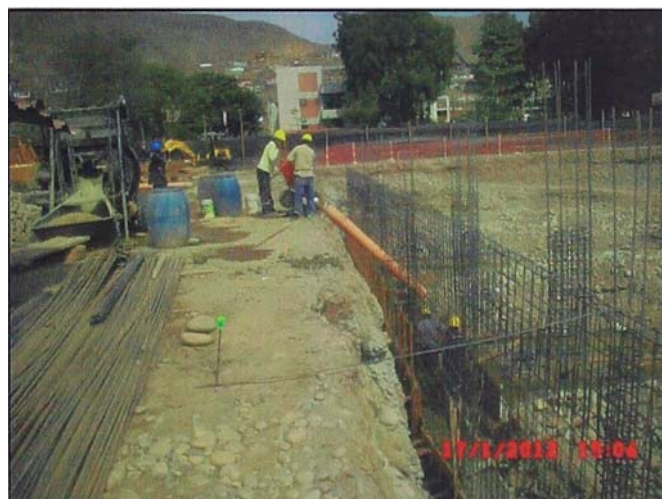
Figura 10: Concreto hecho en obra
