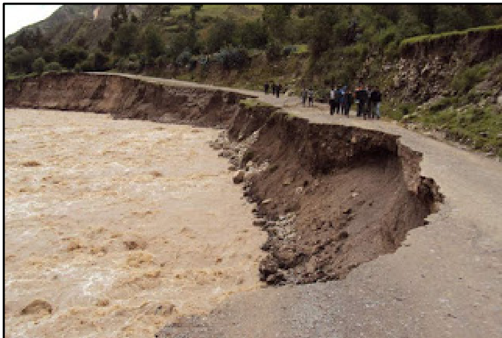
Figura 1.3 : Socavación de laderas.
