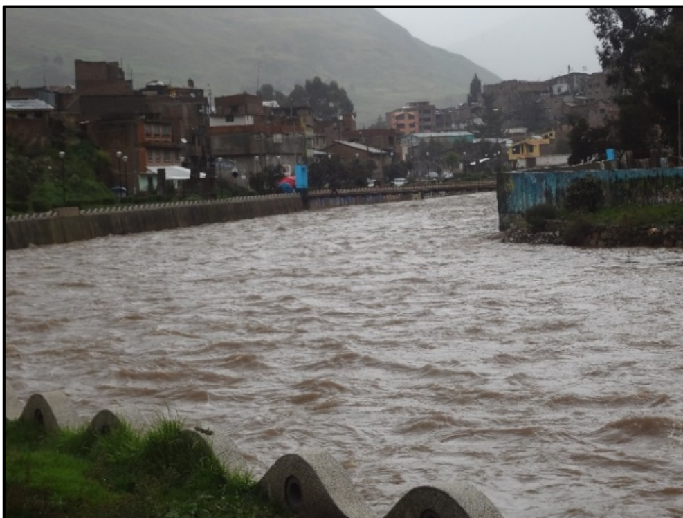
Figura 3.29 : Cauce del Rio Ichu aguas abajo tiempo de avenidas
