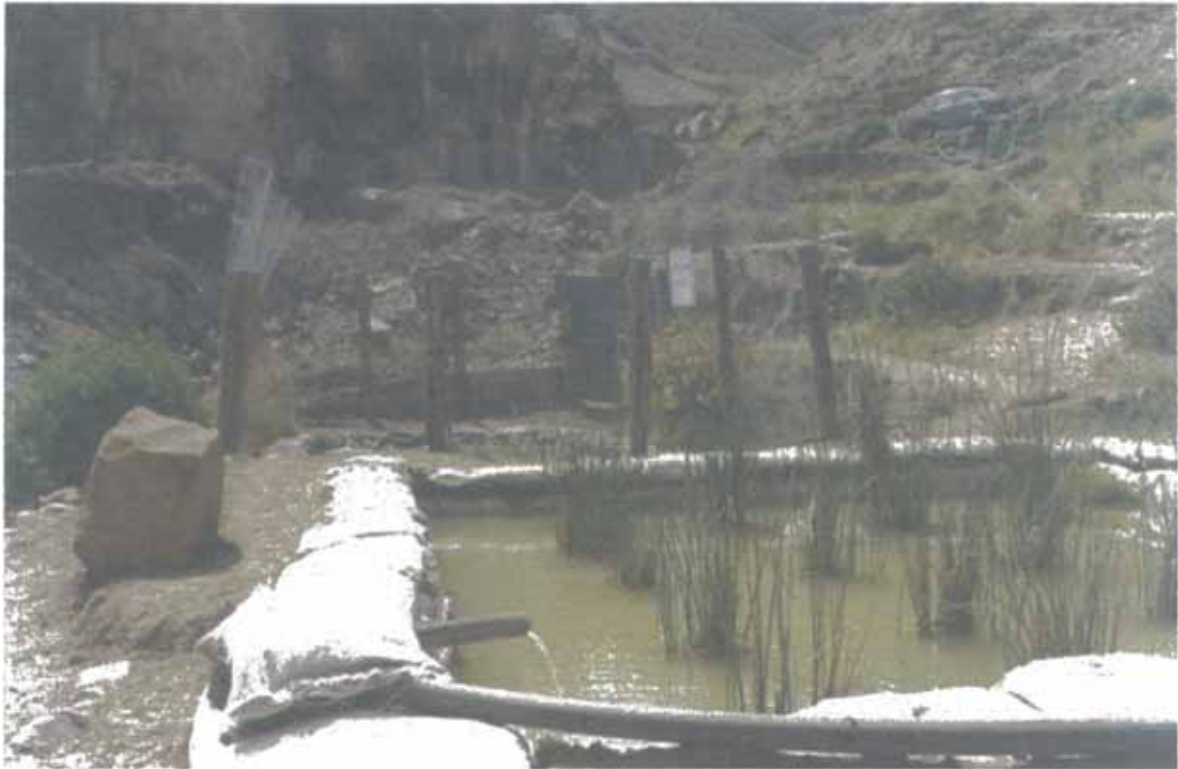
FOTO N° 26 : Poza de Investigación para el tratamiento de Aguas Acidas (Wetlands).
