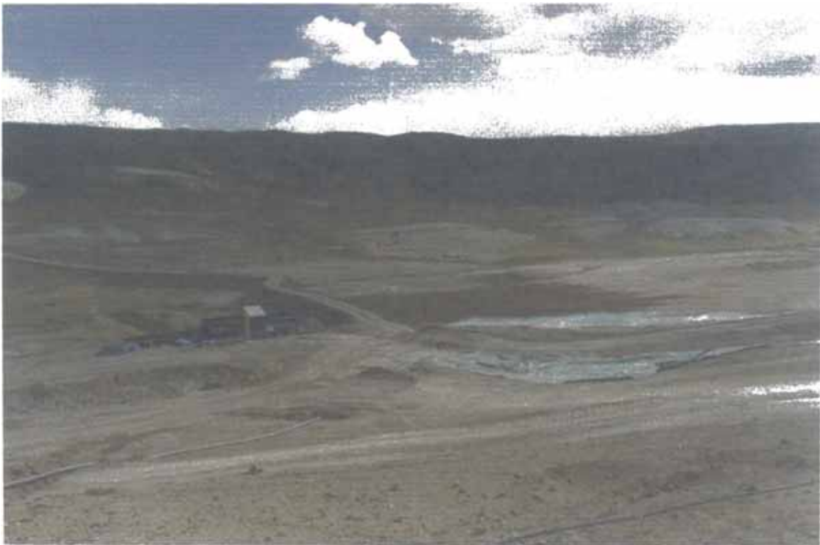
FOTO N° 33 : Vista de la presa de relave N° 1 de las Minas Ares.
