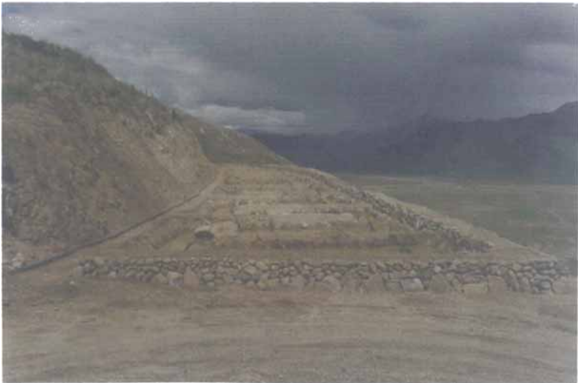
FOTO N° 27: Construcción de pozas para el tratamiento de Aguas Acidas mediante el Método de Wetlands.
