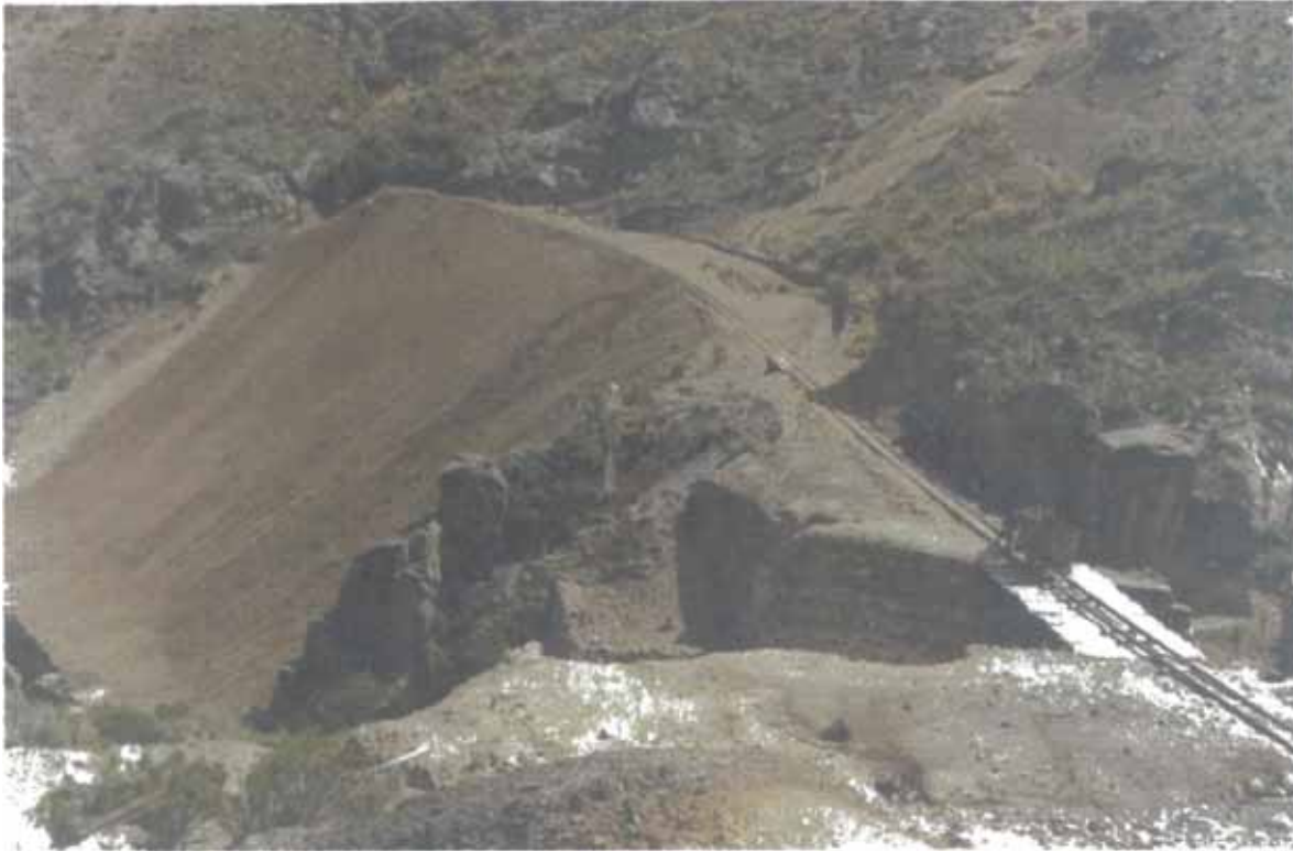
FOTO N° 28 : Encapsulamiento de desmonte en las Minas Orcopampa para el Proceso de Revegetación.
