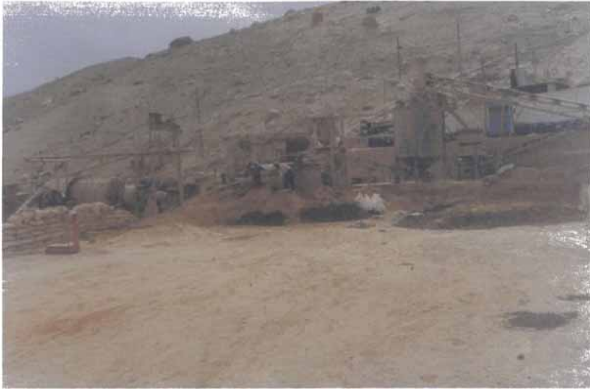
FOTO N° 14 : Planta de tratamiento Belen, mediante el método de cianuración, Chala.
