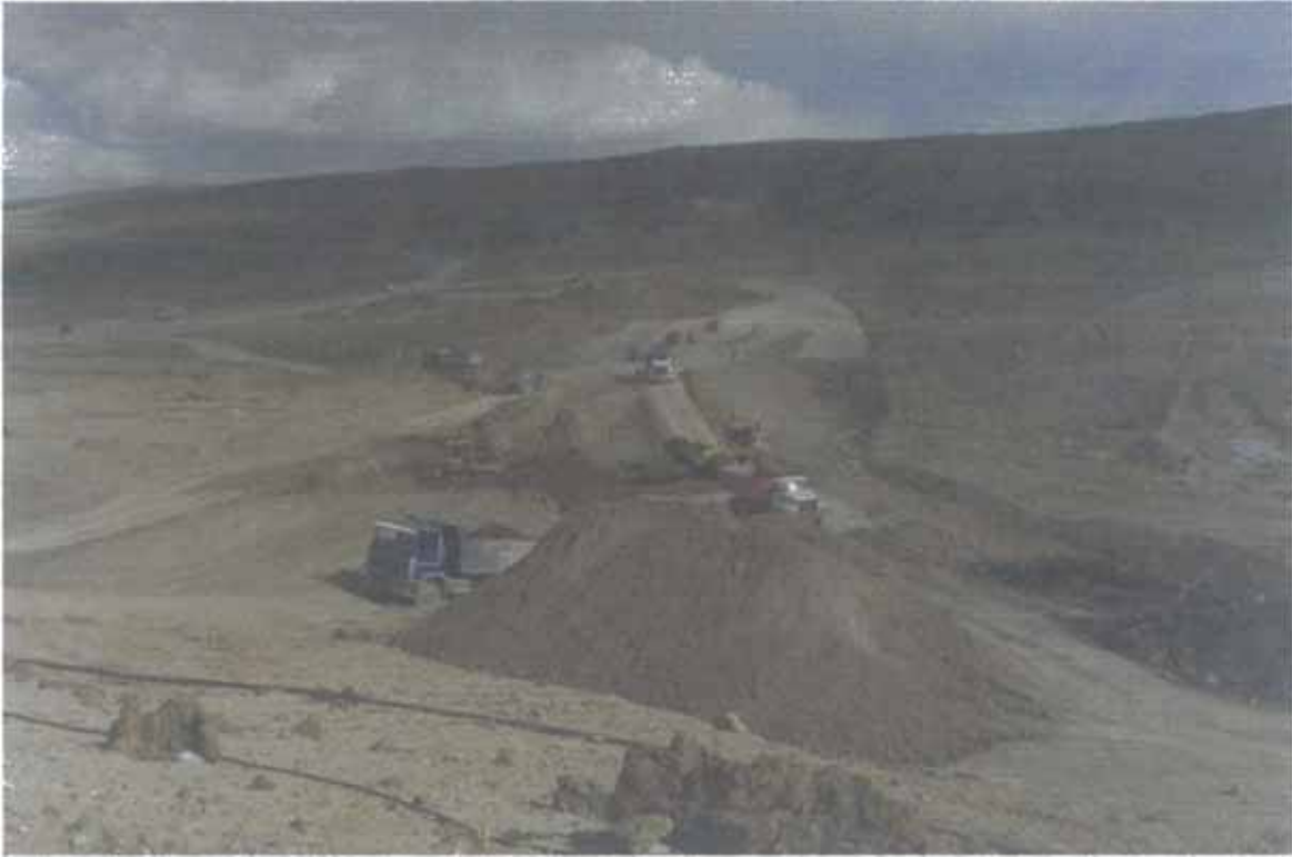
FOTO N° 34: En la imagen se observa la reparación de la presa de relave N° 2 que sufrió fracturas causado por asentamiento
