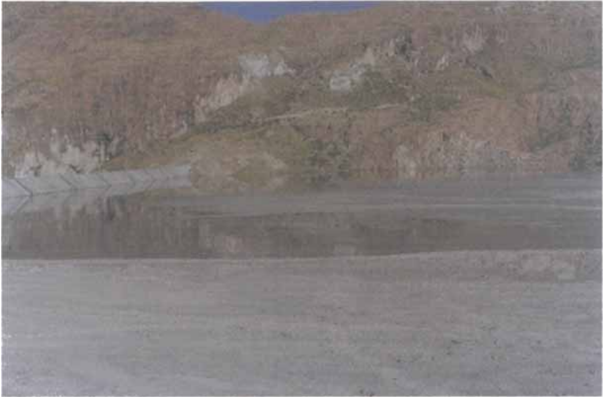
FOTO N° 20: Vista de la Presa de relave N° 5 de las Minas Arcata
