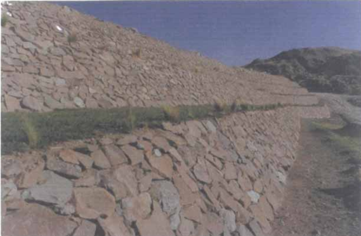
FOTO N° 22 : Muro de contención en la cancha de relave de las Minas Arcata
