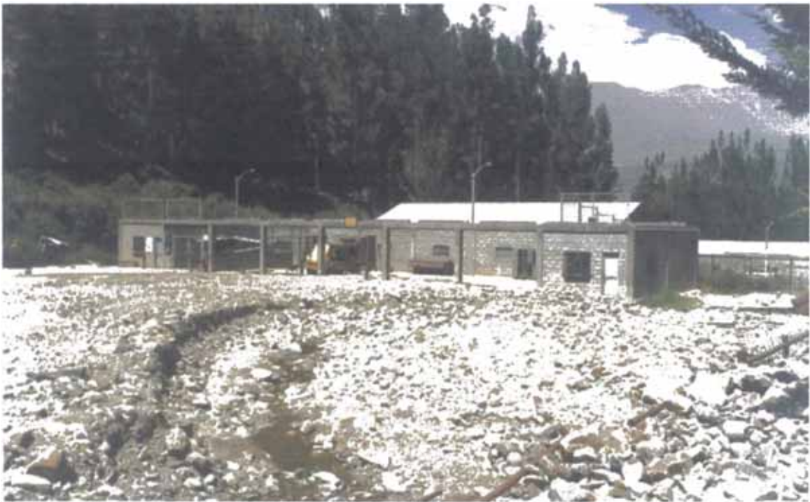
FOTO N° 38 : Vista del huayco ocurrido en las instalaciones de la Mina Madrigal (marzo 1998)
