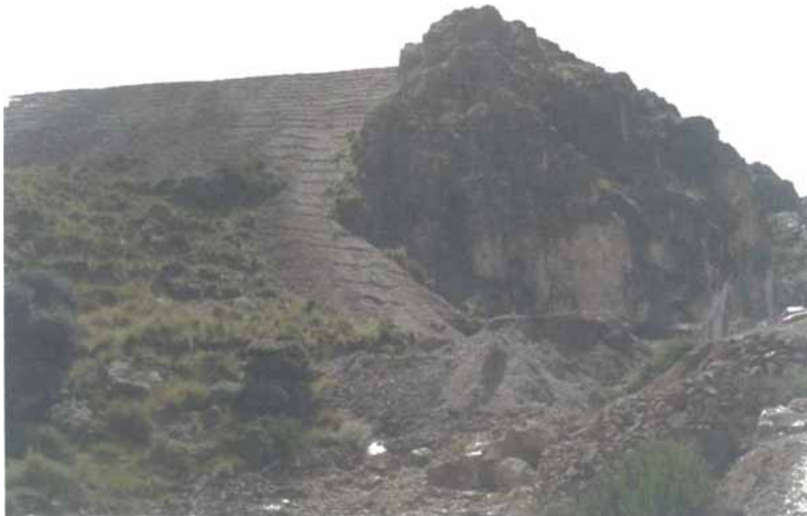
FOTO N° 29 : Encapsulamiento de desmonte y revegetación en las Minas Orcopampa.
