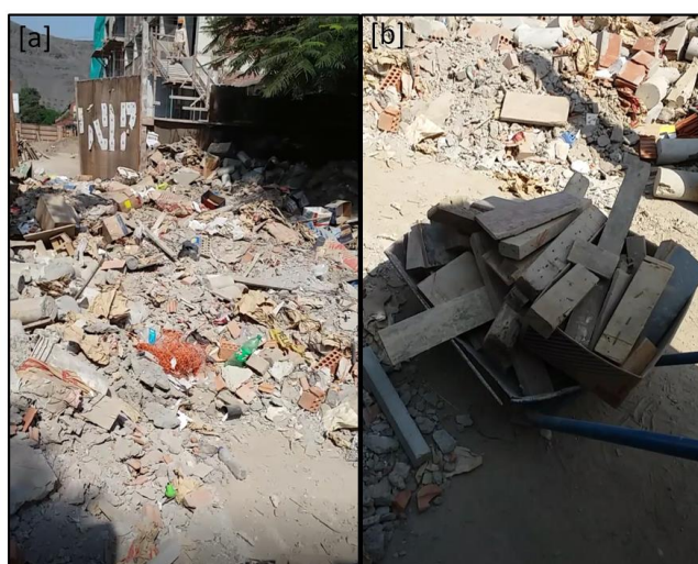
FIGURA 3.10 El combustible, (a) madera del botadero LEM-UNI, (b) madera reciclada.
