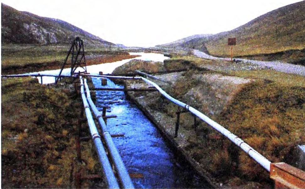
FOTO 11: Canal lateral de relaves de un centro minero vertiendo sus aguas al relaveducto matriz con rumbo a la costa desértica (Orcopampa – Arequipa) 23-09-99
