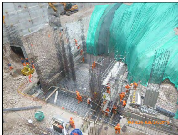
Figura N° 33: Malla anti caídas de piedras.
