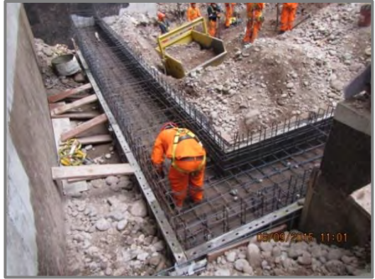
Figura N° 105: Armado de estructura de ducto de ventilación forzada para el cuarto de bombas.
