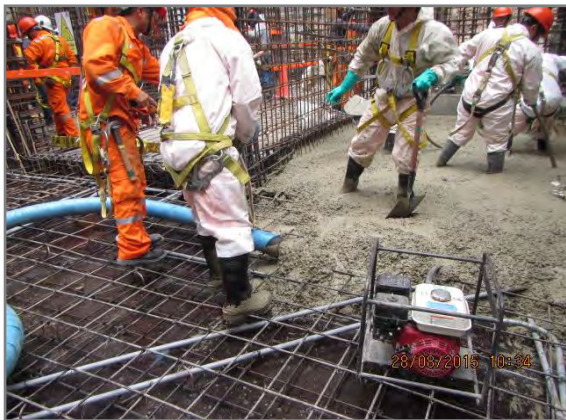
Llenado de concreto de Cuarto de bombas.
