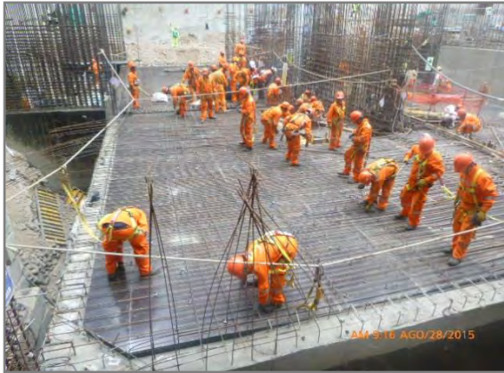
Cisterna N°1 y 2: Colocación de Acero.
