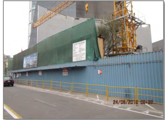
Vista Exterior: Av. República de Panamá
