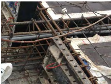
Antes - Sector 6 – piso 1
