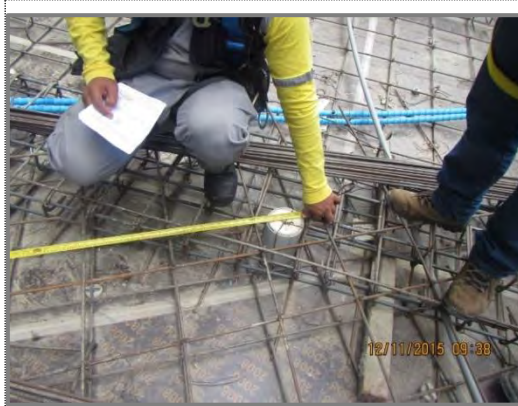
Figura N° 106: Verificación de pases para instalaciones sanitarias.
