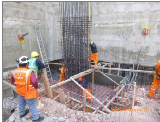
Figura N° 67: Armadura de acero para columnas.
