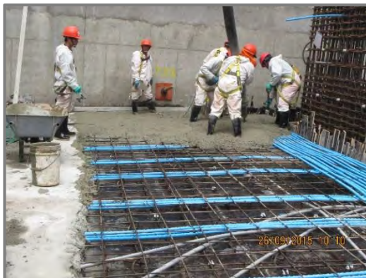
Figura N° 96: Vaciado de concreto de losas postensadas.
