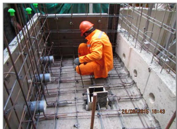
Acero: Limpieza de Acero.
