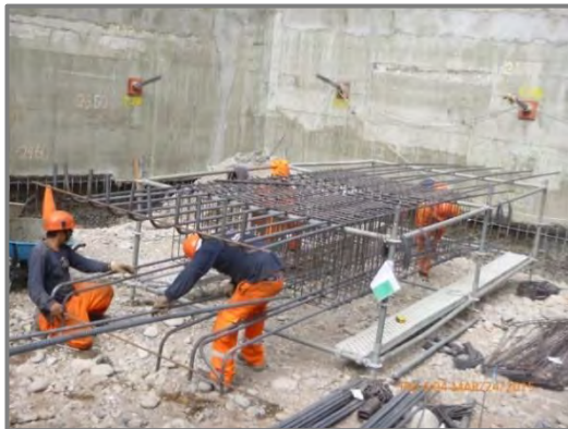
Figura N° 66: Habilitación de acero para columnas.
