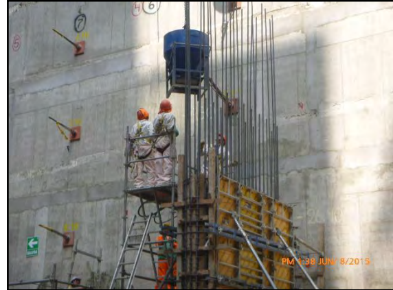
Columnas: Trabajos de vaciado.
