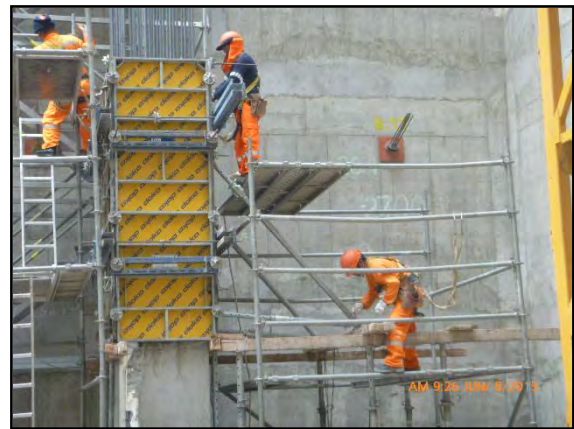
Columnas: Trabajos de encofrado.
