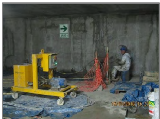
Figura N° 101: Inyección de lechada del sistema de postensado.
