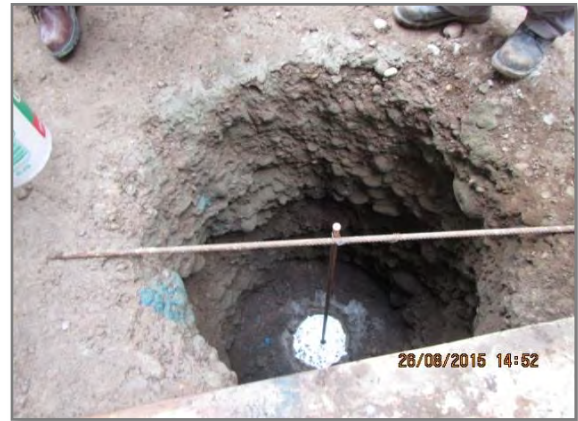
Instalación de malla a tierra
