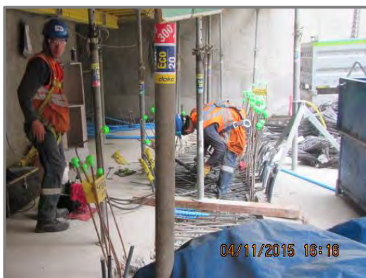
Figura N° 100: Tensado de cables del sistema postensado.
