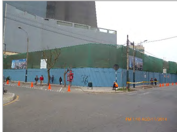
Figura N° 13: Vista exterior del proyecto.
