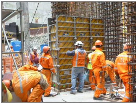
Figura N° 74: Encofrado de placas.
