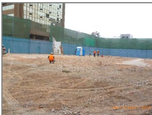
Figura N° 56: Entrega de terreno a la Contratista.
