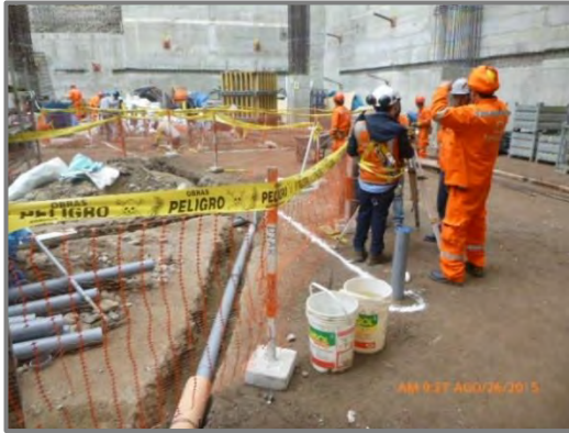
Figura N° 102: Instalación de redes de desagüe, para estacionamientos a nivel de sótano 09.
