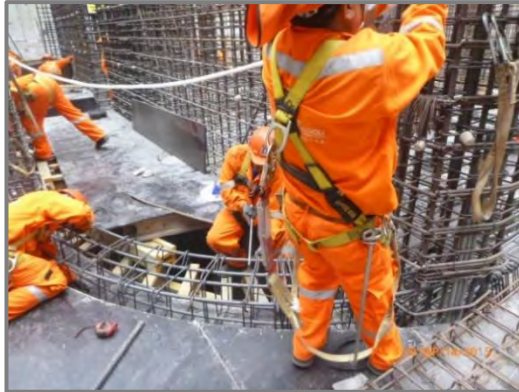
Figura N° 70: Colocación de acero en placas y vigas.
