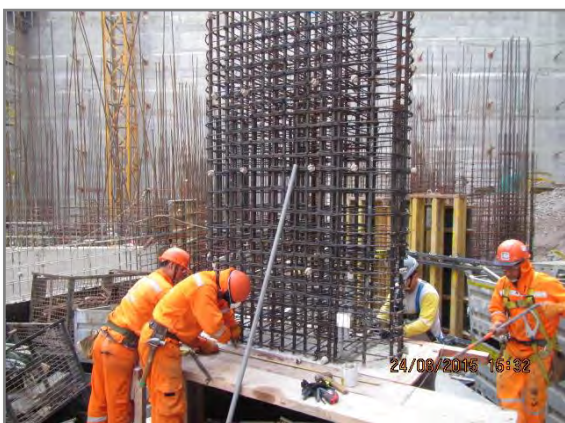
Cámara de Bombeo: Limpieza de Acero.
