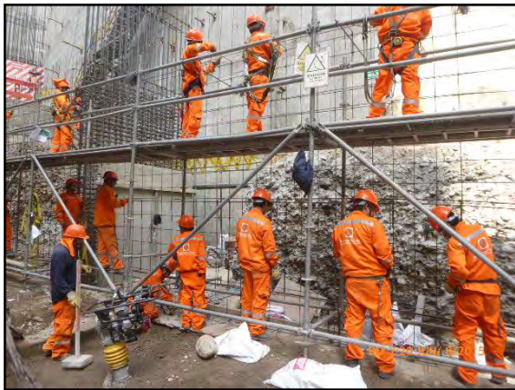
Muros de Cisterna: Aceros en muros.
