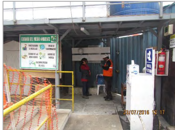
Figura N° 15: Ingreso personal de subcontratista.
