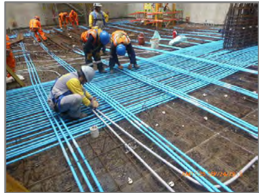
Figura N° 95: Trabajos de instalaciones eléctricas y sanitarias.
