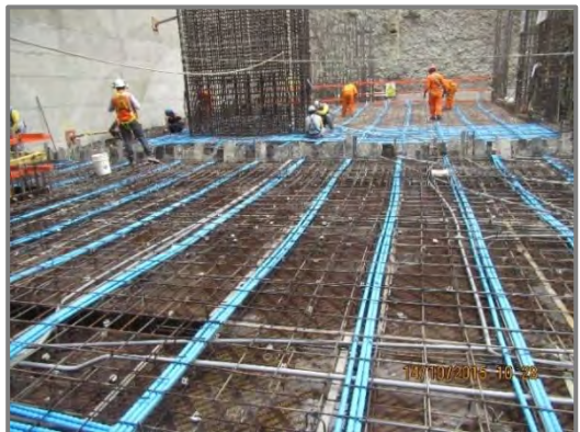
Figura N° 93: Estado estructural de la losa postensado a nivel de sótanos.
