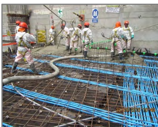
Figura N° 88: Vaciado de concreto de losas postensadas.
