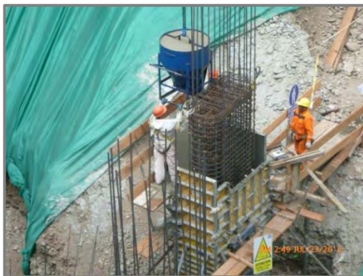
Figura N° 86: Vaciado de concreto de columna a nivel de sótanos.
