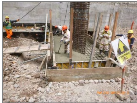
Figura N° 85: Vaciado de concreto de zapatas en columnas.
