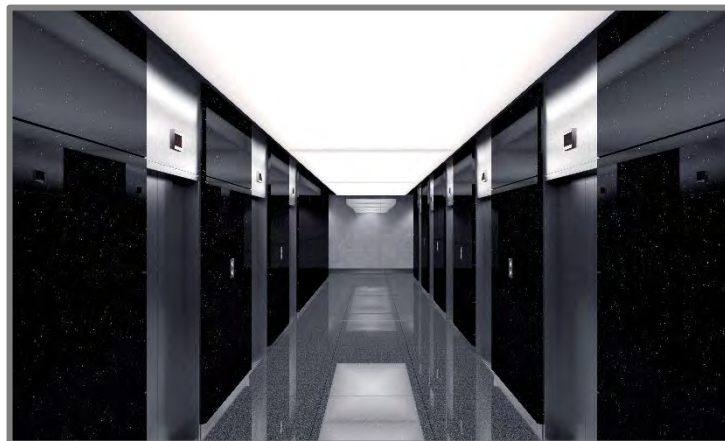
Figura N° 5: Batería de ascensores, diez (10) en total.
