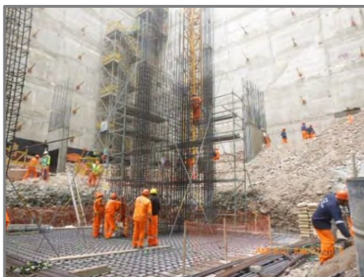
Figura N° 68: Armadura de acero del núcleo central, ducto de ascensores.
