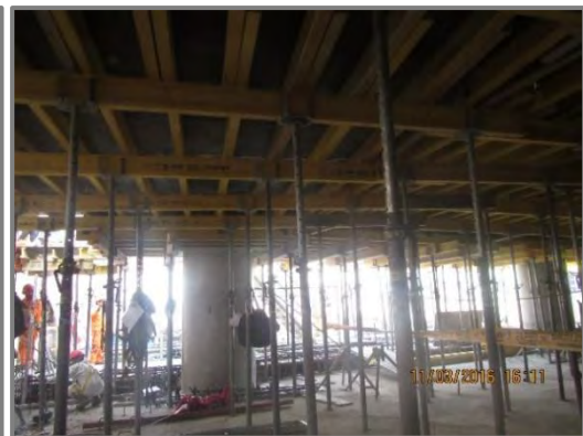
Figura N° 81: Encofrado de losas postensada, vista de fondo.
