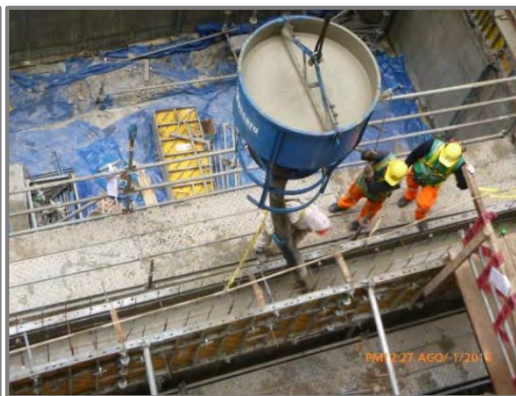
Figura N° 87: Vaciado de concreto de placas de cisterna doméstica.
