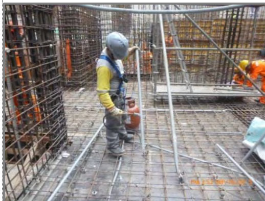
Figura N° 108: Instalación de tuberías para instalaciones eléctricas y automatización en losas.
