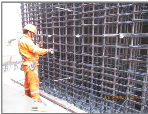
Figura N° 72: Colocación de acero en muros.
