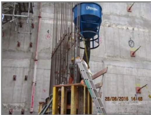
Figura N° 84: Vaciado de concreto de columna a nivel de sótanos.
