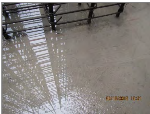
Figura N° 98: Curado de losa postensada.
