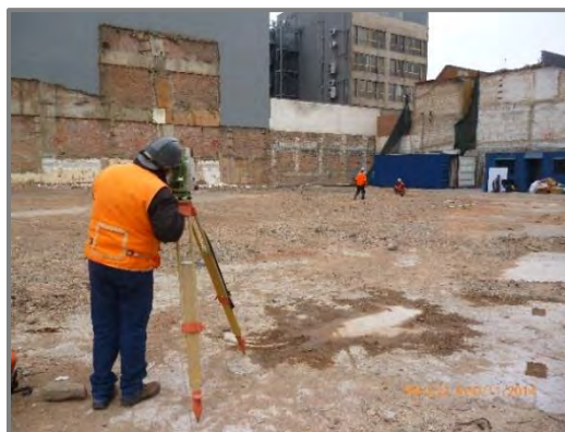
Figura N° 57: Replanteo de ejes.
