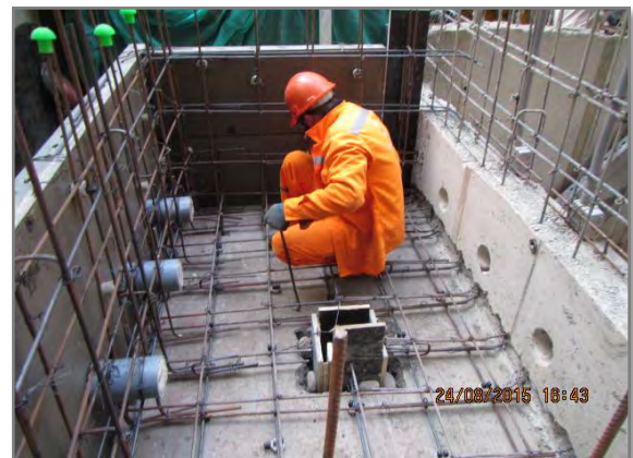
Acero: Limpieza de Acero.
