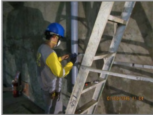
Figura N° 109: Instalación de montantes de desagüe en sótanos.
