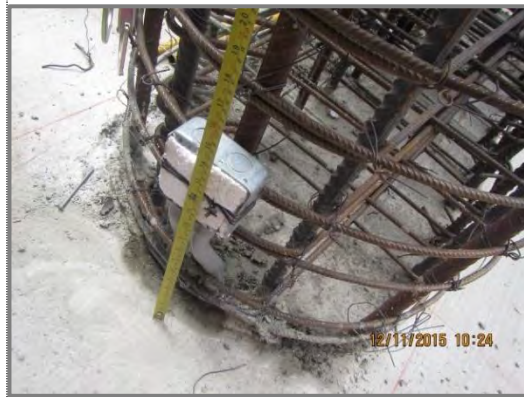
Figura N° 107: Verificación de altura de tomacorriente.
