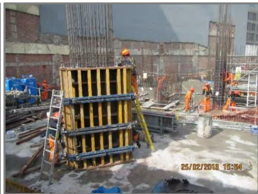
Figura N° 77: Encofrado de columnas a nivel de sótanos.
