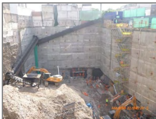
Figura N° 59: Trabajo de excavación con faja nivel -31.25 mts.
