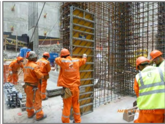
Figura N° 75: Encofrado de columnas a nivel de cisternas.
