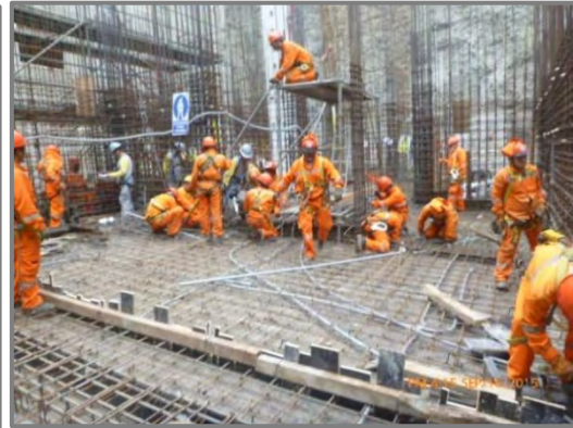
Figura N° 71: Colocación de acero en losas.
