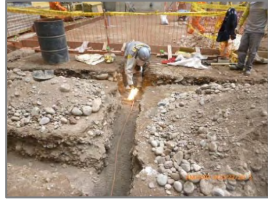
Figura N° 103: Instalación de mallas de puesta a tierra, soldadura exotérmica.
