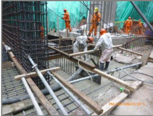
Figura N° 82: Vaciado de concreto del núcleo central.
