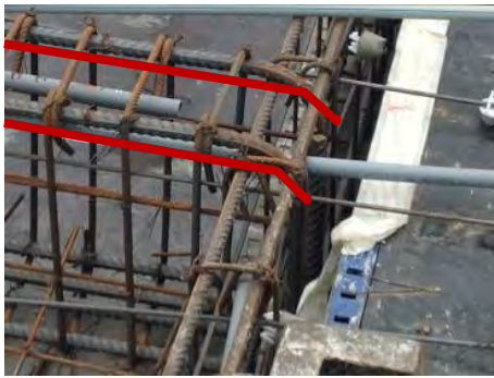
Antes - Sector 2 – piso 1
