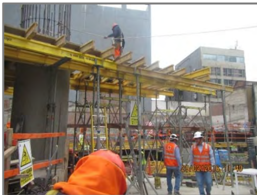
Figura N° 80: Encofrado de viga perimetral a nivel del sótano 01.
