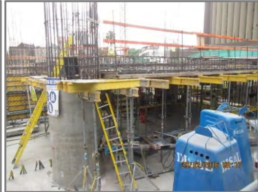
Figura N° 79: Encofrado de viga perimetral a nivel del sótano 01.
