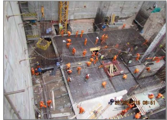
Cisterna N°1 y 2: Colocación de Acero.
