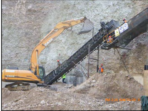
Eliminación: Desmontaje de faja
