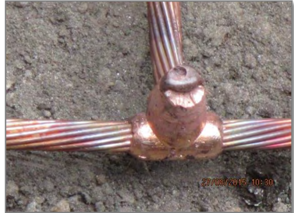
Instalación de malla a tierra
