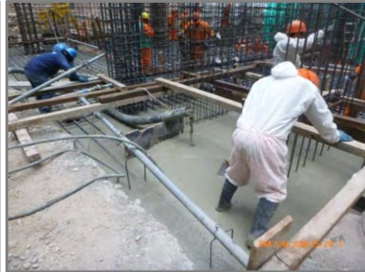
Figura N° 83: Continuación del vaciado de concreto del núcleo central.
