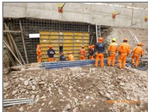
Figura N° 64: Encofrado de muro anclado.
