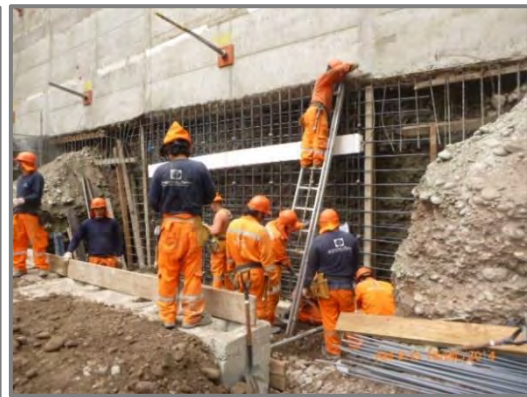
Figura N° 63: Aplome de muro anclado, se realizó la verificación in situ.
