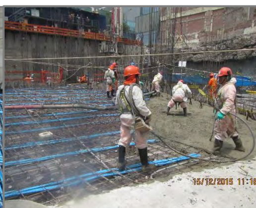
Figura N° 89: Vibrado en losa postensada.
