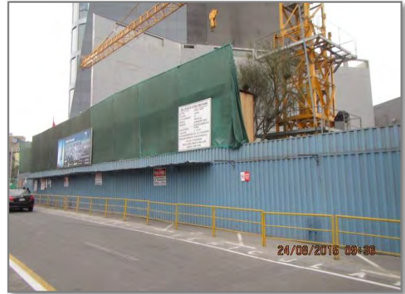
Vista Exterior: Av. República de Panamá
