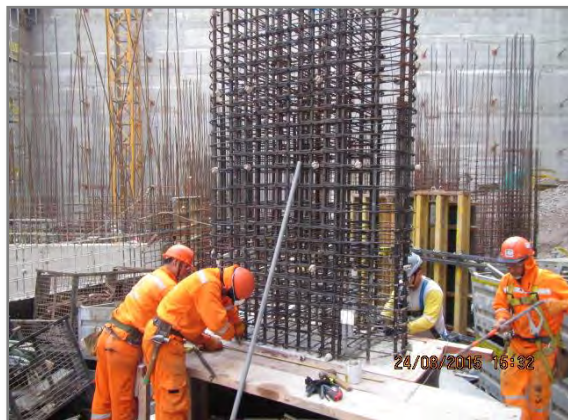
Cámara de Bombeo: Limpieza de Acero.
