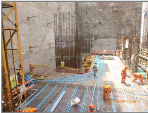
Figura N° 90: Instalación de cables postensados y primera malla de refuerzo.
