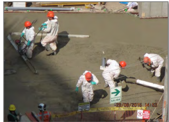
Llenado de concreto de Losa de Piso.
