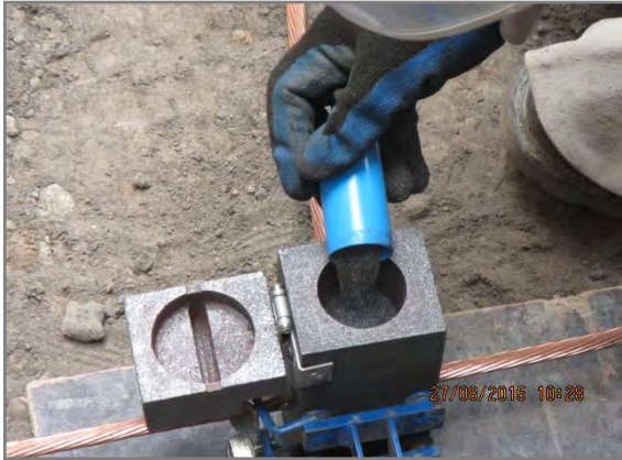
Instalación de malla a tierra
