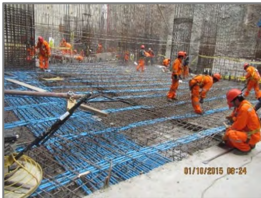
Figura N° 92: Instalación de segunda malla de refuerzo.
