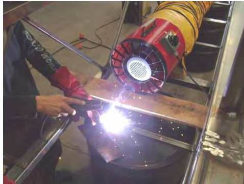
Extracción o aspiración de aire
