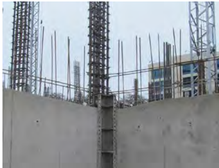
Antes: Sector 2 – piso 1
