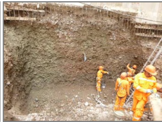
Figura N° 61: Perfilado de terreno, se verificó los trazos del muro anclado.
