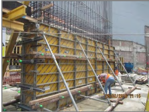
Figura N° 78: Encofrado de placas a nivel de sótanos.
