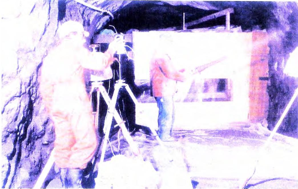
**La colocación de shotcrete requiere una atención constante para el control de la presión, el volumen de suministro de agua, mezclado y aire para garantizar que el material sea colocado de manera continua e interrumpida para lograr una colocación de buena calidad, bien compacta y con un mínimo porcentaje de rebotes del material.**
