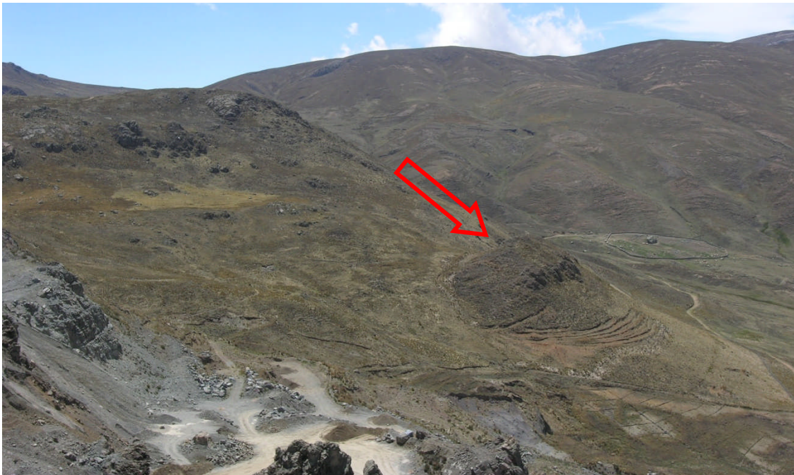
Foto N° 33: Lado oeste del "Leach pad". Megabloque de flujo andesítico deslizado sobre rocas sedimentarias de la Fm. Carhuaz (E. Manrique/set. 2006)
