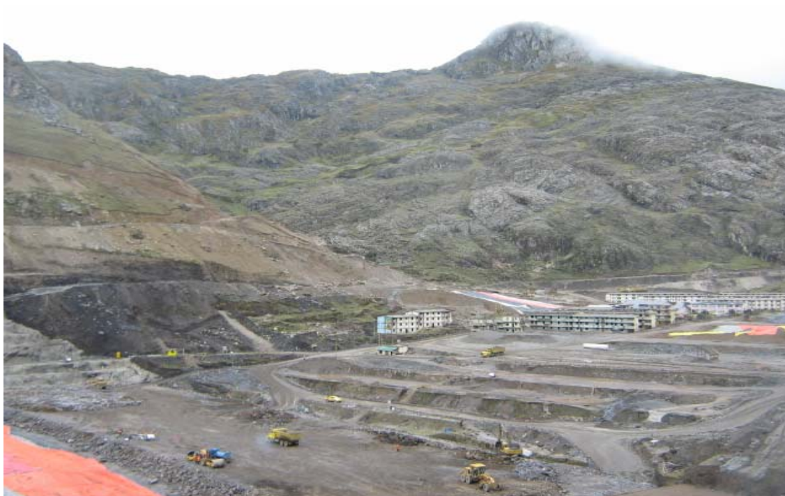
Foto 2: Preparación del suelo donde se construyó la relavera Vaso Atacocha
