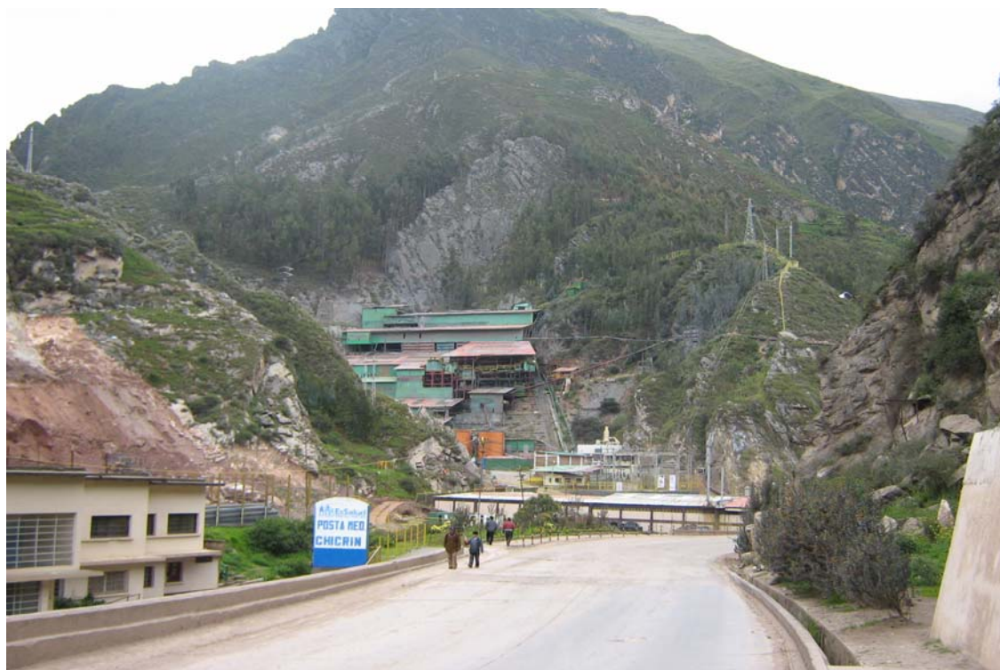
Foto 10: Al fondo se observa la Planta Concentradora “Chicrin N° 2”
