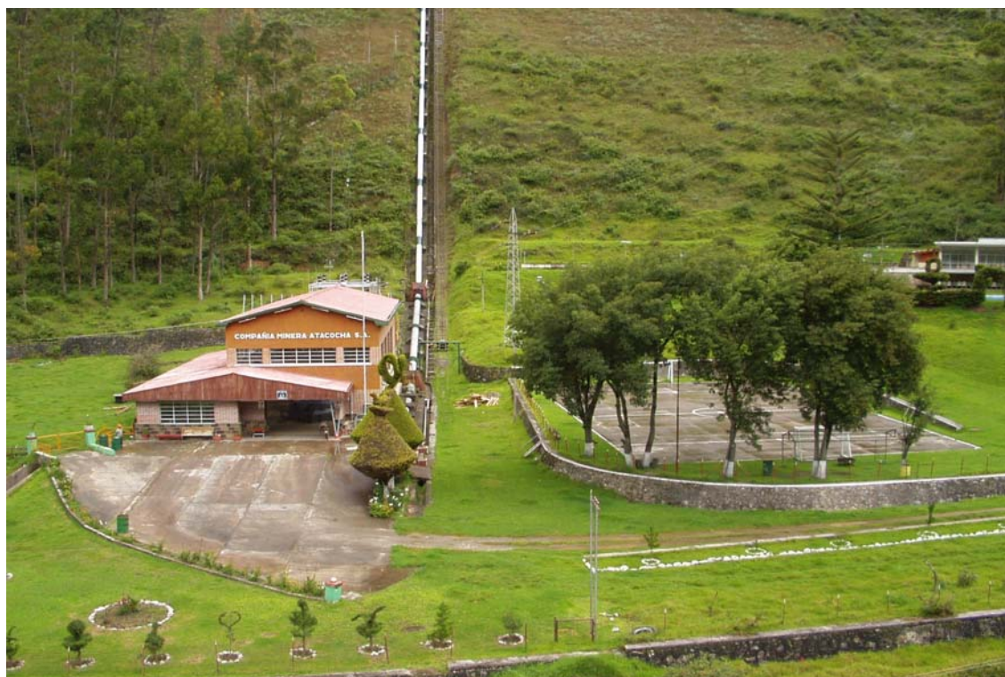
Foto 11: Vista panorámica de la Central Hidroeléctrica de Chaprin
