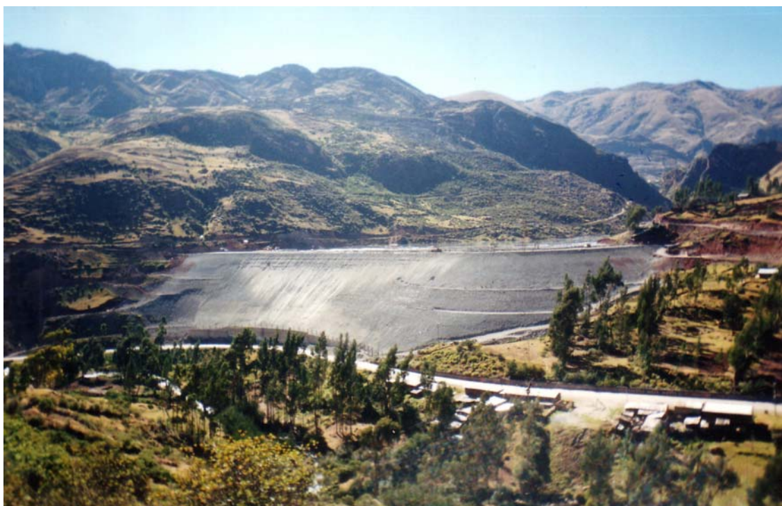
Foto 9: Depósito de relaves Tielacayán y la Carretera Central en el pie del talud.
