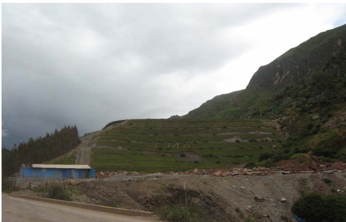
Foto 6: Relavera Chicrin, obsérvese el frente y el lado este del talud revegetado
