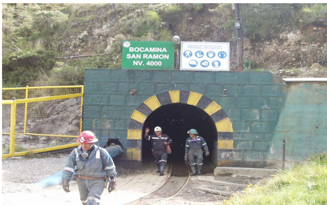
Foto 12: Entrada a la bocamina San Ramón. Nivel 4000
