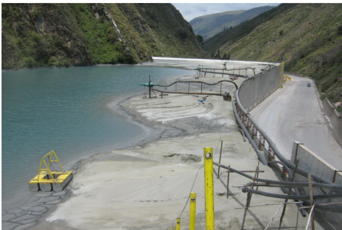
Foto 8: Depósito de relaves Cajamarquilla, vaso N° 3, y colmatado con relaves.
