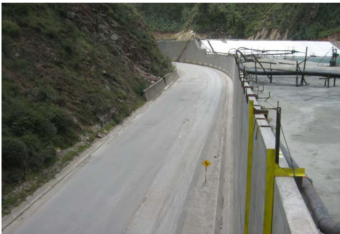
Foto 7: Depósito de relaves Cajamarquilla, al fondo el Vaso N° 2.
