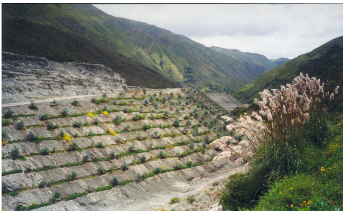
Foto 4: Revegetación del talud del depósito de relaves Chicrin
