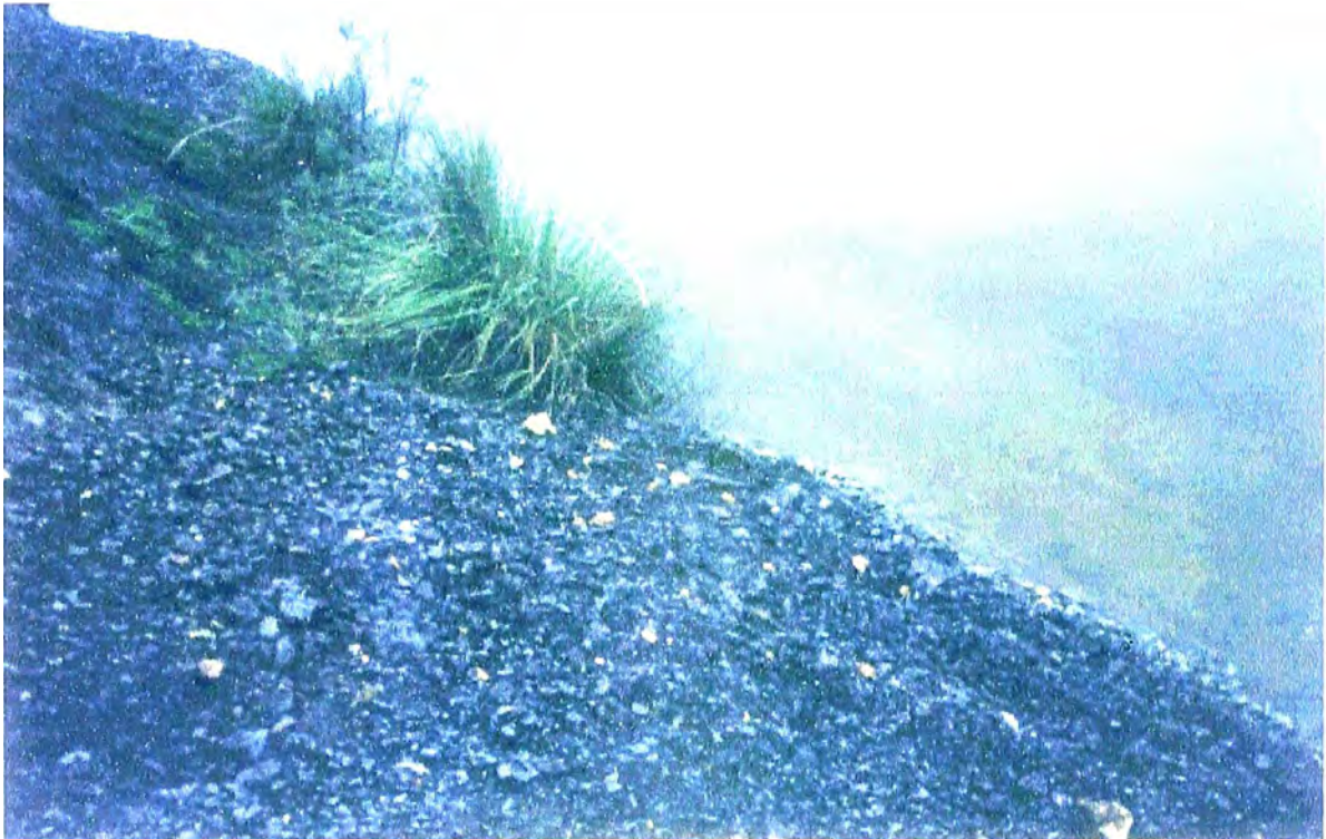
ACUMULACIÓN DE ESCORIAS EN BORDE DE LAGUNA SAN FRANCISCO
