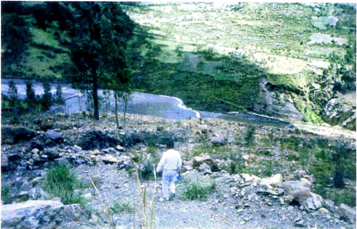
VISTA AL FONDO DE EMPLAZAMIENTO DE LA RELAVERA DE LA CONCENTRADORA HUALLANCA EN MARGEN DERECHA DEL RÍO TORRES
