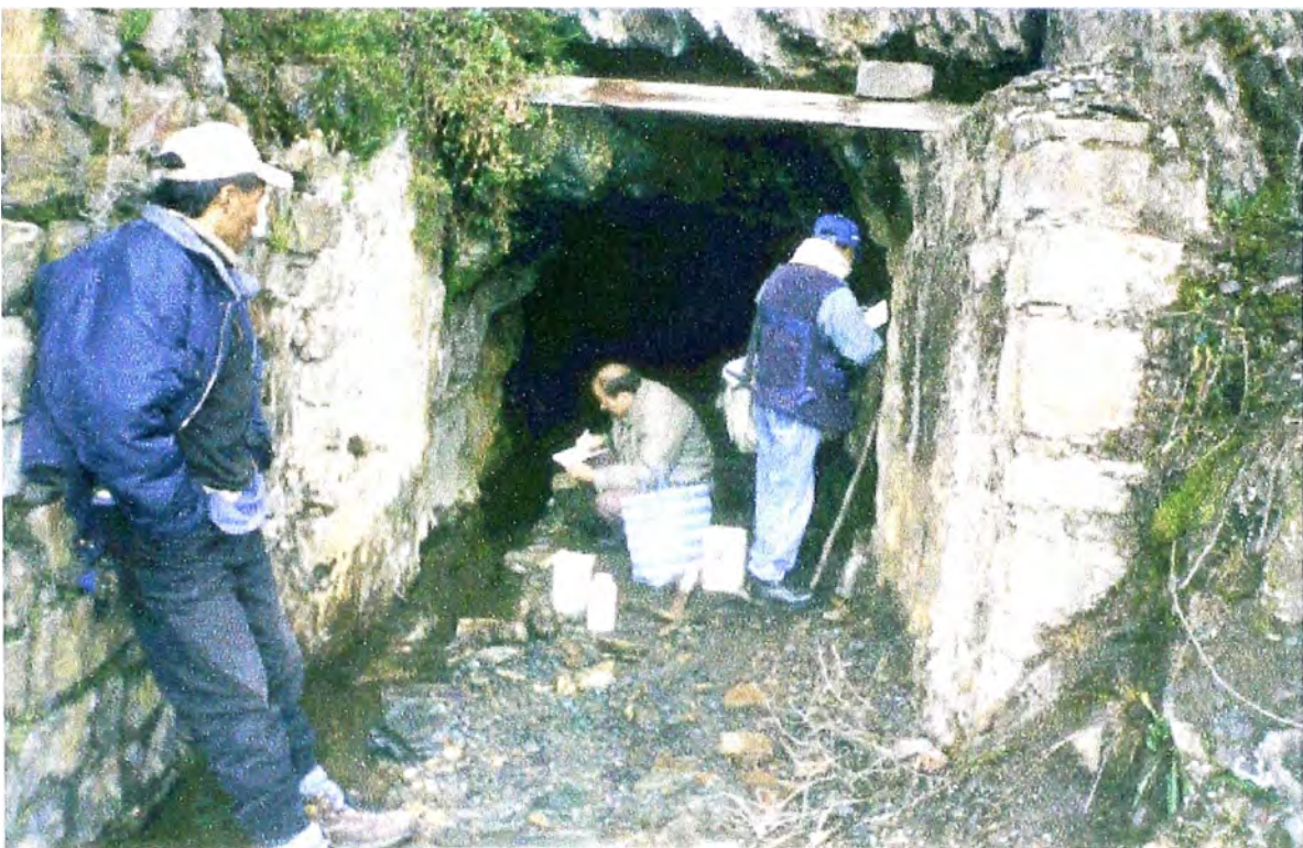
BOCAMINA PRINCIPAL REFORZADA CON BLOQUES DE ROCA CUARCITA Y DRENAJE ÁCIDO
