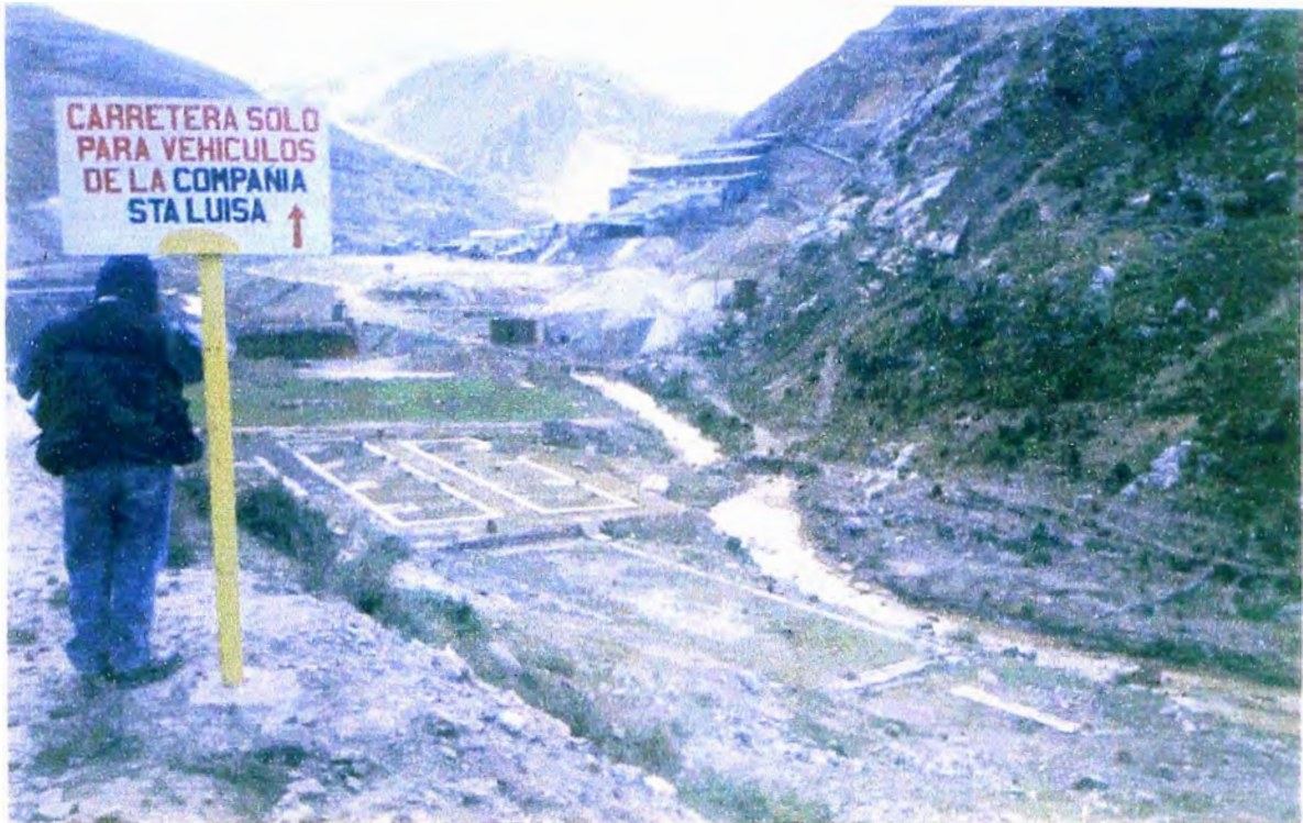
VISTA DE PLANTA CONCENTRADORA Y BOCAMINA DE MINA HUANZALA
