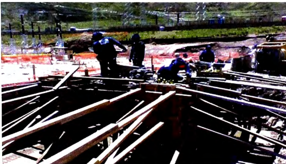
Figura N° 7.9: Fotografía, Trabajos de vaciado y encofrado de pedestales en Plataforma N° 3 Fuente: Propia, tomada en etapa de ejecución de obra
