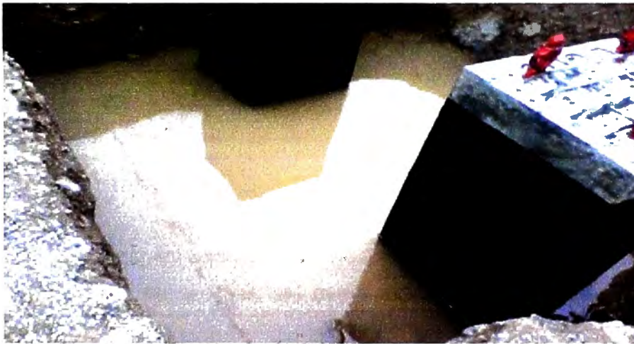
Figura N° 9.6: Fotografía, empozado de bases por aguas pluviales Fuente: Propia, tomada en etapa de ejecución de obra
