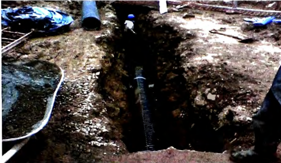
Figura N° 7.18: Fotografía, Instalación de tubería de 10" de Sistema de Drenaje Plataforma N° 03 Fuente: Propia, tomada en etapa de ejecución de obra
