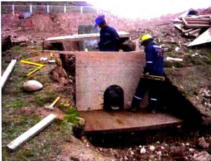
Figura N° 7.20: Fotografía, encofrado de disipador en desfuegos de drenaje Fuente: Propia, tomada en etapa de ejecución de obra
