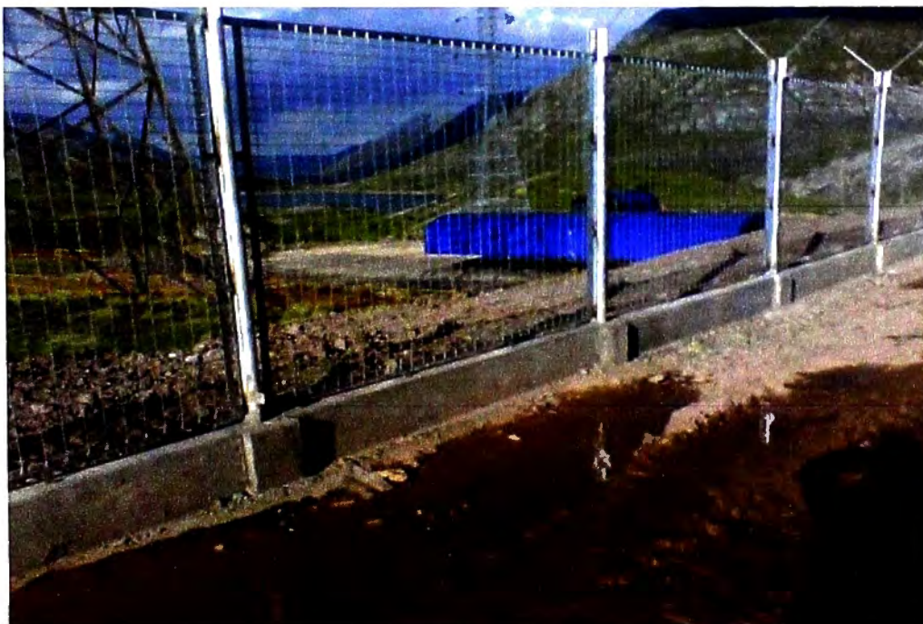
Figura N° 7.25: Fotografía, Cerco de cerramiento con malla soldada en plataforma N° 3. Fuente: Propia, tomada en etapa de ejecución de obra.
