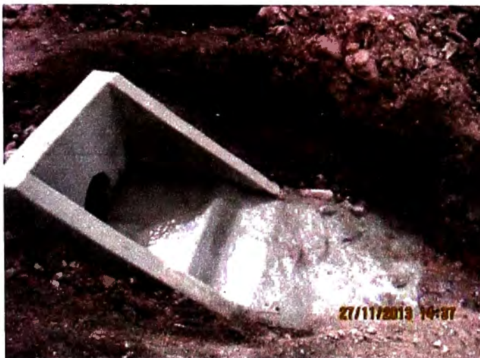
Figura N° 7.21: Fotografía, acabado de disipador en desfuegos de drenaje. Fuente: Propia, tomada en etapa de ejecución de obra.
