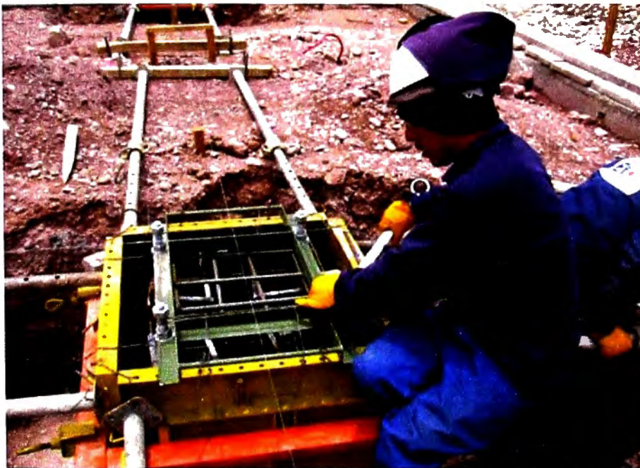
Figura N° 7.12: Fotografía, verificación de ejes y niveles de pernos de anclaje. Fuente: Propia, tomada en etapa de ejecución de obra
