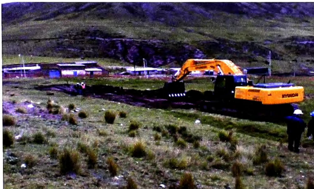
Figura N° 7.1: Fotografía Corte de la capa vegetal en zona de ampliaciones Fuente: Propia, tomada en etapa de ejecución de obra
