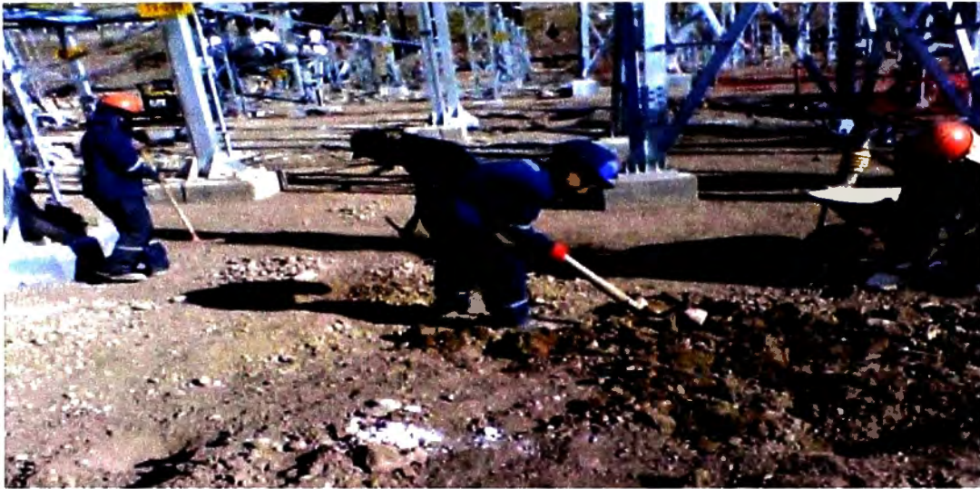
Figura N° 7.30: Fotografía, Perfilado de terreno y nivelación en plataforma N° 3.
