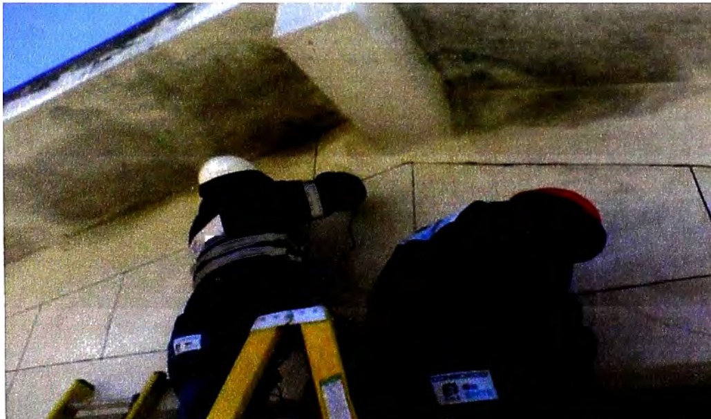
Figura N° 7.26: Fotografía, Instalación del cable de cobre N° 16 Celda Faraday en Sala de Control Fuente: Propia, tomada en etapa de ejecución de obra.
