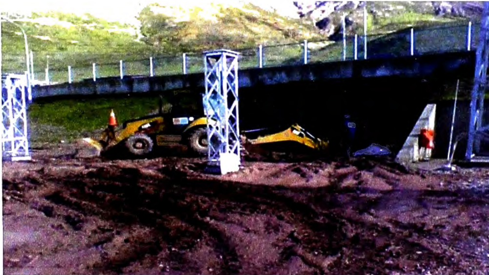
Figura N° 7.7: Fotografía, Trabajos de excavación de pórticos de barra en talud Plataforma N° 1 Fuente: Propia, tomada en etapa de ejecución de obra
