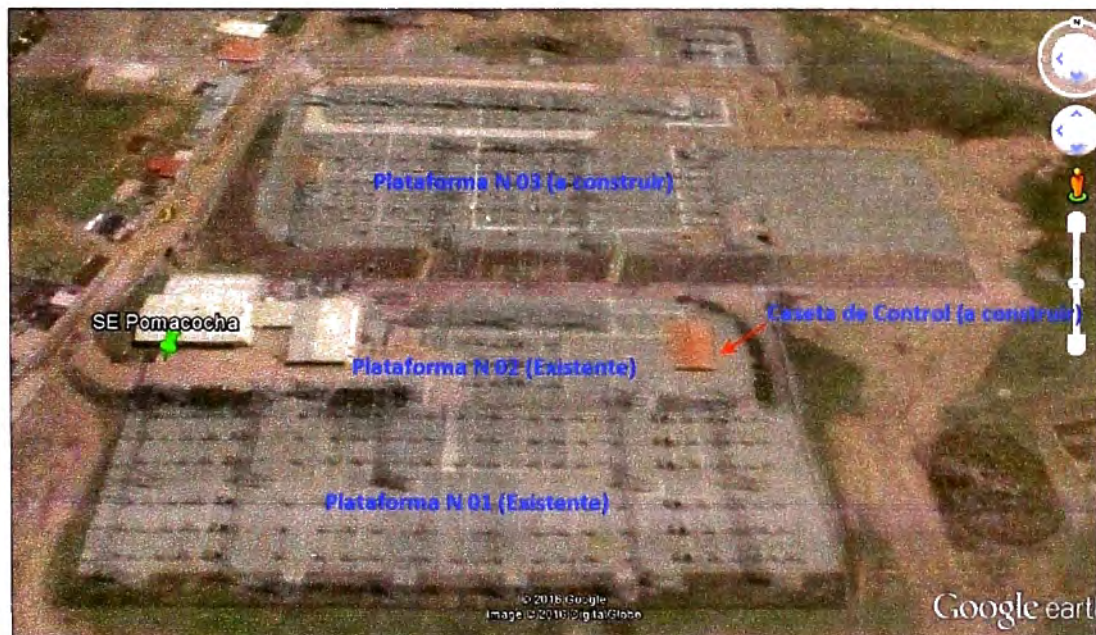
Figura N° 4.1: Fotografía aérea donde muestra plataformas existentes y a construir de la subestación Pomacocha.
