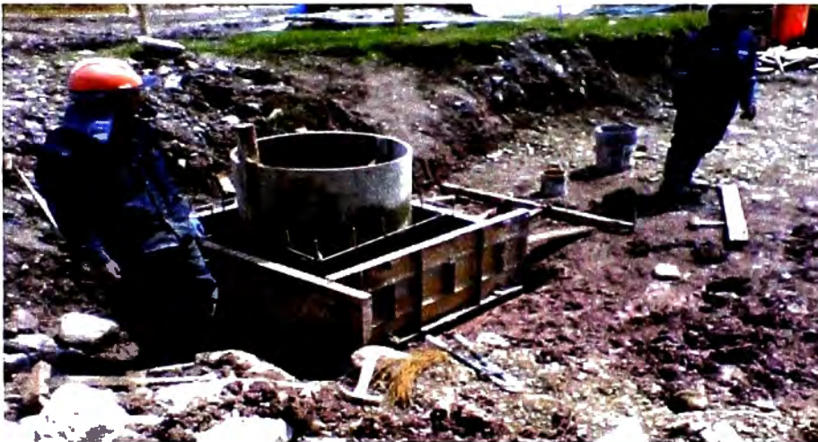
Figura N° 7.22: Fotografía, encofrado de buzones para drenaje en Plataforma N° 3. Fuente: Propia, tomada en etapa de ejecución de obra.
