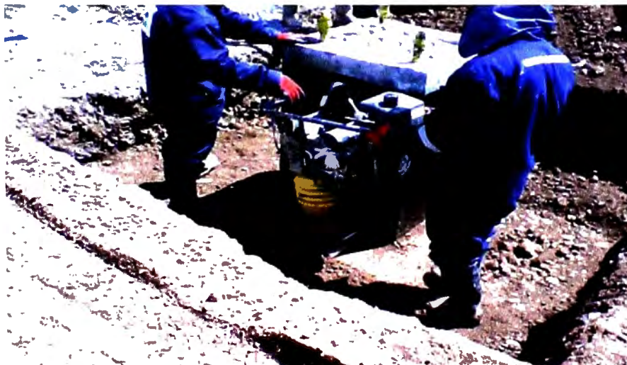
Figura N° 7.14: Fotografía, trabajos de compactación de bases. Fuente: Propia, tomada en etapa de ejecución de obra
