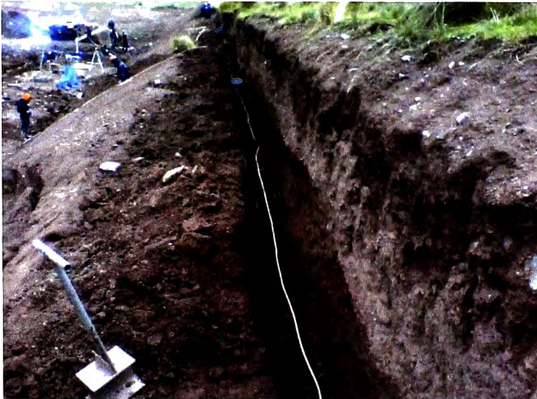
Figura N° 7.28: Fotografía, Instalación de malla a tierra profunda en talud de plataforma N° 3 Fuente: Propia, tomada en etapa de ejecución de obra.
