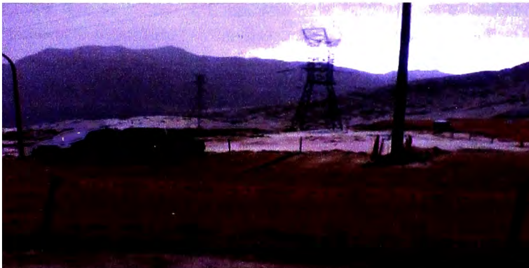
Figura N° 9.9: Fotografía, Constante caídas de granizadas y lluvias perjudican el avance de obra Fuente: Propia, tomada en etapa de ejecución de obra
