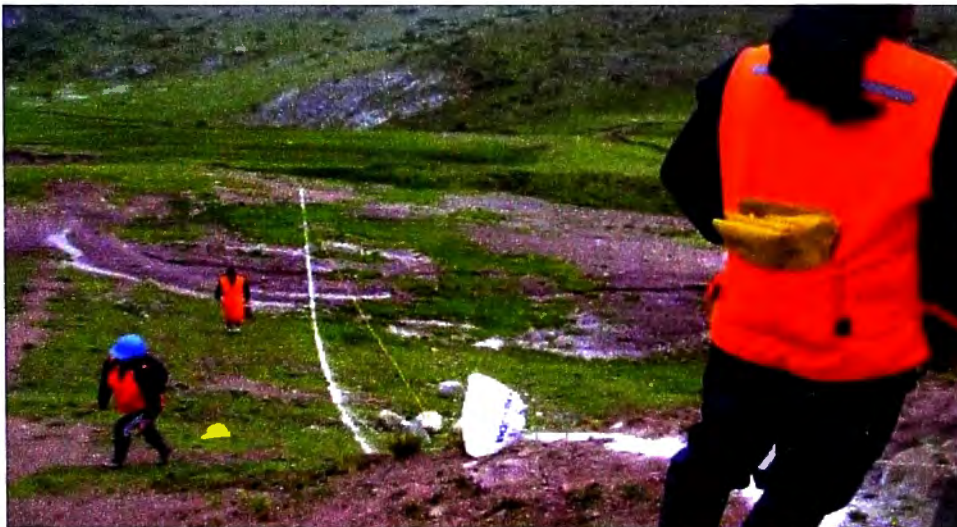
Figura N° 7.2: Fotografía Trazo en zona de ampliación para inicio de explanaciones. Fuente: Propia, tomada en etapa de ejecución de obra
