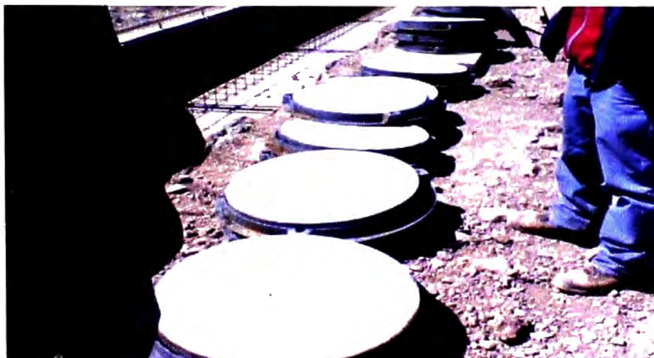
Figura N° 7.23: Fotografía, Tapas para ser instaladas en los buzones de drenaje Fuente: Propia, tomada en etapa de ejecución de obra.
