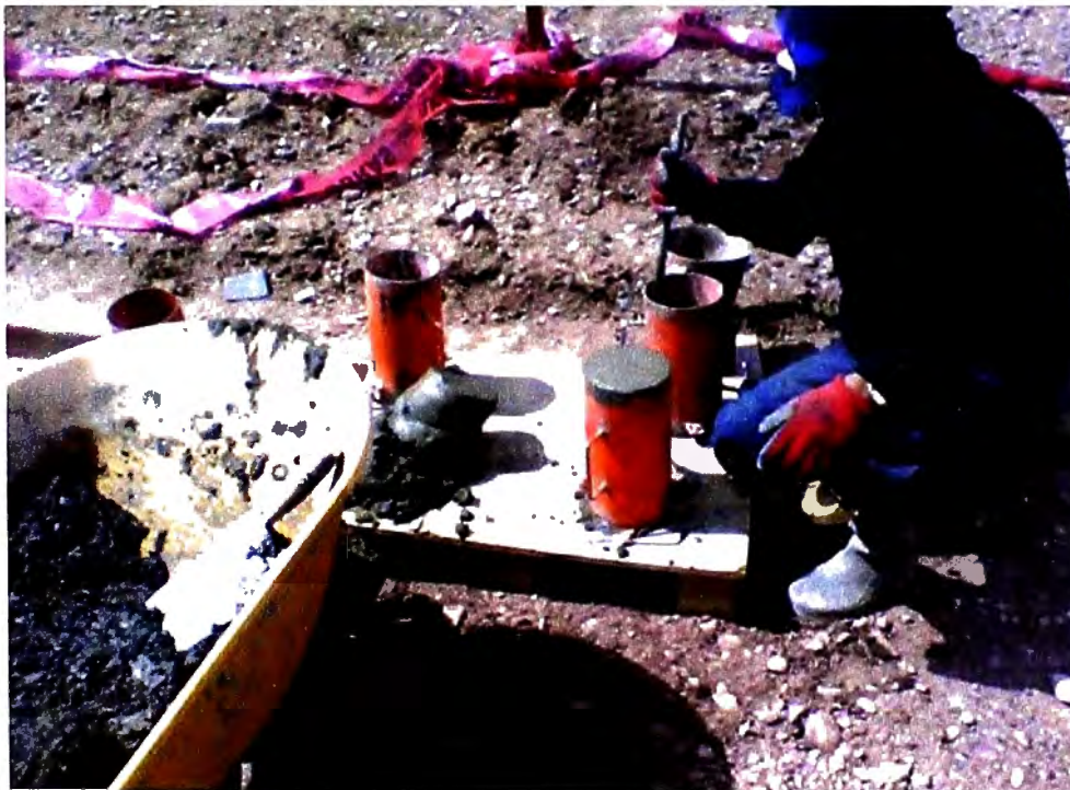
Figura N° 7.10: Fotografía, elaboración de probetas para ensayo de resistencia de concreto. Fuente: Propia, tomada en etapa de ejecución de obra
