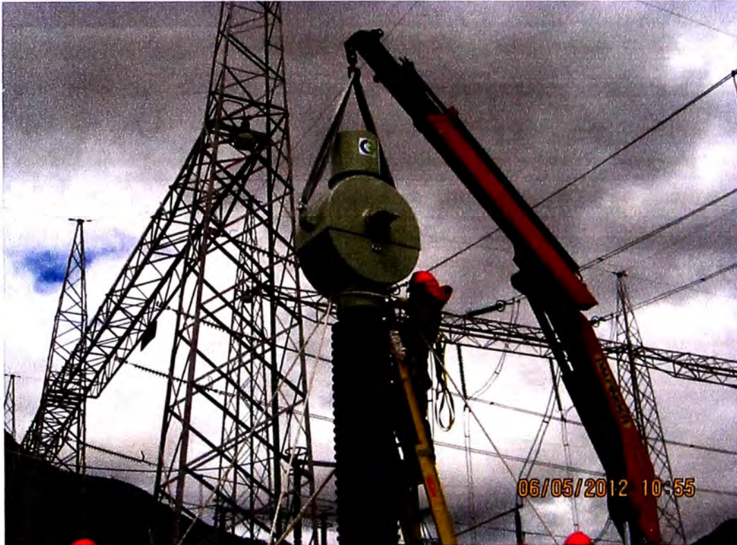
Figura N° 7.33: Fotografía, Instalación de equipos en plataforma N° 2. Fuente: Propia, tomada en etapa de ejecución de obra
