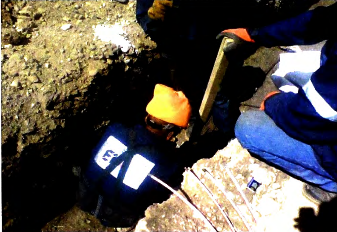
Figura N° 7.29: Fotografía, soldadura de cola con cable de cobre desnudo de 70mm 2 para cerco perimétrico.
