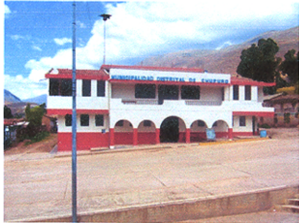
Palacio Municipal del distrito de Chupuro, donde se observa que no existe ninguna vegetación en su frentis.
