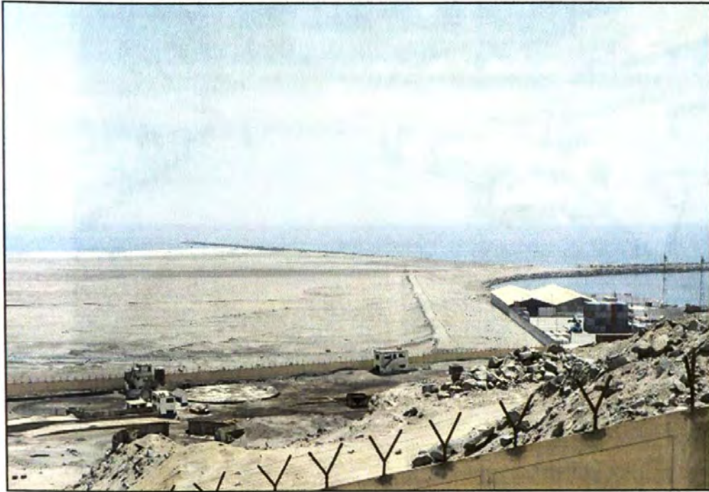
Fotografía 1.- Sedimentación al Sur del Molo Retenedor de arena
