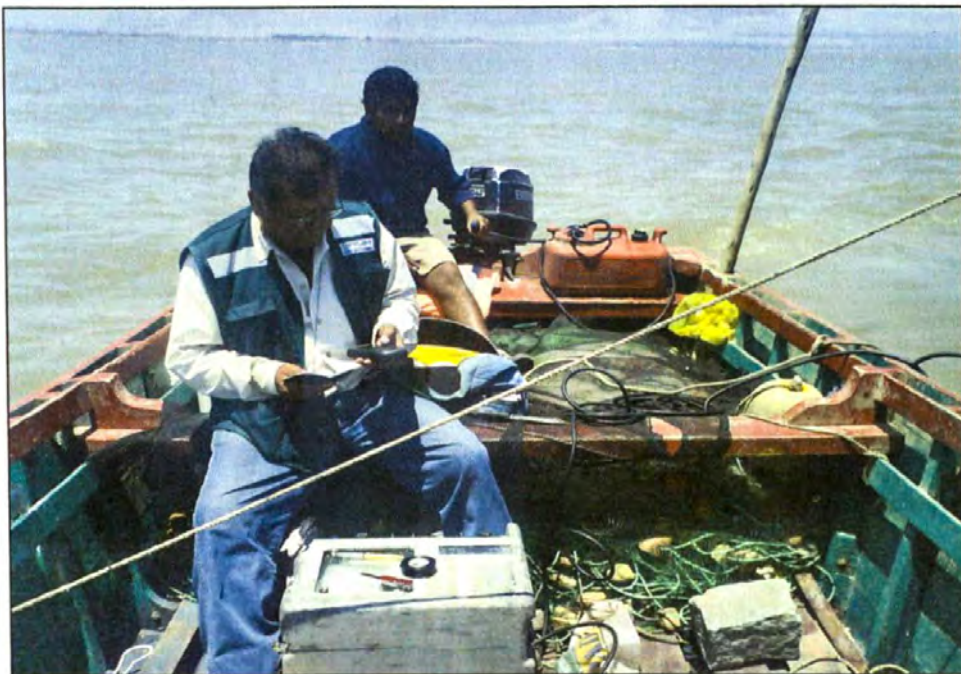
Fotografía 16-.Levantamiento batimétrico con ecosonda
