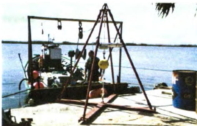
Figura 2.4.4.-Tetrápodos con el sistema PUV para medidas hidrodinámicas
