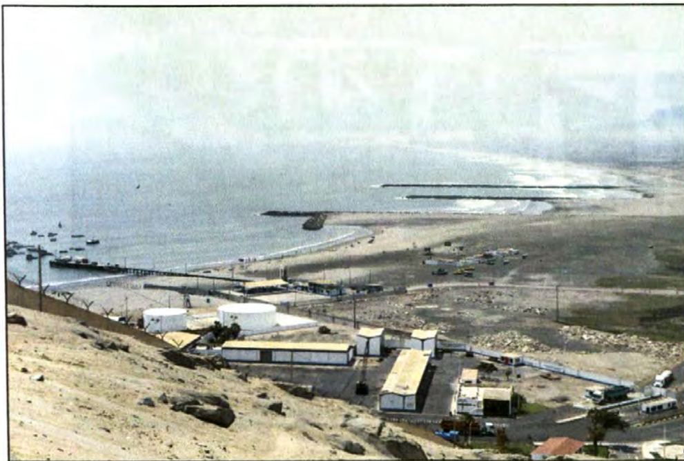
Fotografía 2.- Erosión al Norte del Molo Retenedor de arena
