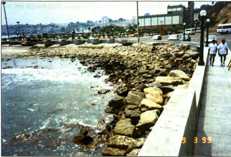
Figura 1.2 Pérdida de arena en la playa N° 3 del club Regatas sede Lima. Los materiales de acarreo que se observan provienen del sur
