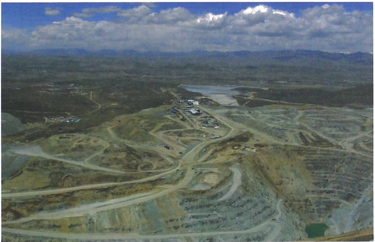
Vista del Tajo Tintaya e instalaciones
