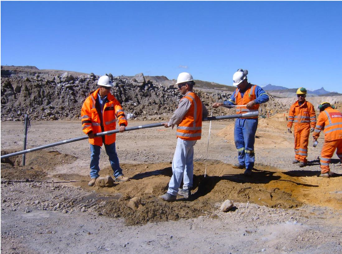
*Colocación del geófono triaxial T1 en Dafne 4080.*
