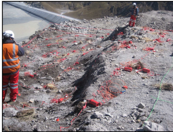
CUADRO 47: COLOCACIÓN DE MALLA GEOGRID
