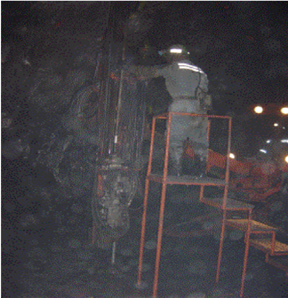
Lamina 20. Perforación del tajeo 775. Falla Socorro- Cuerpo Magaly
