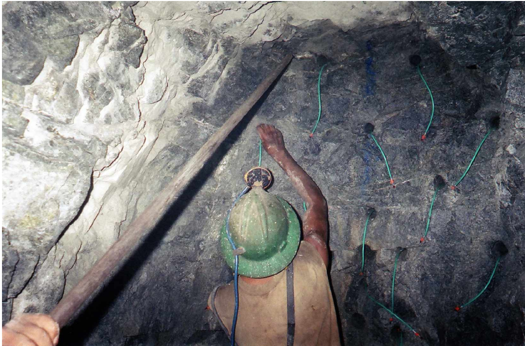
Figura 9. Pasos previos a la voladura de un frente.
