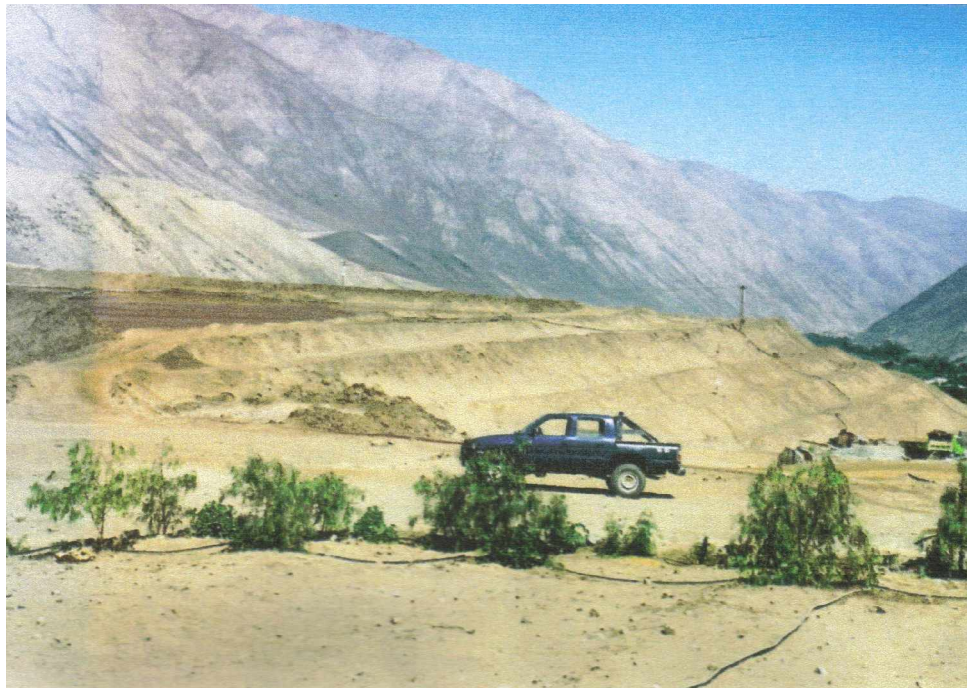
Foto 34. Cerco perimetrico con huaranguillo a la relavera
