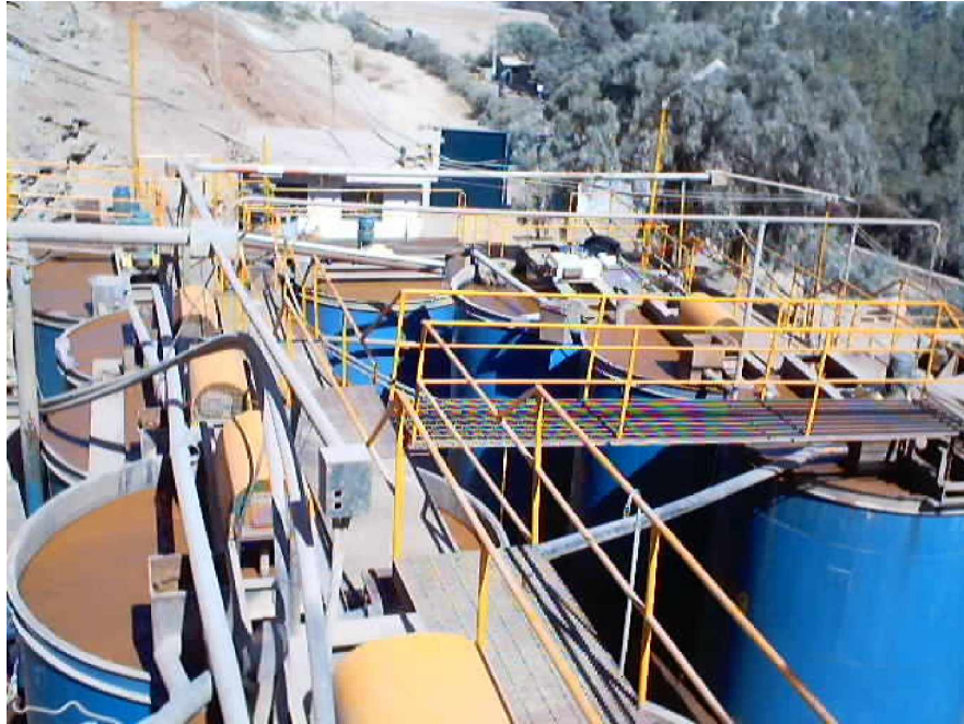
Foto 23. Tanques de Cianuración del mineral de oro.
