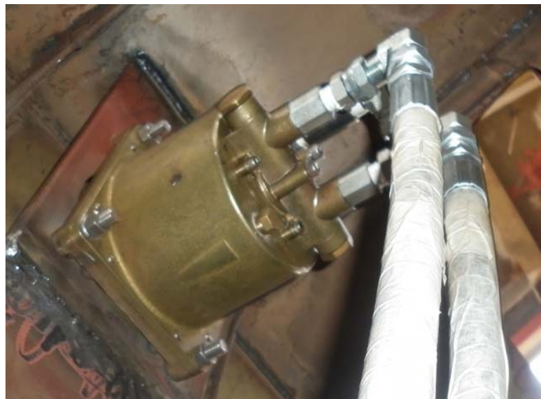
Figura 6.23 Muestra de la bomba manual ubicada en el puente de mando.
