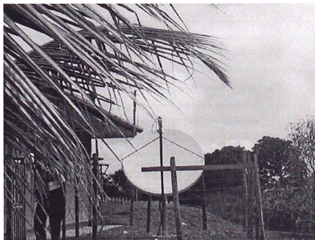
Figura N° 5: Antena VSAT instalada en una institución educativa rural
