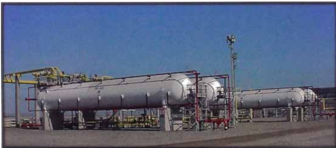
Gráfico N°18: Almacenamiento de Propano y Butano Presurizado
