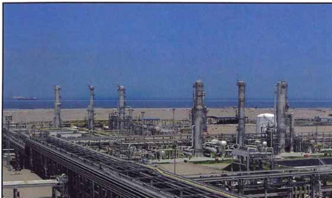
Gráfico N°16: Vista Panorámica de la Planta de Fraccionamiento de Pisco
