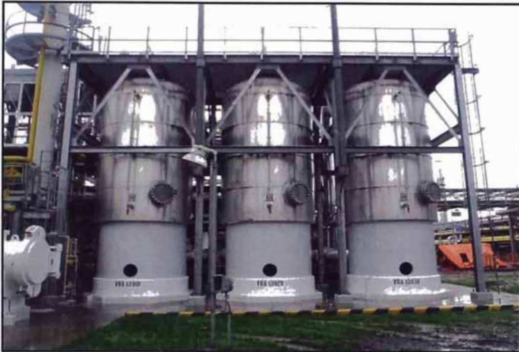
Gráfico N° 51: Torres de Adsorción de Tamiz Molecular en un Tren Criogénico
