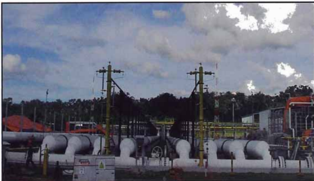
Gráfico N°44: Slug Catcher Tipo Tubería Horizontal – Planta Malvinas
