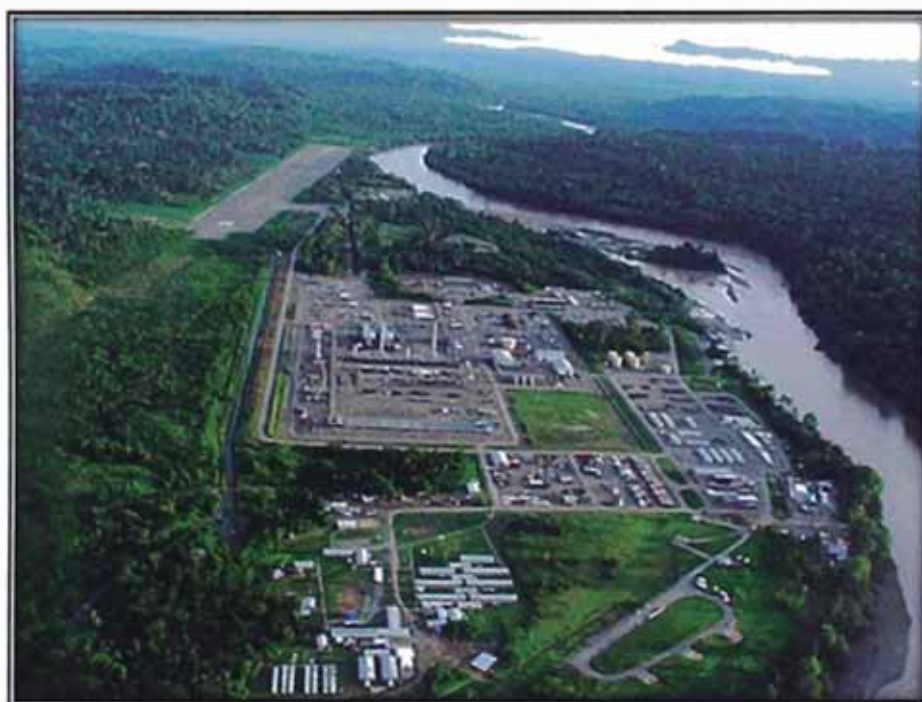
Gráfico N°12: Ubicación de la Planta de Gas Malvinas
