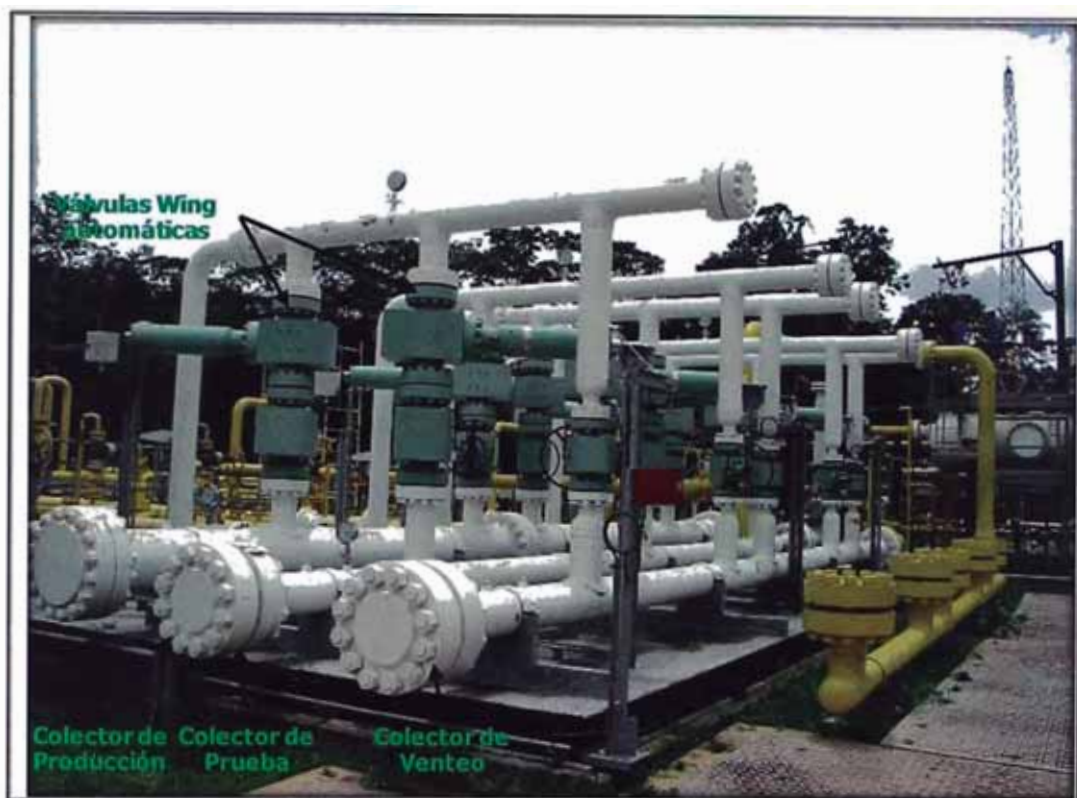
Gráfico N°28: Manifold de Producción - Cluster San Martín 1
