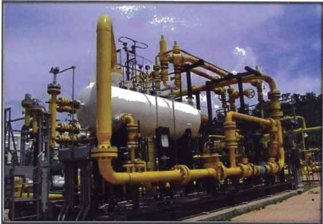
Gráfico N°30: Separador de Ensayo - Cluster San Martín 1
