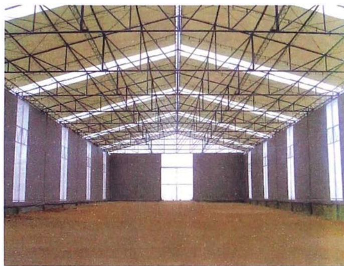
Fig. 02 Almacén en Yanacocha
